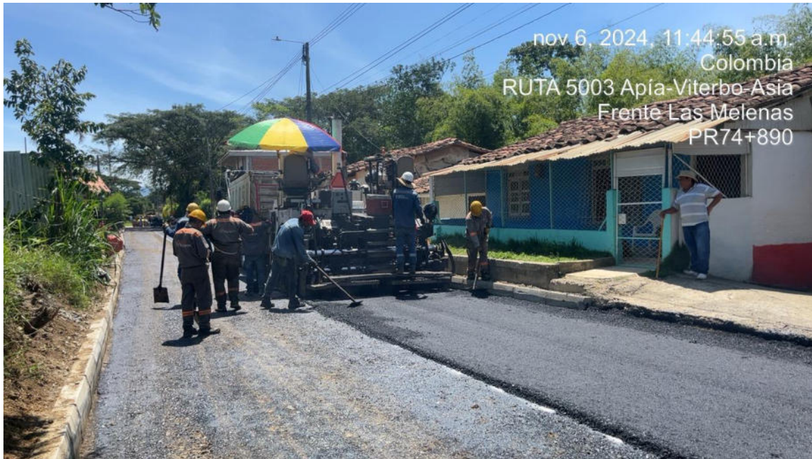
Fotografía 2: Jornada de asfalto PR 74+998-74+518 Sector Las Melenas
