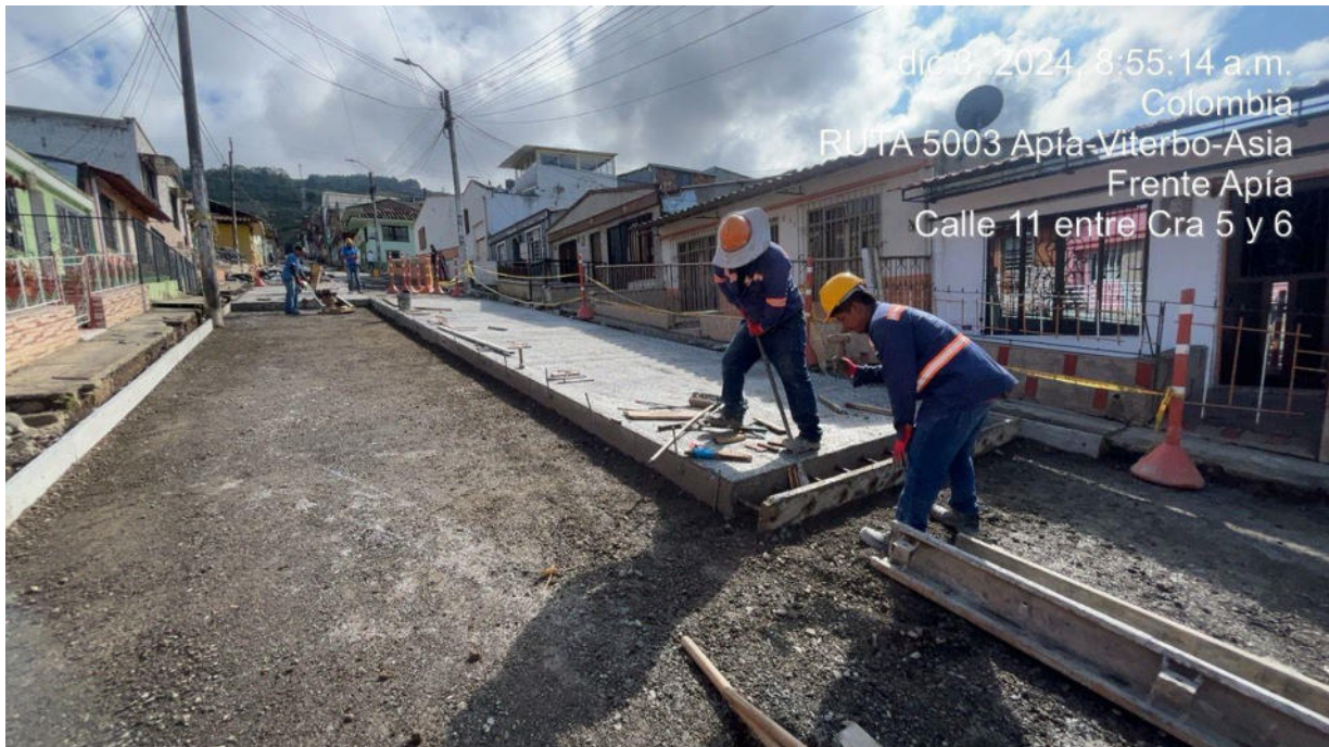
Fotografía 1: Actividades de obra ruta 5003 PR 58+800-58+590
