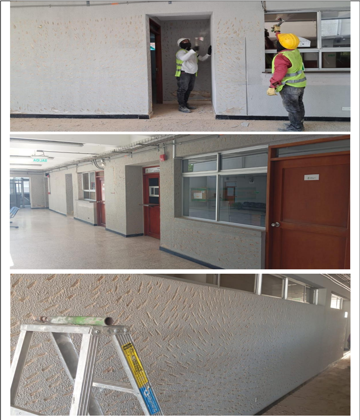
Pica y raspe de texturizado en fachadas internas. Piso 1
