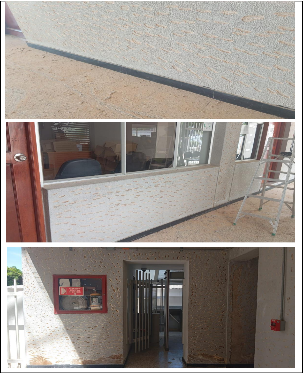
Pica y raspe de texturizado en fachadas internas. Piso 1
