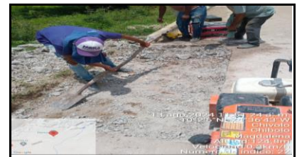
Tramo No. 1 - Demolicion de Losas
