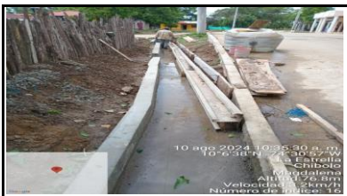
Construccion de Canal Longitudinal (Tramo 3)
