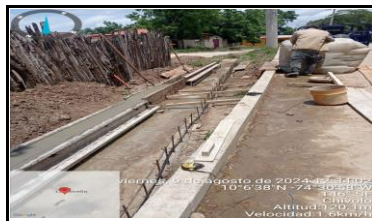
Construccion de Canal Longitudinal (Tramo 3)
