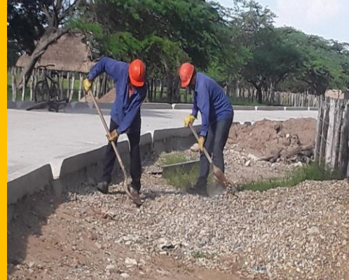
Trabajadores con EPP
