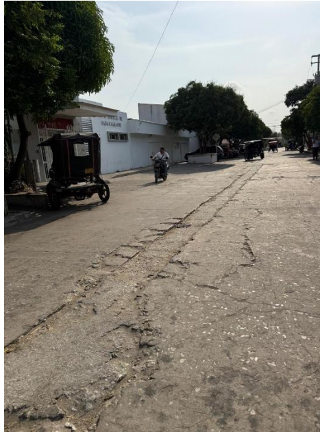
Fotografía No. 1. Estado actual.
