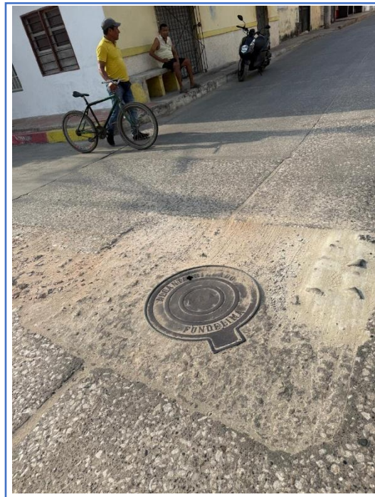
Fotografía No. 3. Estado actual.
