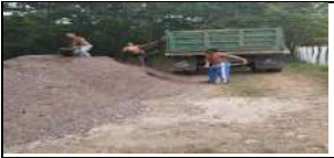
TRANSPORTE DE SUBBASE
