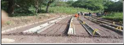
ARMADO DE PLACA HUELLA
