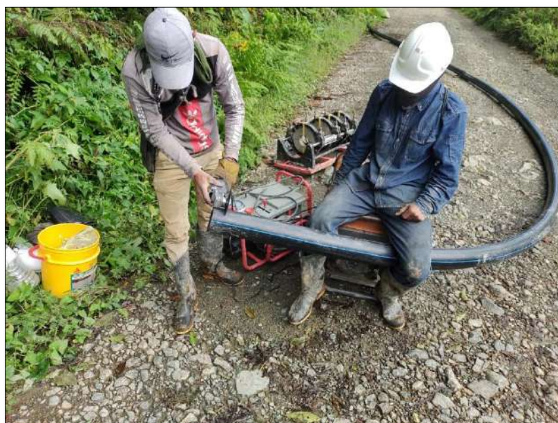
Fotografía No. 4 Instalación de tubería
