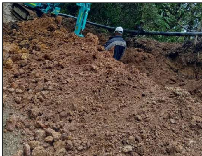
Fotografía No. 1 Instalación de tubería
