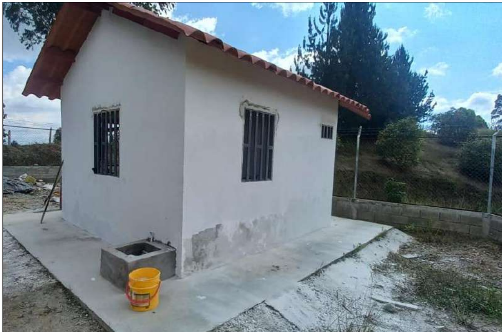
Fotografía No. 8 Obra Blanca Caseta de Operaciones
