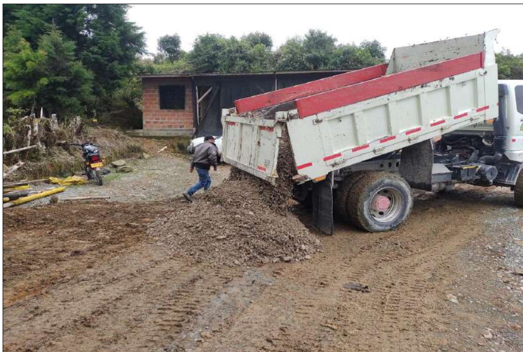
Fotografía No. 9 Instalación de afirmado
