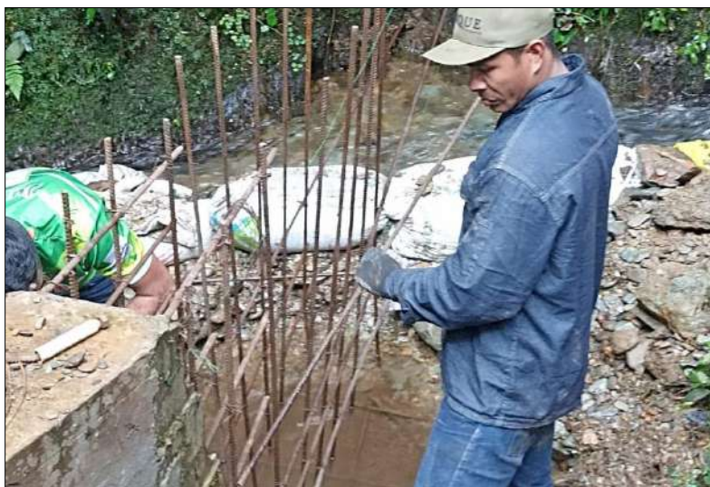
Fotografía No. 6 Instalación acero Aleta Bocatoma
