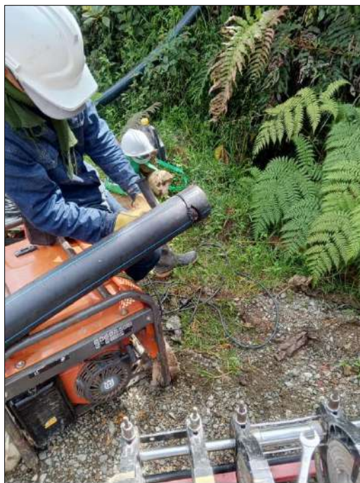
Fotografía No. 3 Instalación de tubería
