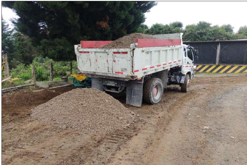
Fotografía No. 10 Instalación de afirmado
