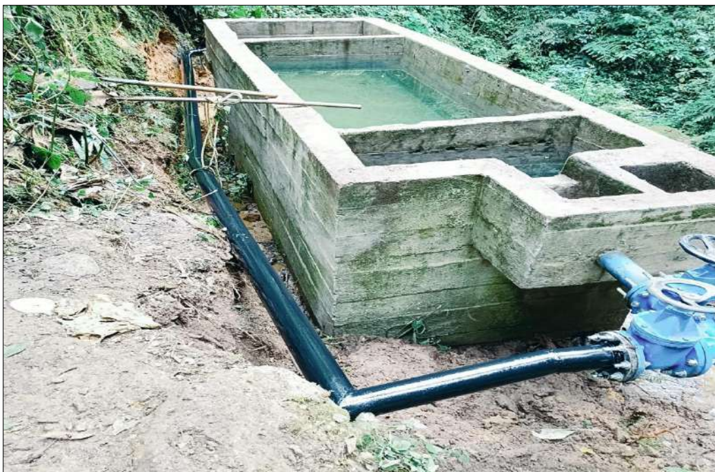
Fotografía No. 7 By Pass Desarenador
