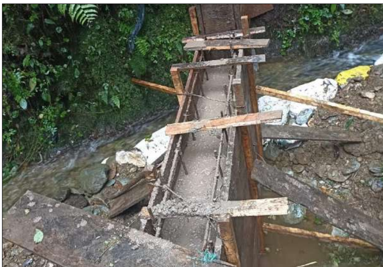
Fotografía No. 5 Aleta Bocatoma
