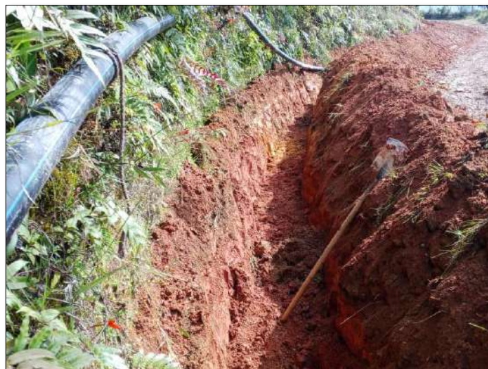
Fotografía No. 2 Instalación de tubería
