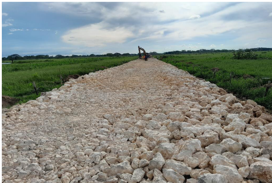
Fotografía N° 9. Conformación de pedraplén en Km 4+450.
