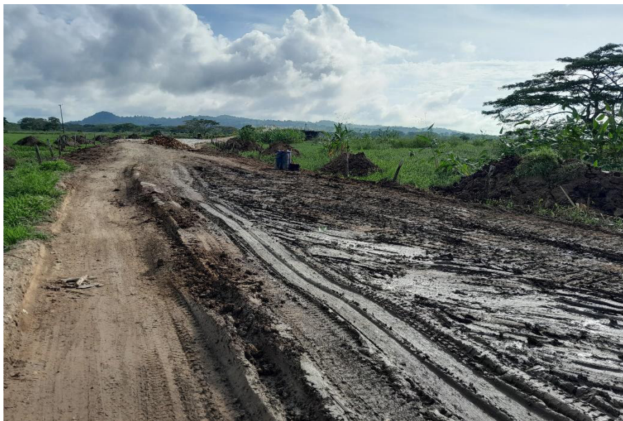
Fotografía N° 3. Retiro de materia orgánica previa conformación del pedraplén, Km 4+140.
