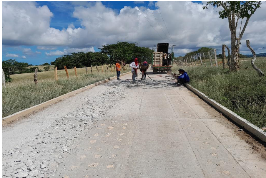
Fotografía N° 28. Demolición de losas que presentaron agrietamiento y/o descascaramiento en tramo tres.
