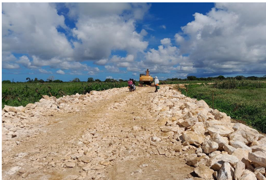
Fotografía N°12. Conformación de pedraplén en Km 4+890.
