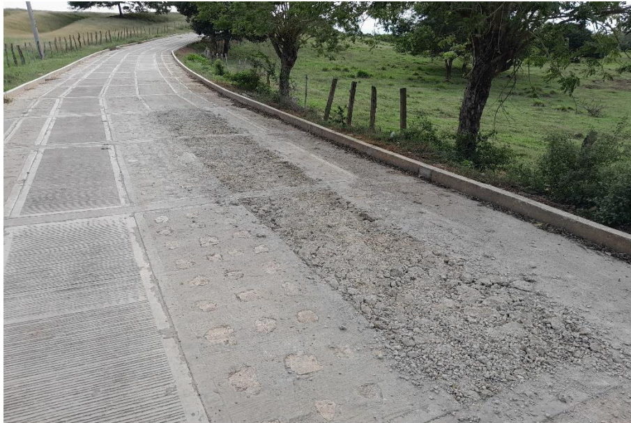
Fotografía N° 26. Demolición de losas que presentaron exposición de agregados y segregación en tramo tres.
