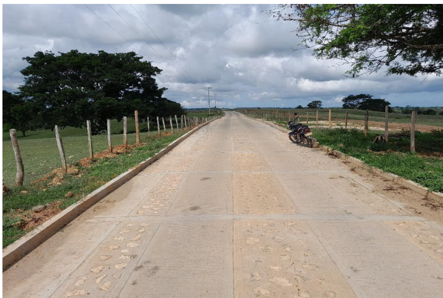
Fotografía N° 29. Placa huella tramo cuatro. Km 8+576.
