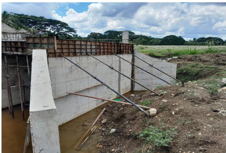
Fotografía N° 20. Estructura Box culvert en Km 13+346.
