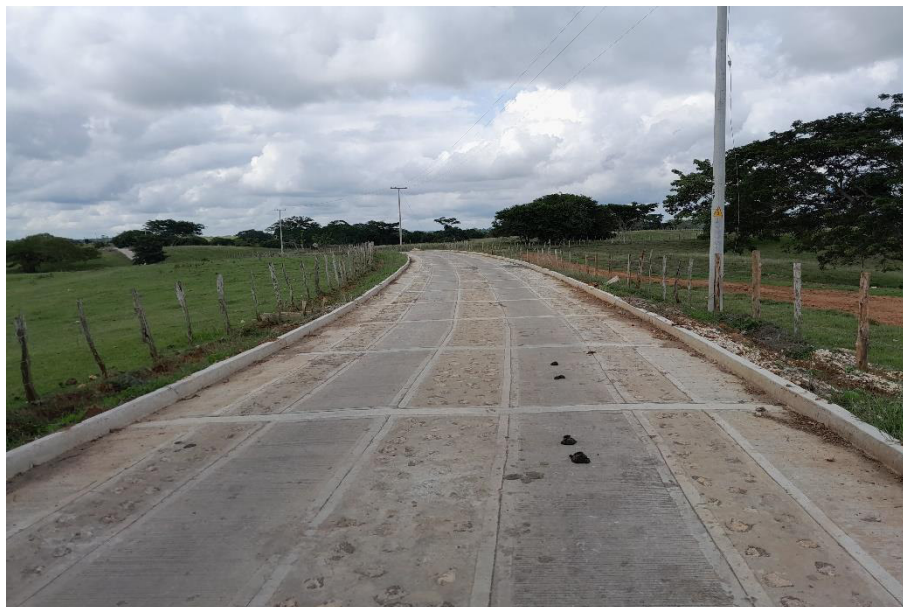
Fotografía N° 31. Placa huella tramo cuatro. Km 8+830.
