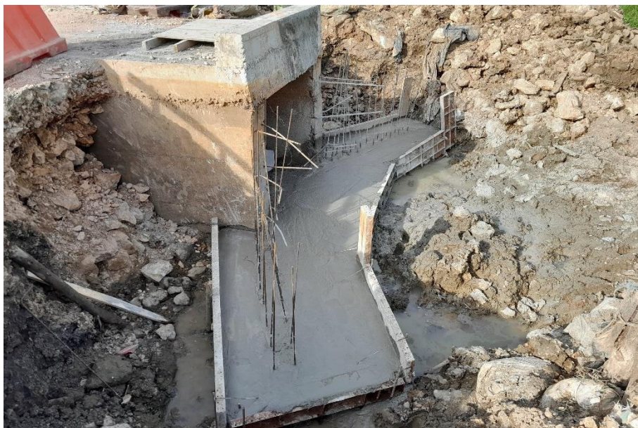
Fotografía N°13. Zapatas de aletas box culvert Km 3+305.
