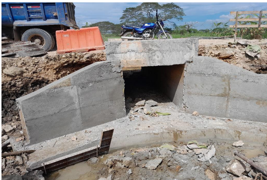
Fotografía N°14. Aletas box culvert Km 3+305.
