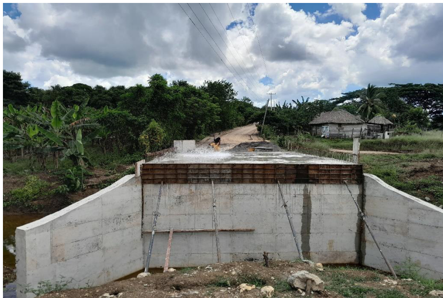
Fotografía N°19. Estructura Box culvert en Km 13+346.
