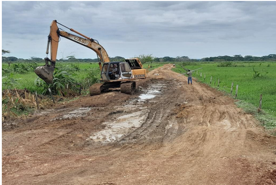
Fotografía N° 5. Retiro de materia orgánica previa conformación del pedraplén, Km 4+330.
