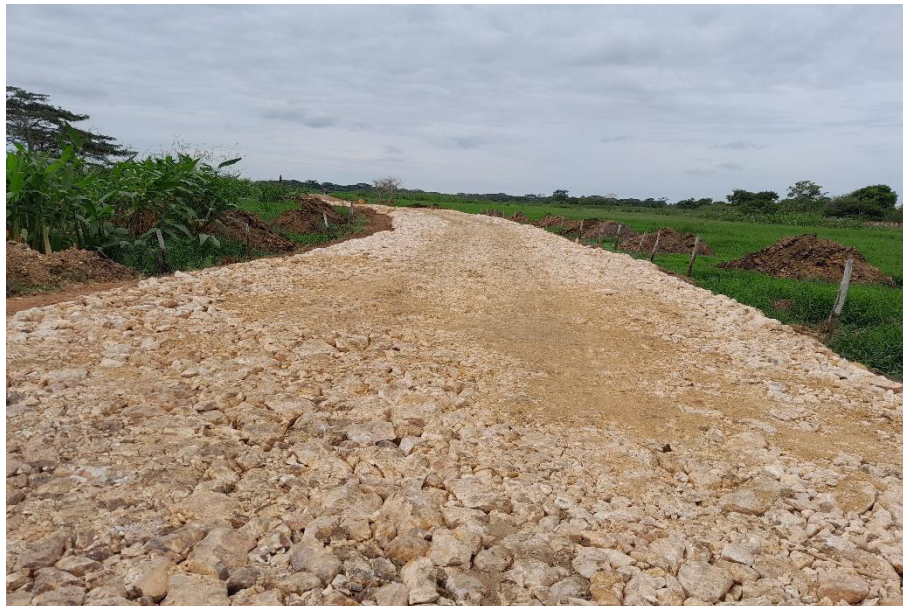
Fotografía N° 6. Conformación de pedraplén en Km 4+150.
