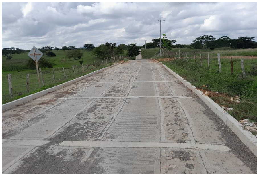
Fotografía N° 32. Placa huella tramo cuatro. Km 8+932
