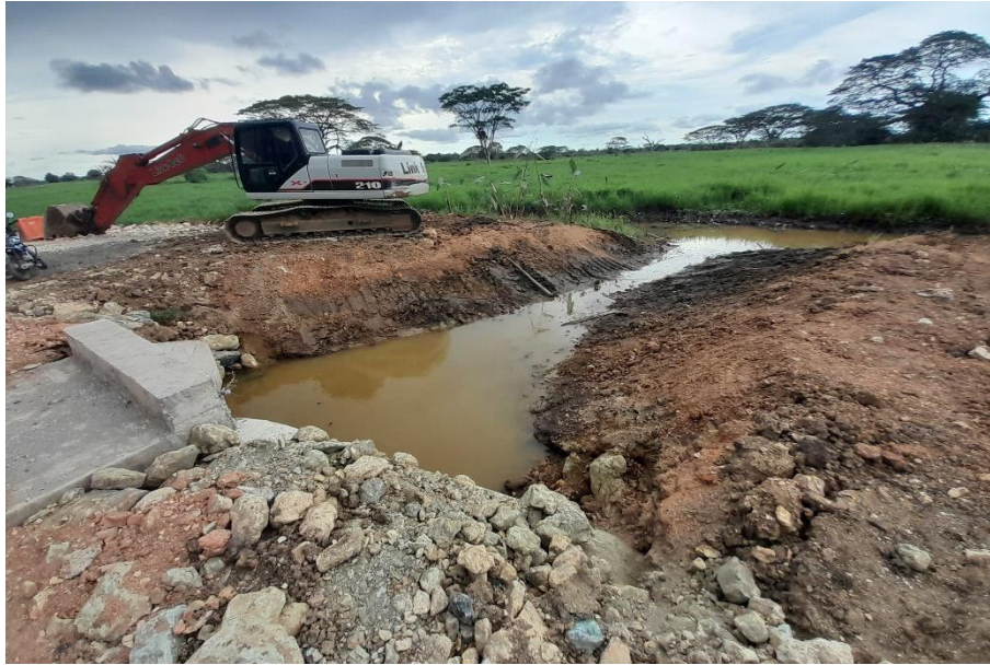
Fotografía N°15. Descoles en box culvert Km 3+305.
