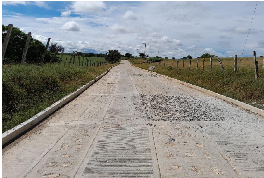
Fotografía N° 27. Demolición de losas que presentaron agrietamiento y/o descascaramiento en tramo tres.
