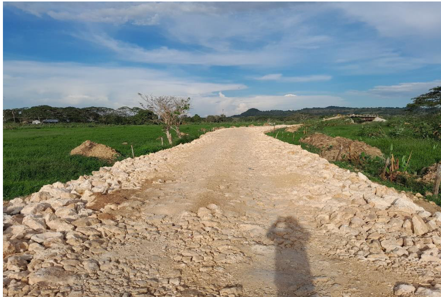
Fotografía N° 7. Conformación de pedraplén en Km 4+290.
