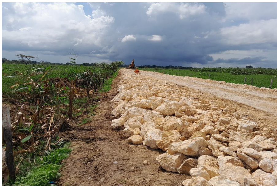
Fotografía N°8. Conformación de pedraplén en Km 4+330.
