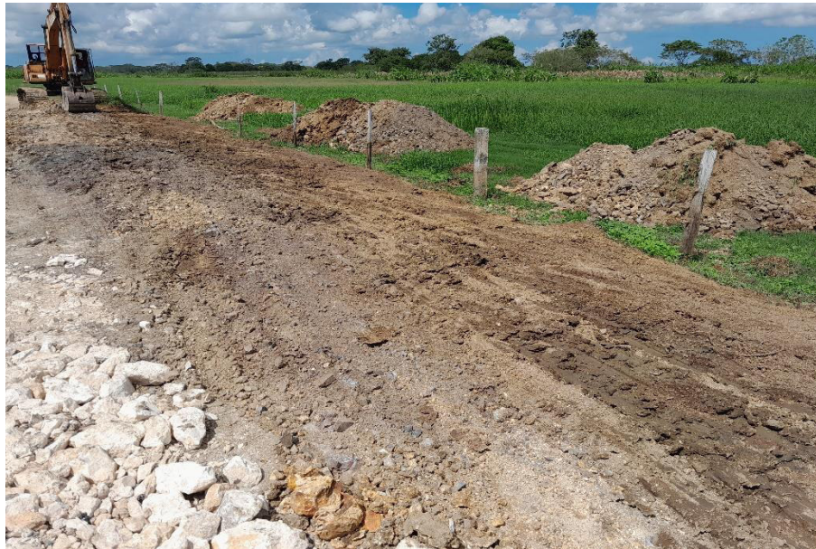
Fotografía N° 3. Retiro de materia orgánica previa conformación del pedraplén, Km 4+140.
