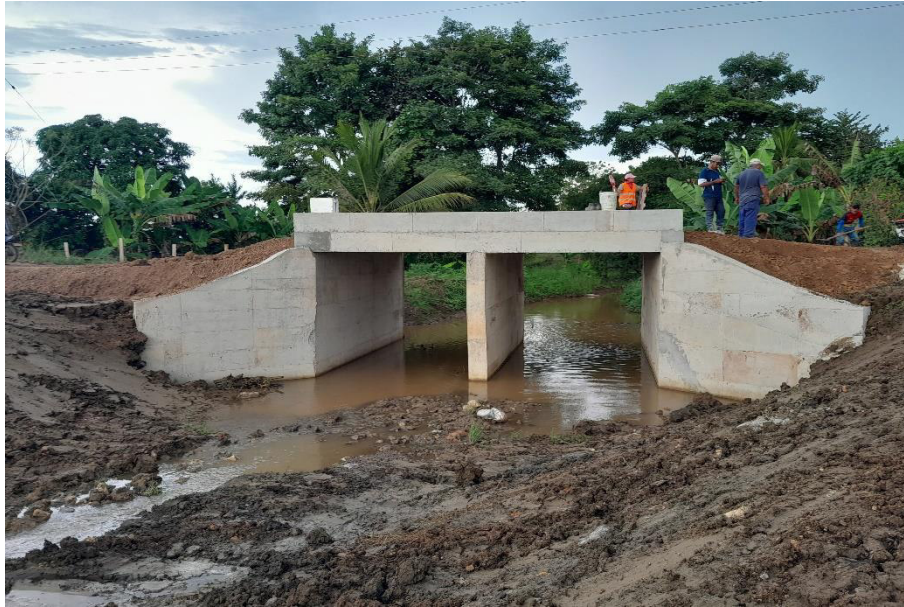
Fotografía N° 21. Estructura Box culvert en Km 13+346.
