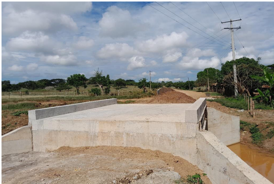
Fotografía N° 22. Relleno para estructuras en box culvert en Km 13+346.
