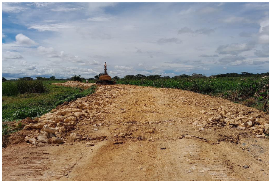
Fotografía N°11. Conformación de pedraplén en Km 4+700.
