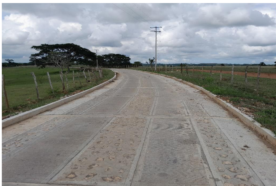
Fotografía N° 30. Placa huella tramo cuatro. Km 8+720.
