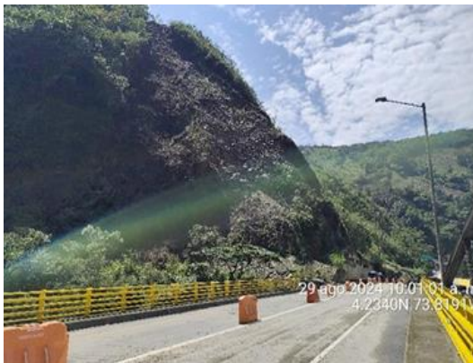
IMAGEN 2 Señalización de Obra.
