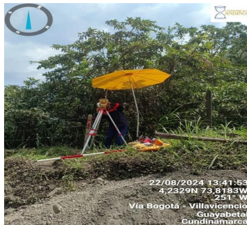
IMAGEN 9 Localización y Replanteo
