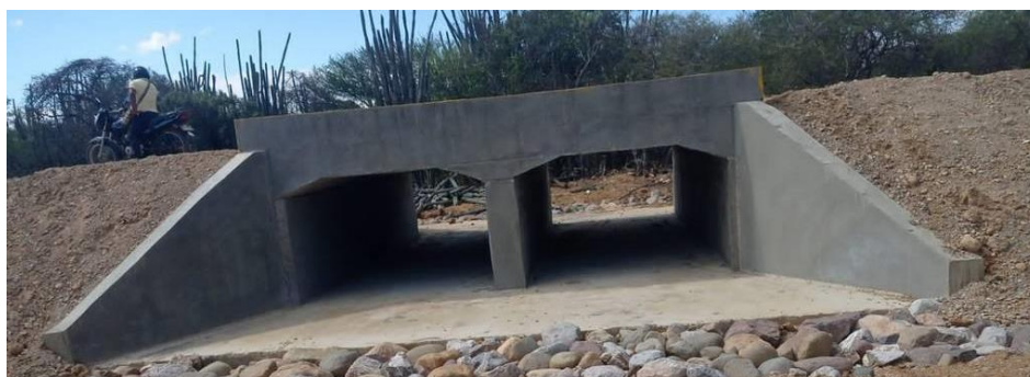
Figura 7. Registro Fotográfico Drenaje
