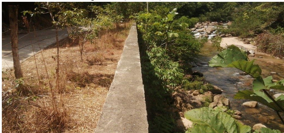
Figura 9. Registro Fotográfico Muros
