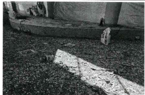
Se realiza recoleccion de escombros para retiro de material
