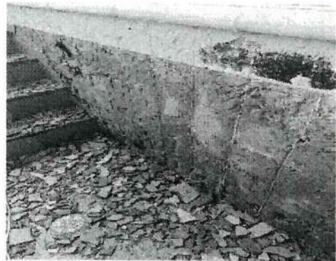
Se realiza actividades demolicion
