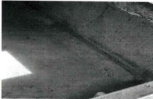
Se realiza impermeabilizacion de tanques
