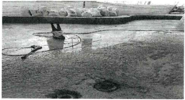
Se realiza actividad de limpieza
