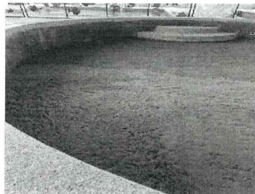
Se realiza reparacion de grietas y fisuras
