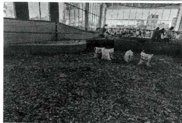
Se inicia realizar materiales de escombros en lonas
