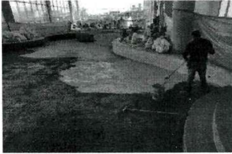
Se realiza impermeabilizacion de toda la superficie
