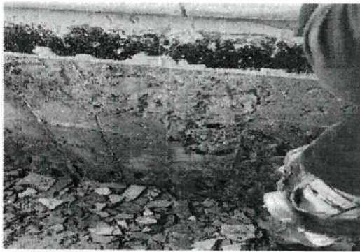
Se realiza retiro de varias capas de pañete y otros productos
