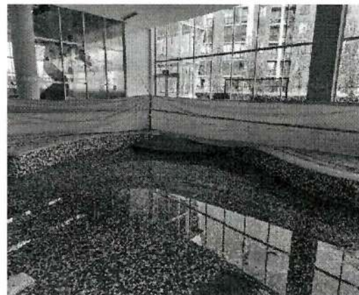
Instalacion proteccion de polisombra en el area de trabajo
