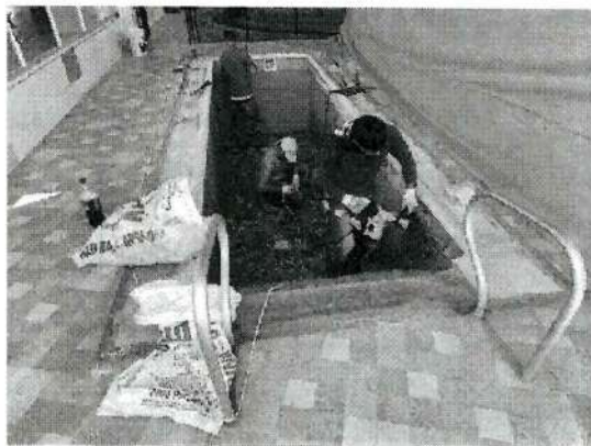
Se inicia actividad demolicion enchape
