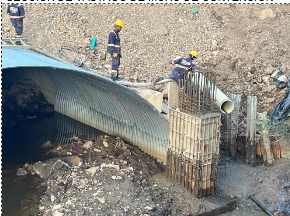
VARIANTE ZIPAQUIRÁ, OBRA No 19, FUNDIDA DE 2da SECCIÓN DE COLUMNA ORIENTAL DE PÓRICO DE SALIDA DE ARCO METÁLICO
