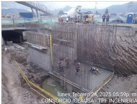
VARIANTE ZIQAQUIRÁ, OBRA No 19, FUNDIDA DE PLACA INFERIOR DE MÓDULO 3 DE CANAL DE ACCESO
