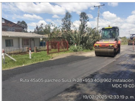
PARCHEO RUTA 45 A 05, SUSÁ, PR28+0953 - PR28+0962, FRESADO E INSTALACIÓN DE MDC-19
