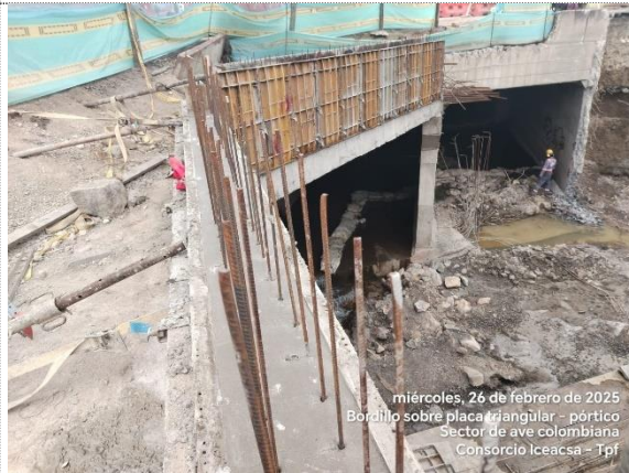
VARIANTE ZIQAQUIRÁ, OBRA No 19, FUNDIDA DE BORDILLO SOBRE PÓRTICO DE TRANSICIÓN Y PLACA TRIANGULAR, COTA BAJA
