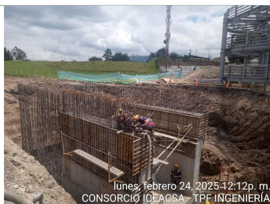
Obra No 19, fundida de 4ta sección de muros de módulo 2 de canal de acceso (24/02/25)
