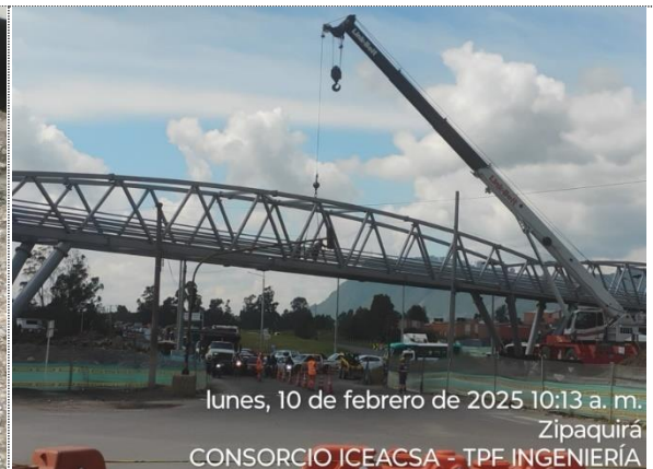
VARIANTE ZIQAQUIRÁ, PUENTE PEATONAL, INSTALACIÓN DE PLACA ALVEOLAR EN PASARELA DE PILA 2 Y 3
