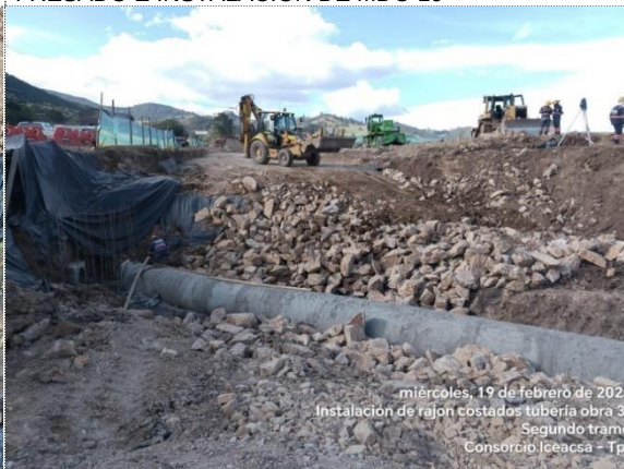
TRAMO 2, K44+180 OBRA No 31, INSTALACIÓN DE TUBERÍA 900mm
