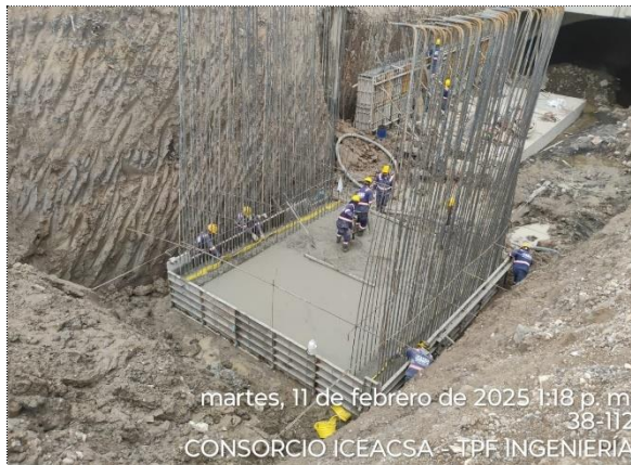
VARIANTE ZIQAQUIRÁ, OBRA No 19, FUNDIDA DE PLACA INFERIOR DE MÓDULO 1 DE CANAL DE ACCESO
