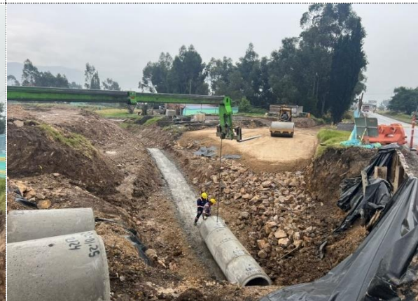
TRAMO 2, OBRA No 31, INSTALACIÓN DE TUBERÍA 900mm
