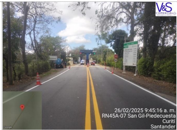
DEMARCACIÓN RUTA 45 A 07, SAN GIL - CURITÍ, PR5+0800 - PR11+0320, DOBLE LÍNEA AMARILLA DE EJE
