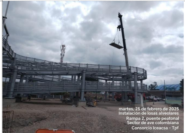
VARIANTE ZIQAQUIRÁ, PUENTE PEATONAL, INSTALACIÓN DE PLACAS ALVEOLARES EN RAMPA 2
