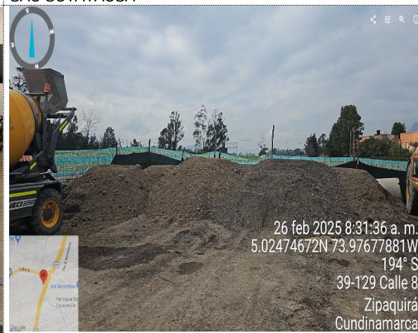
INSPECCION MATERIAL DE FRESADO CAMPAMENTO
