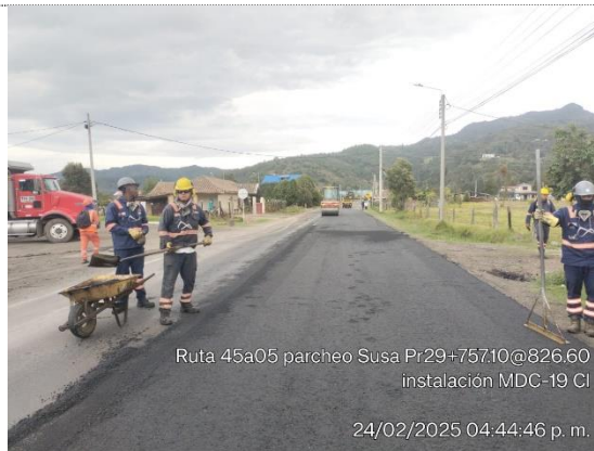
PR29+0757 – PR29+0826, Susa, fresado e instalación de MDC-19 (24/02/25)
