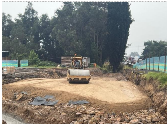
TRAMO 2, K44+160 - K44+180, INSTALACIÓN DE GEOTEXTIL Y 1er CAPA DE TERRAPLEN
