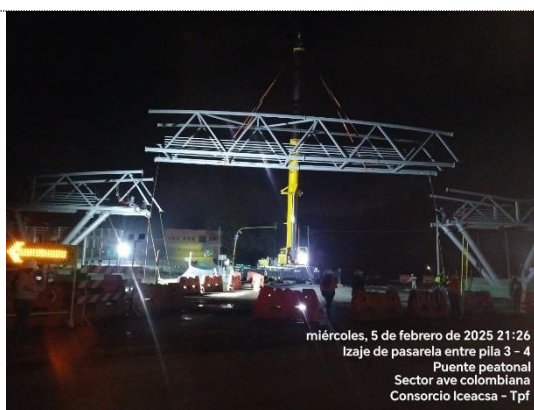
Puente peatonal, izaje de pasarela entre pilas 3 y 4 (05/02/25)
