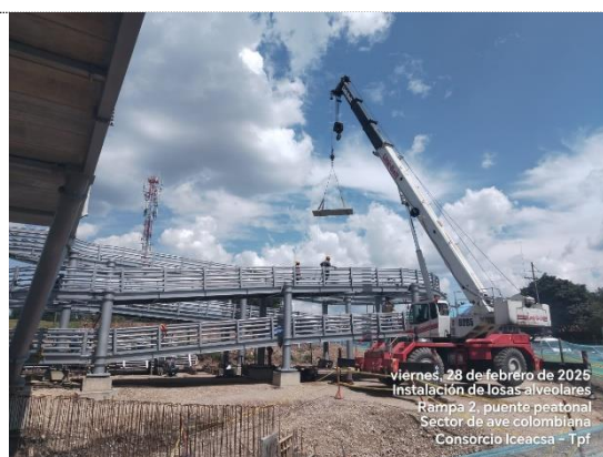
Puente peatonal, instalación de placas alveolares en rampa 2 (28/02/25)
