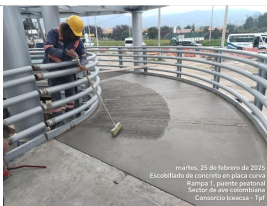
Puente peatonal, fundida de placa curva de rampa 1 (25/02/25)
