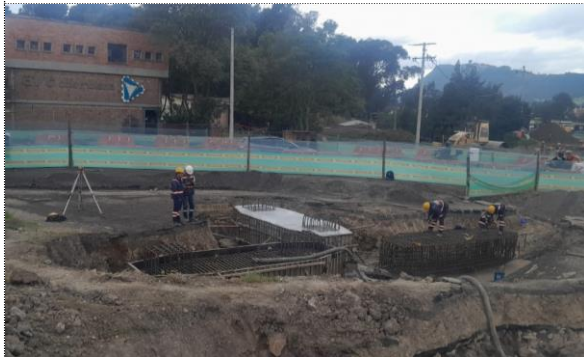
VARIANTE ZIPAQUIRÁ, PUENTE PEATONAL, FUNDIDA DE DADO DE PILOTE P
