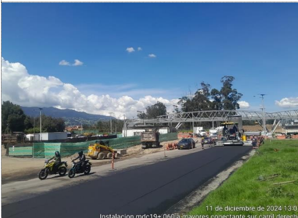
VARIANTE ZIQAUIRÁ, CONECTANTE SUR, K0+060 - K0+100 INSTALACIÓN DE MDC-19 CARRIL DERECHO
