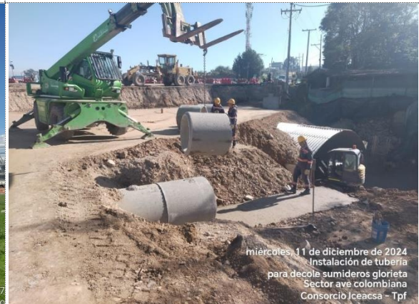
VARIANTE ZIQAUIRÁ, GLORIETA, INSTALACIÓN DE TUBERÍA 900mm PARA DESCOLE DE SUMIDEROS DE GLORIETA.
