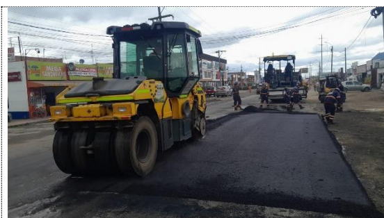
PR28+0764 – PR28+0776, carrera 36, fresado e instalación de MDC-19 (17/12/24)
