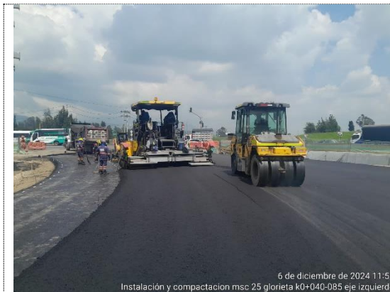
Glorieta, K0+040 – K0+085 instalación de MSC-25 (10/12/24)
