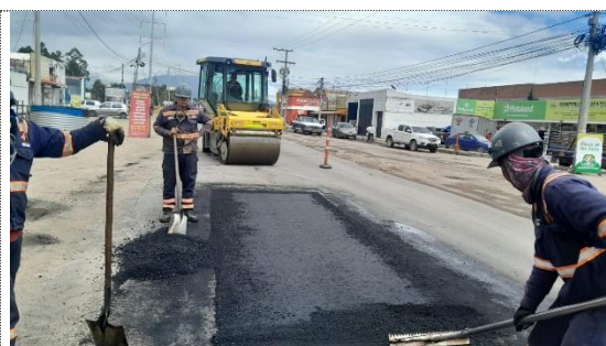
PR28+0695 – PR28+0701, carrera 36, fresado e instalación de MDC-19 (17/12/24)
