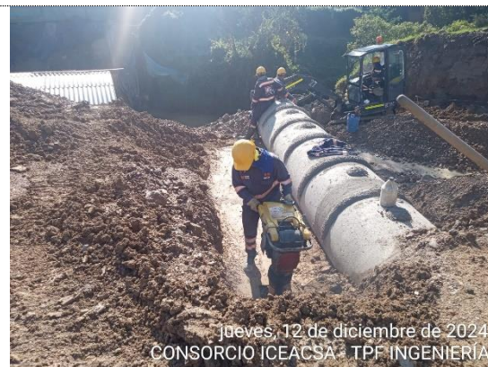
Glorieta, instalación y atraque de tubería 900mm para descole de sumideros de glorieta (12/12/24)
