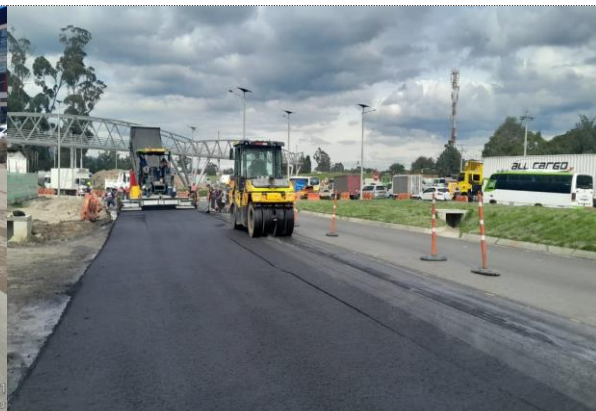
VARIANTE ZIPAQUIRÁ, CONECTANTE SUR, K0+025 - K0+080, INSTALACIÓN DE MDC-19 CARRIL IZQUIERDO
