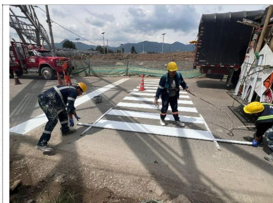
Variante Zipaquirá, K2+750, glorieta Ave Colombiana, Línea de pare y cruce peatonal (12/12/24)
