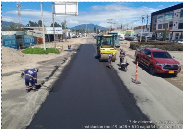
BACHEO RUTA 45 A 04, CARRERA 36, PR28+0574 - PR28+0610, FRESADO E INSTALACIÓN DE MDC-19
