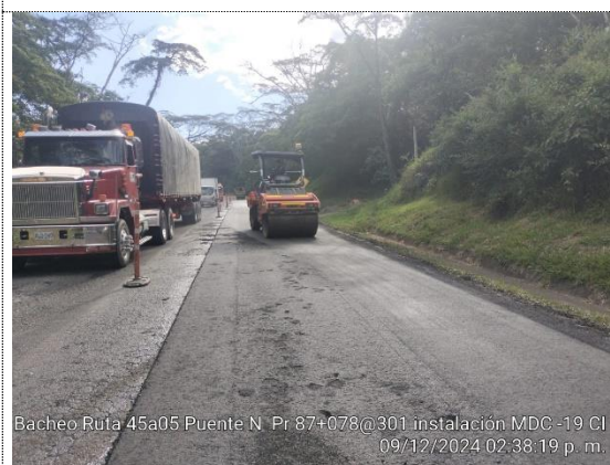
PR87+0078 – PR887+0301, Puente Nacional, fresado e instalación de MDC-19 (09/12/24)
