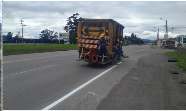
DEMARCACIÓN RUTA 45 A 04, PR33+0291 - PR35+0542, DEMARCACIÓN DE LÍNEA BLANCA DE BORDE
