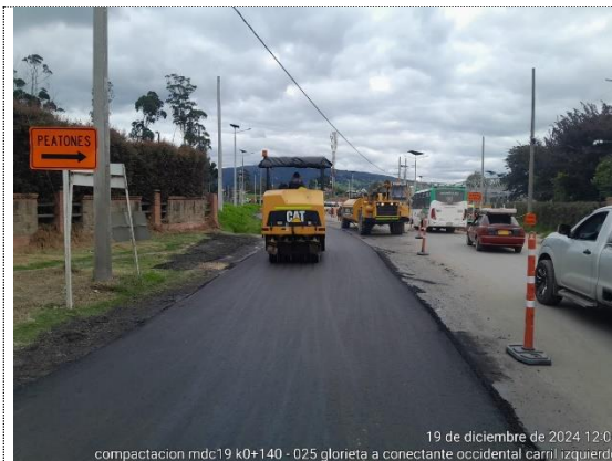
Conectante occidental, K0+025 – K0+140 instalación y compactación de MDC-19 carril izquierdo (19/12/24)
