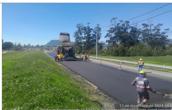
VARIANTE ZIQAUIRÁ, CONECTANTE NORTE, K0+315 - K0+480 INSTALACIÓN DE MDC-19 CARRIL IZQUIERDO
