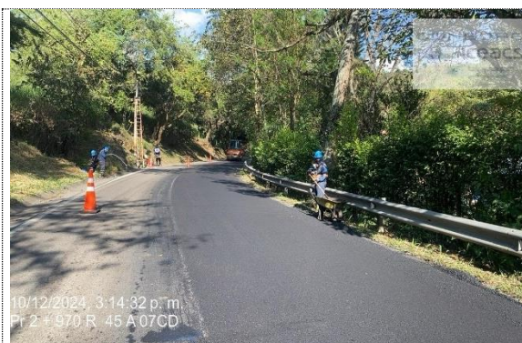
BACHEO RUTA 45 A 07, SAN GIL, PR2+0970, INSTALACIÓN DE MDC-19
