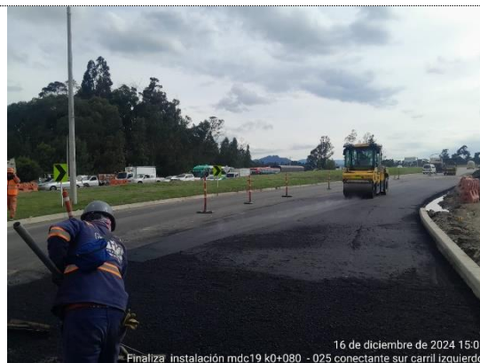
Conectante sur, K0+025 – K0+080 instalación de MDC-19 (16/12/24)
