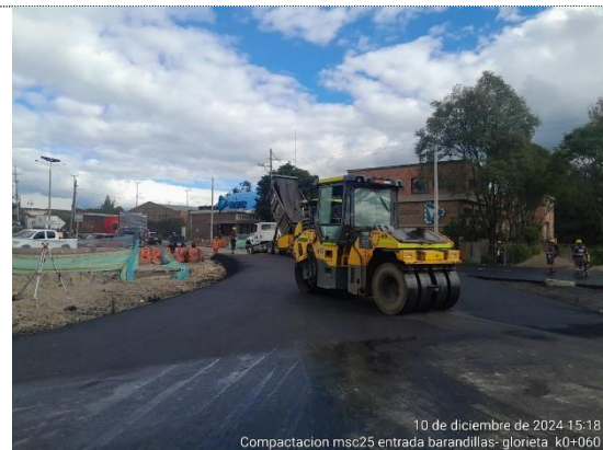
Conectante oriental a Glorieta, instalación de MSC-25 (10/12/24)
