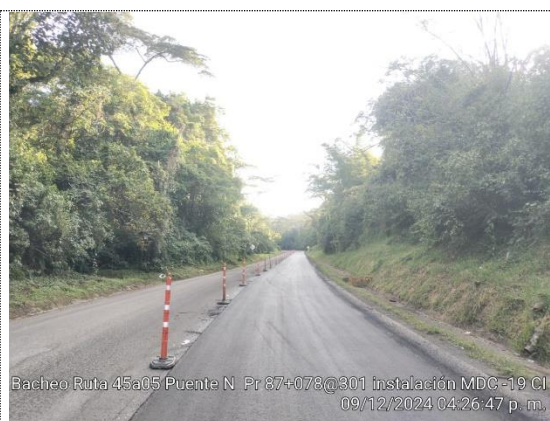
PR87+0078 – PR887+0301, Puente Nacional, fresado e instalación de MDC-19 (09/12/24)
