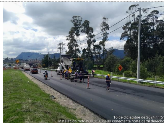
Conectante norte, K0+315 – K0+380 instalación de MDC-19 (16/12/24)
