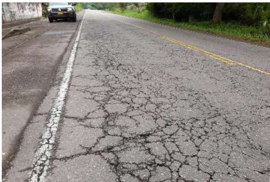
Fotografía 2: Desgaste carpeta asfáltica, fisuras, deflexiones, piel de cocodrilo, PR 2+200 – PR 3+500
