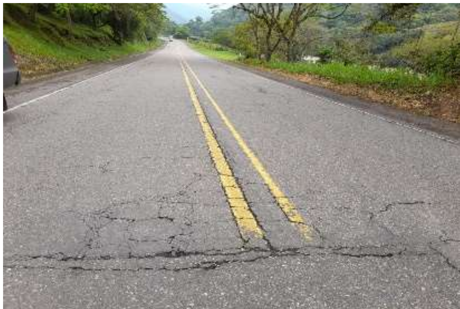
Fotografía 4: Parcheo localizado, baches localizados, existen filtro, mejoramiento de señalización, PR 1+000 – PR 3+000 RUTA 2003A
