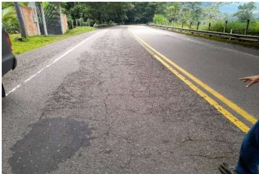
Fotografía 32: Tramo en buen estado, existe resalto en PR 64+890. Puente Yarumal PR 64+150, puente, Villa Paz PR 64+500, puente Secreto PR 64+730; PR 63+450 – PR 65+000.
