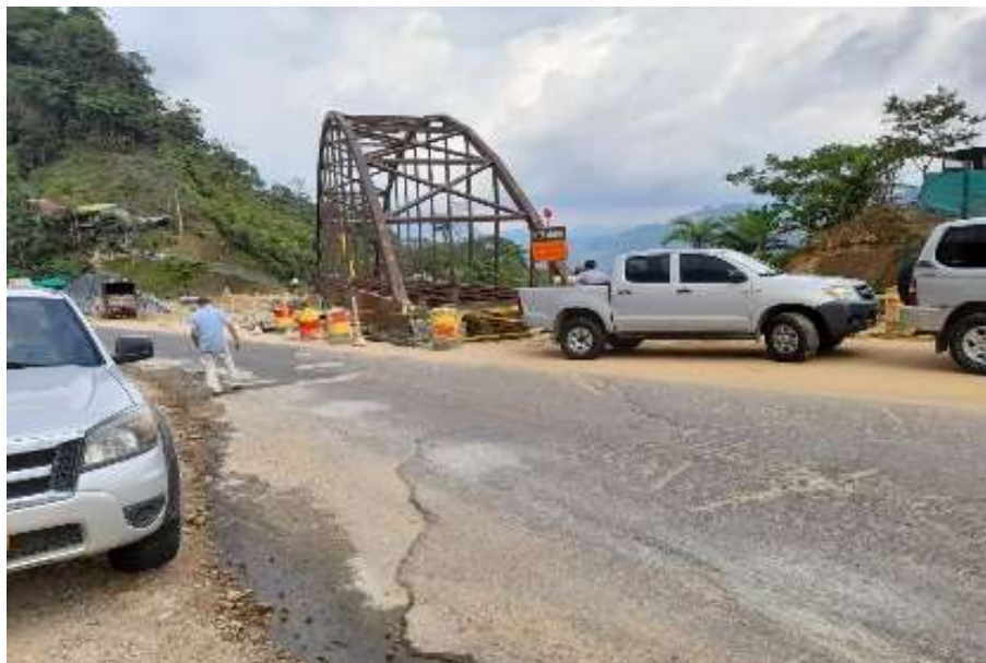
Fotografía 31: Zona en intervención, se construye puente metálico PR 63+300.
