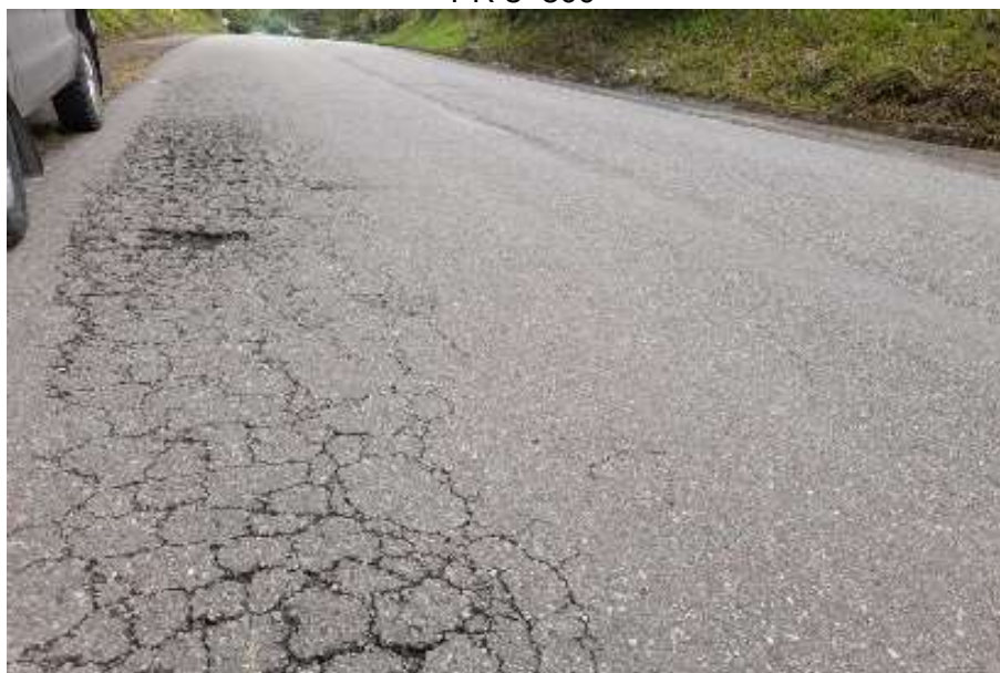
Fotografía 2: Desgaste carpeta asfáltica, fisuras, deflexiones, piel de cocodrilo, PR 2+200 – PR 3+500
