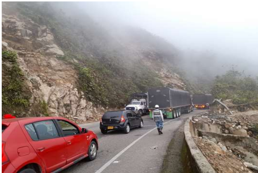
Fotografía 20: Sitio crítico; derrumbe talud superior. Evaluar para posible intervención PR 44+800 – PR 44+900.
