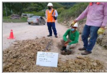
Aliques para estructura de pavimento existente en los tramos a intervenir.
