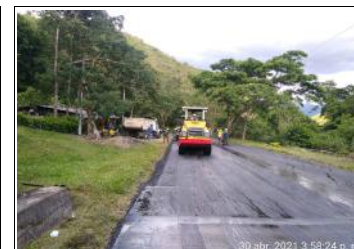
Actividad de compactación de la carpeta asfáltica.
