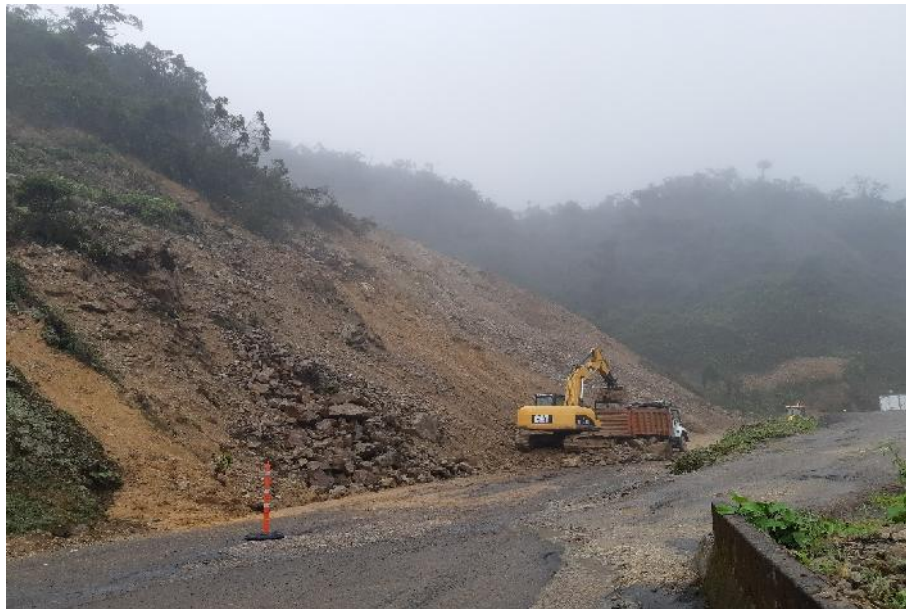
Fotografía 12: Remoción y retiro de material proveniente de derrumbe PR 42+800 Ruta 2003 A.
