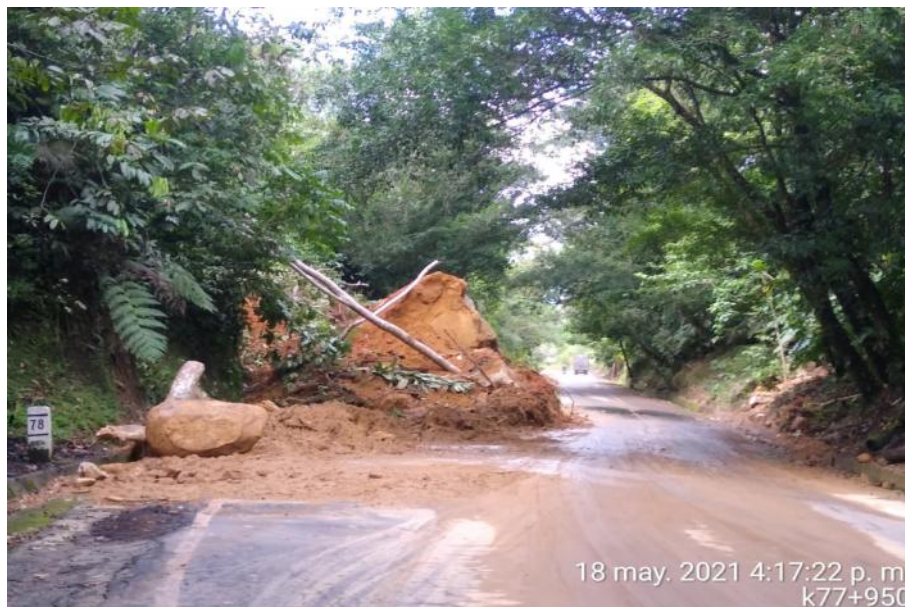
Fotografía 5: Habilitación provisional a un carril de vía en PR 77+950 Ruta 2003 A.
