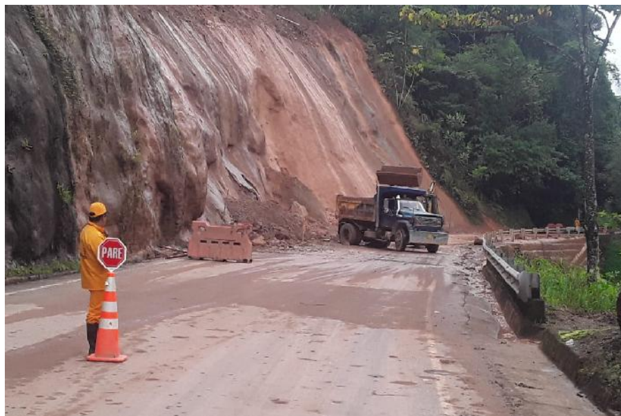
Fotografía 9: Remoción y retiro de material proveniente de derrumbe PR 80+100 Ruta 2003 A.
