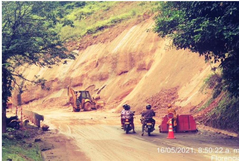
Fotografía 8: Remoción y retiro de material proveniente de derrumbe PR 80+100 Ruta 2003 A.
