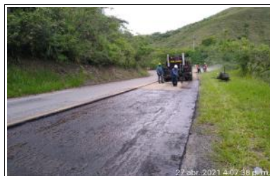
Actividad de riego de imprimación con emulsión asfáltica.
