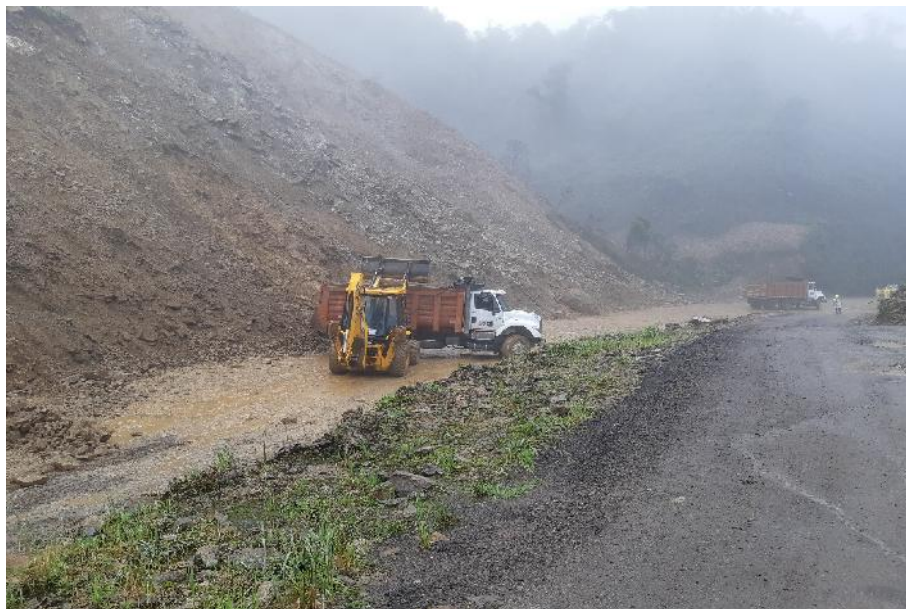
Fotografía 13: Remoción y retiro de material proveniente de derrumbe PR 42+800 Ruta 2003 A.
