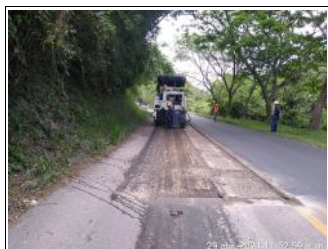
Actividad de fresado de la carpeta asfáltica existente.
