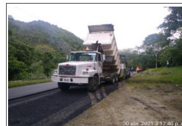
Actividad de instalación de mezcla asfáltica densa en caliente.
