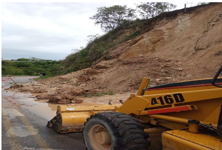
Fotografía 1: Remoción y retiro de material proveniente de derrumbe PR 4+200 Ruta 2003 A.
