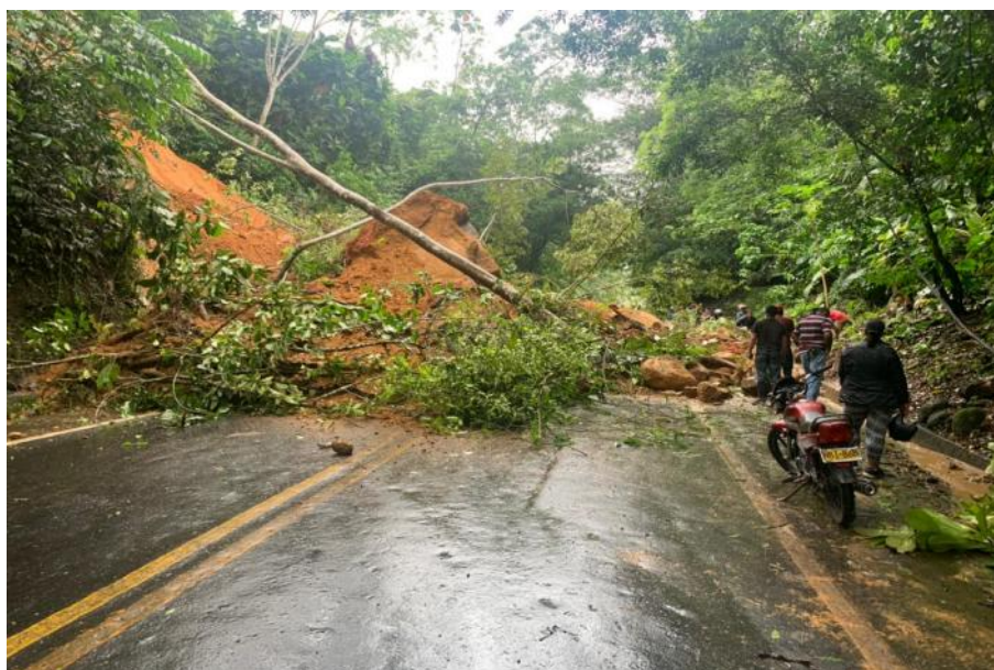
Fotografía 3: Derrumbe presentado en PR 77+950 Ruta 2003 A.
