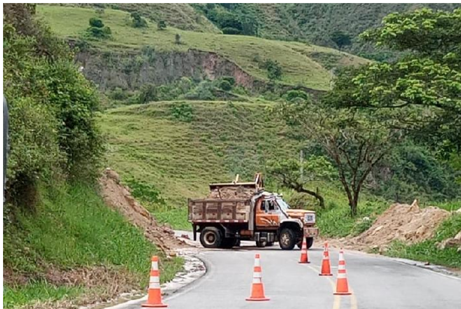
Fotografía 2: Remoción y retiro de material proveniente de derrumbe PR 4+200 Ruta 2003 A.
