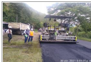
Actividad de instalación de mezcla asfáltica densa en caliente MDC-19.
