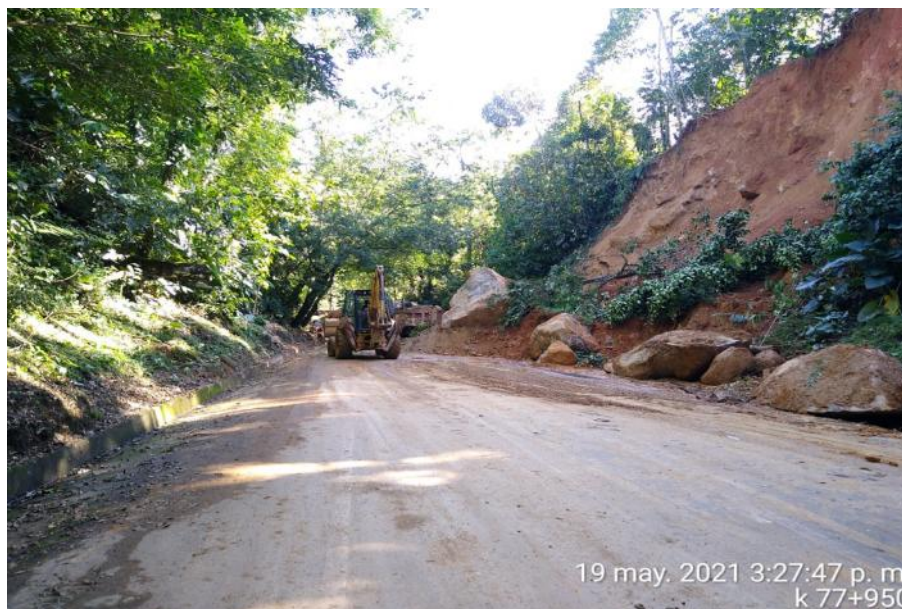
Fotografía 6: Remoción y retiro de material proveniente de derrumbe PR 77+950 Ruta 2003 A.
