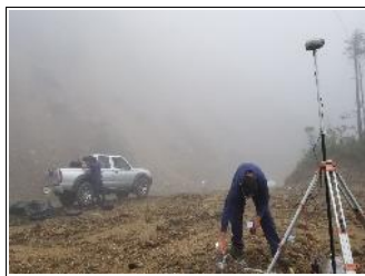
Instalación de equipos para iniciar actividades topográficas en los puntos críticos.
