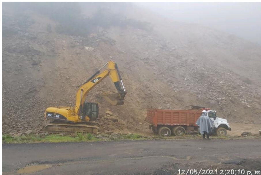
Fotografía 11: Remoción y retiro de material proveniente de derrumbe PR 42+800 Ruta 2003 A.
