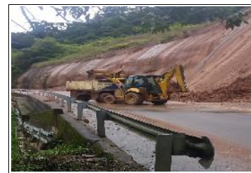
Remoción y retiro de derrumbe presentado en la PR80+100 de la ruta 2003A
