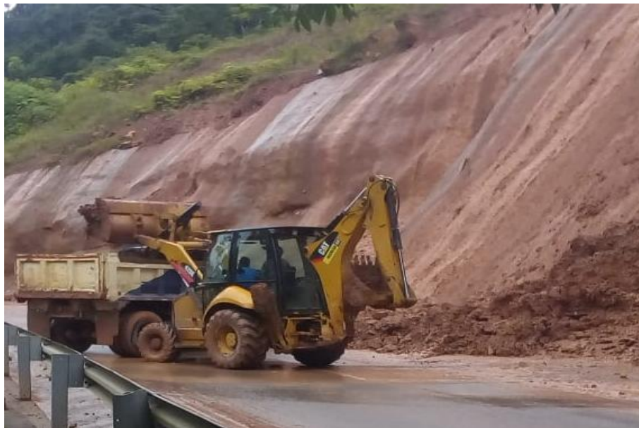
Fotografía 10: Remoción y retiro de material proveniente de derrumbe PR 80+100 Ruta 2003 A.
