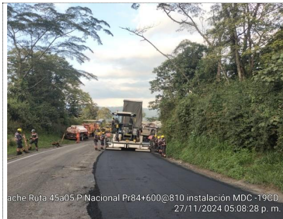
PR84+0600 – PR84+0810, Puente Nacional, instalación de MDC-19 (27/11/24)
