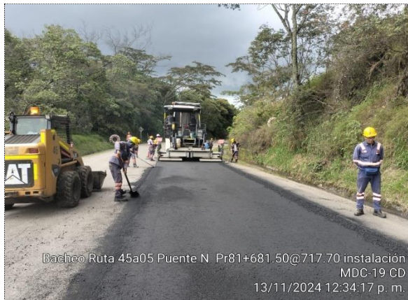
BACHEO RUTA 45A05, PUENTE NACIONAL, PR81+681 - PR81+717, FRESADO E INSTALACIÓN DE MDC-19
