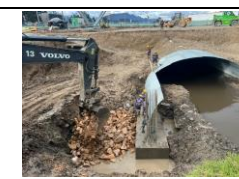
VARIANTE ZIPAQUIRÁ, OBRA No 19, INSTALACIÓN DE RAJÓN COSTADO OCCIDENTAL DE VIGA DE AMARRE
