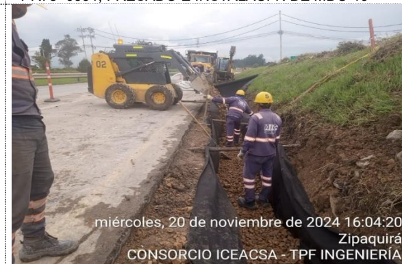
VARIANTE ZIPAQUIRÁ, K3+265 - K3+300 CONSTRUCCIÓN DE FILTRO FRANCÉS POR CALZADA EXISTENTE
