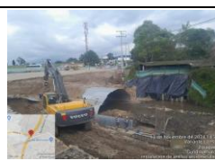
VARIANTE ZIQAQUIRÁ, OBRA No 19, MONTAJE DE ANILLOS DE ARCO METÁLICO
