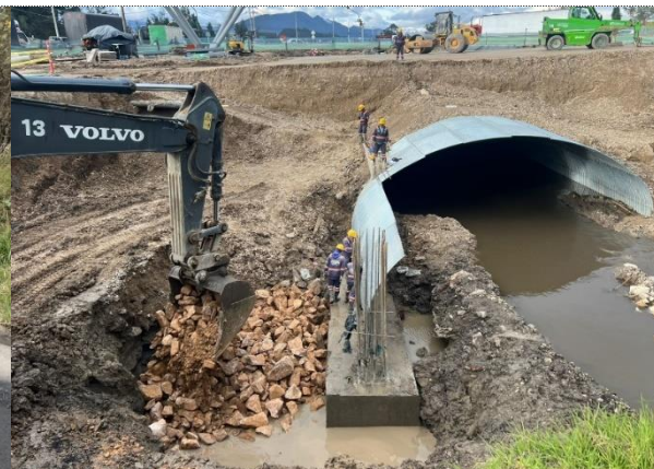
VARIANTE ZIPAQUIRÁ, OBRA No 19, INSTALACIÓN DE RAJÓN COSTADO OCCIDENTAL DE VIGA DE AMARRE
