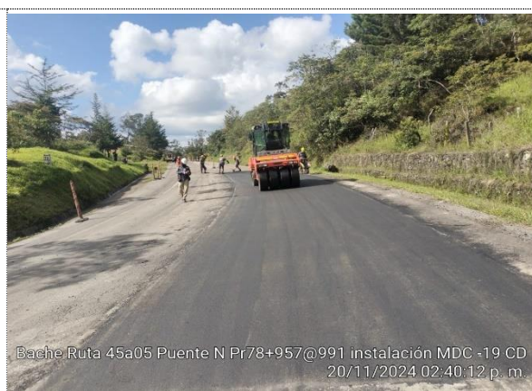
BACHEO RUTA 45 A 05, PUENTE NACIONAL, PR78+0957 - PR78+0991, FRESADO E INSTALACI'N DE MDC-19
