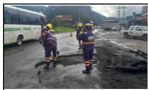
TAPAHUECOS RUTA 45 A 04, SUTATAUSA, PR58+0930, TAPAHUECOS CON MDC-19
