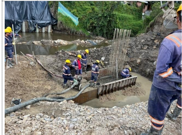
VARIANTE ZIPAQUIRÁ, OBRA No 19, FUNDIDA DE VIGA CABEZAL COSTADO OCCIDENTAL
