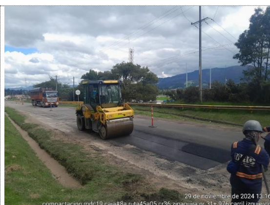
PR31+0976 – PR31+0995, carrera 36, instalación de MDC-19 (29/11/24)
