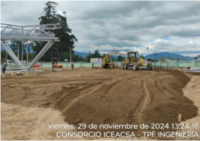
K 2+750 Extension y compactacion de capa de terraplen K 0+000 - K 0+090, Glorieta sector de Ave Colombiana. Variante de Zipaquirá ruta 45ACND
