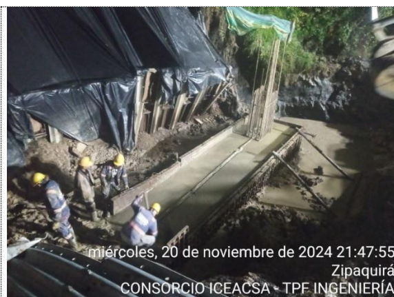
VARIANTE ZIPAQUIRÁ, OBRA No 19, FUNDIDA DE VIGA DE AMARRE ORIENTAL, TRAMO FINAL
