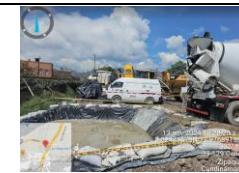
INSPECCIÓN DE PISCINA DE LAVADO DE CONCRETO
