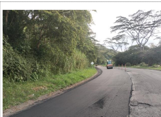
PR84+0600 – PR84+0810, Puente Nacional, compactación de MDC-19 (27/11/24)
