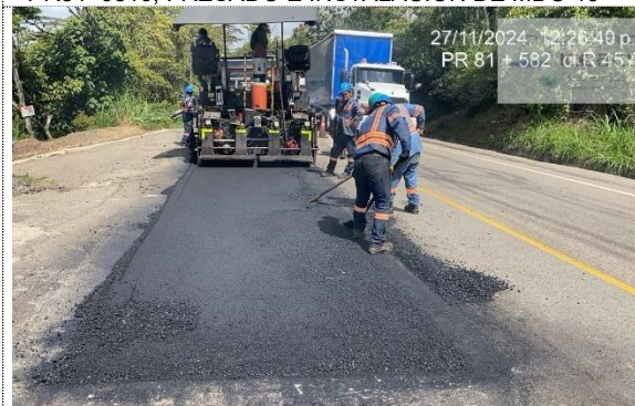
Bacheo Ruta 45a05 P Nacional Pr84+600@810 instalación MDC-19CD 27/11/2024 05:08:24 p. m.
