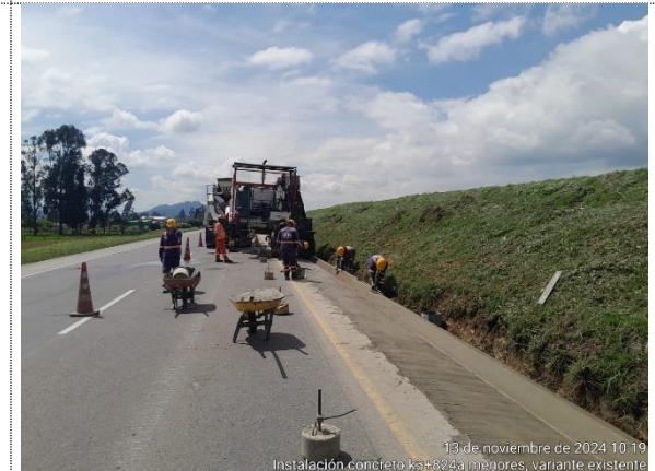
VARIANTE ZIPAQUIRÁ, CALZADA EXISTENTE, K3+685 - K3+825 FUNDIDA DE CUNETETA
