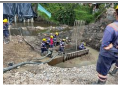
VARIANTE ZIAPAQUIRÁ, OBRA No 19, FUNDIDA DE VIGA CABEZAL COSTADO OCCIDENTAL.
