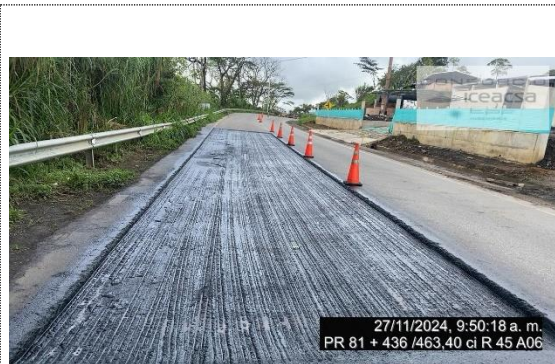
PR81+0436 – PR81+0463, Oiba, instalación de riego de liga (27/11/24)
