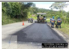
BACHEO RUTA 45 A 06, OIBA, PR77+0677, FRESADO E INSTALACIÓN DE MDC-19
