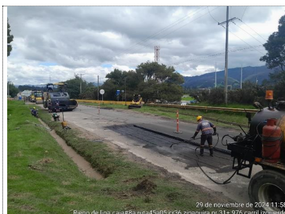
PR31+0976 – PR31+0995, carrera 36, instalación de riego de liga (29/11/24)
