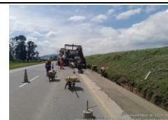
VARIANTE ZIPAQUIRÁ, CALZADA EXISTENTE, K3+685 - K3+825 FUNDIDA DE CUNETA
