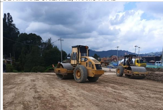
VARIANTE ZIPAQUIRÁ, GLORIETA, CEREO Y COMPACTACIÓN DE CORONA DE TERRAPLÉN
