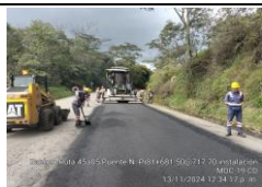
BACHEO RUTA 45A05, PUENTE NACIONAL, PR81+681 - PR81+717, FRESADO E INSTALACIÓN DE MDC-19
