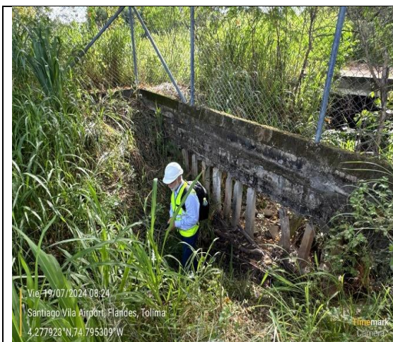
Foto 5. Visita Inspección hidráulica
