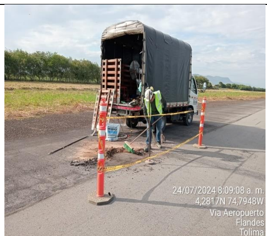
Foto 12. Realización de perforaciones para estudio de suelos.
