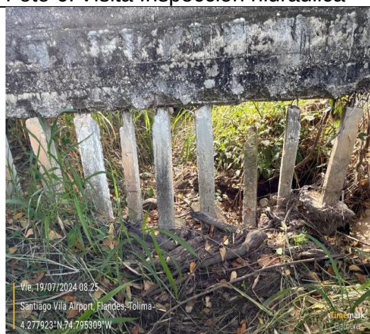
Foto 8. Visita Inspección hidráulica
