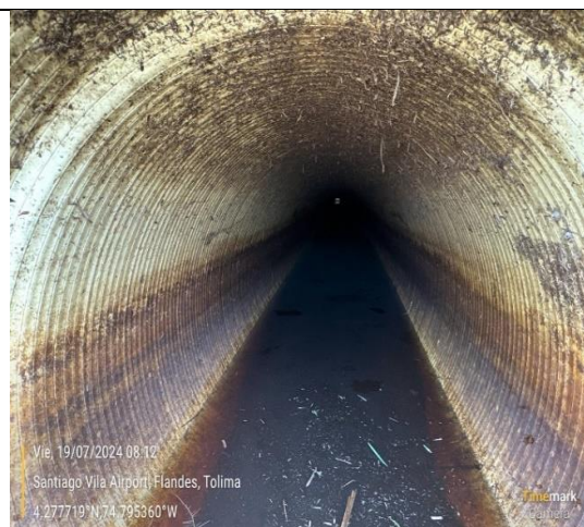
Foto 6. Visita Inspección hidráulica
