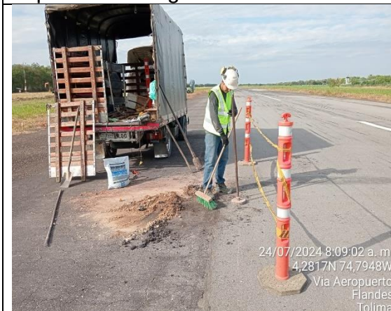
Foto 13. Realización de perforaciones para estudio de suelos.
