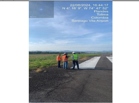
Foto 12. Visita al sitio de ejecución del proyecto 22/08/24
