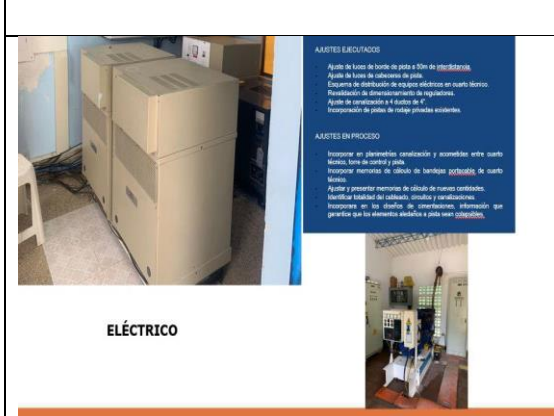
Foto 11. Socialización observaciones eléctricas del contrato de obra
