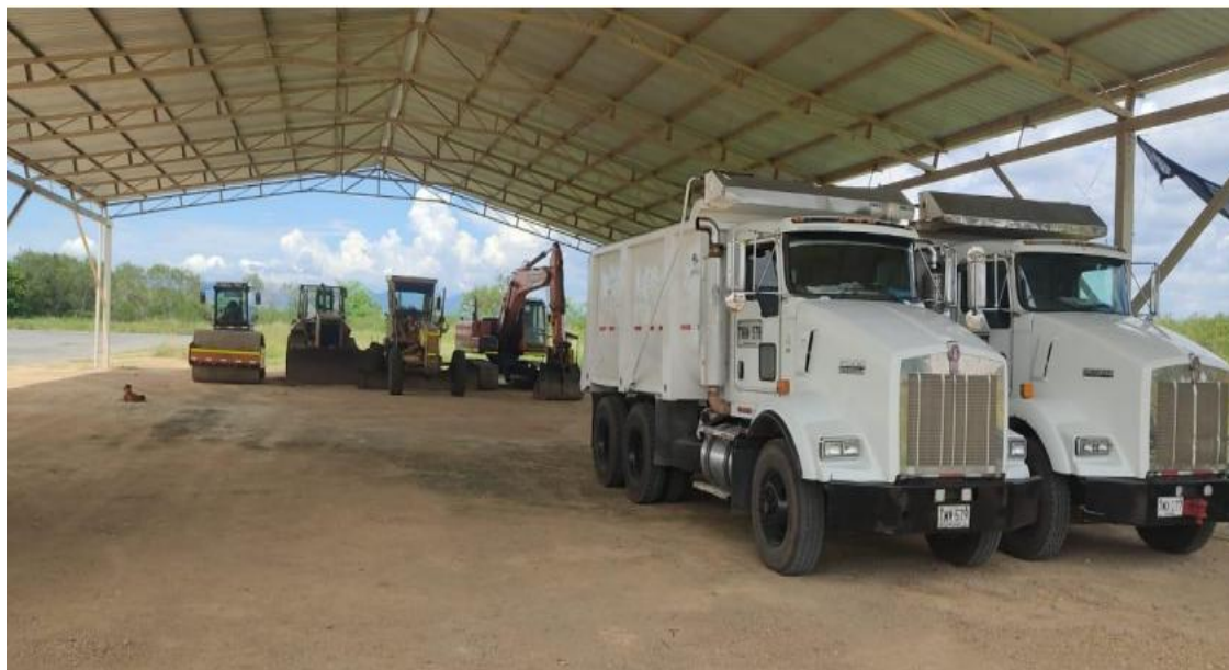
Ilustración 3 Movilización de equipos a obra
