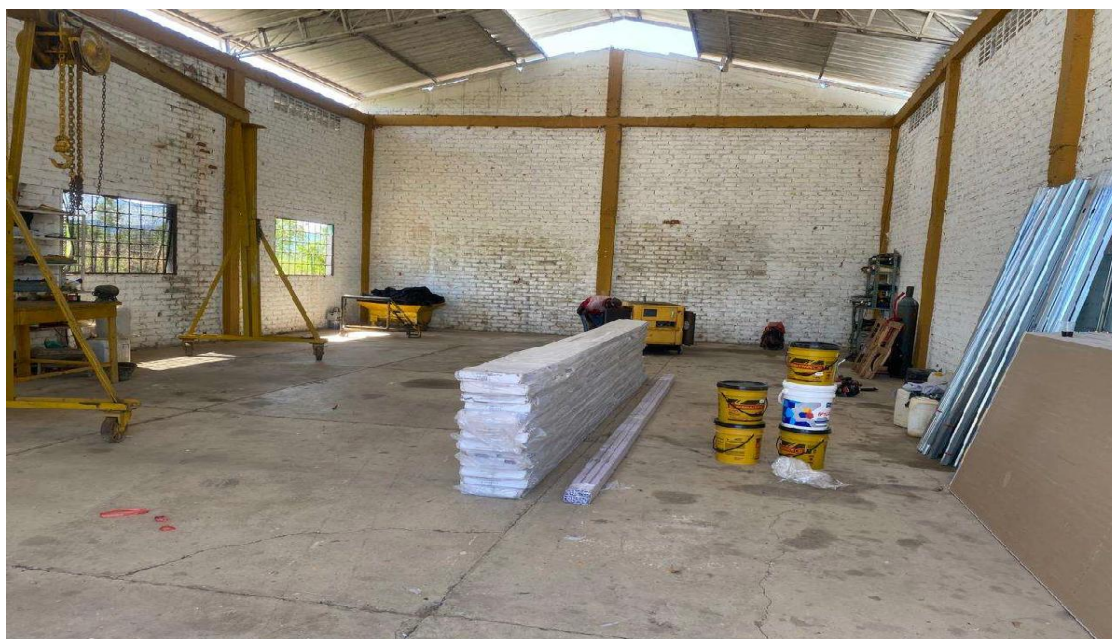
Ilustración 4 Adecuación de oficinas contratista
