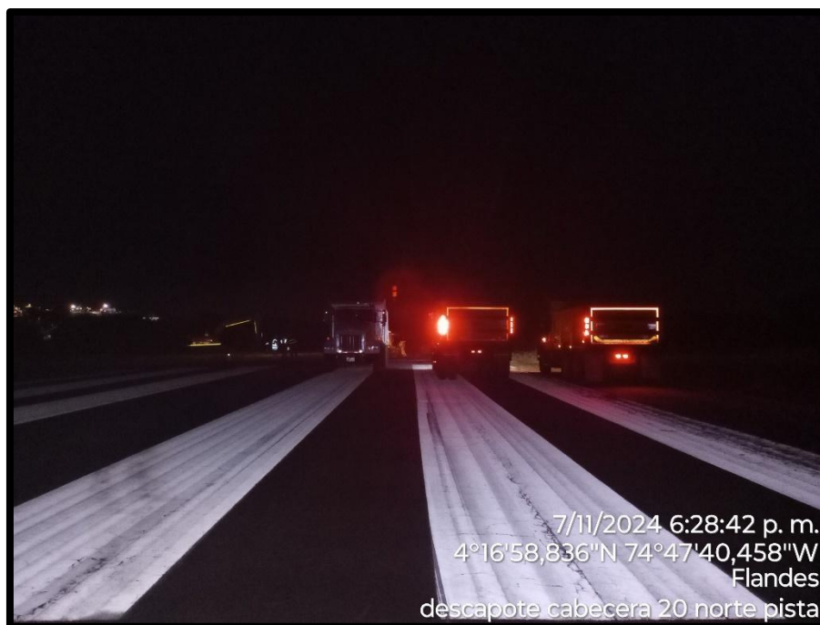
Ilustración 6 Marcación vial con pintura en frío
