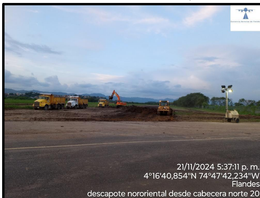
Ilustración 4 Retiro de material de descapote
