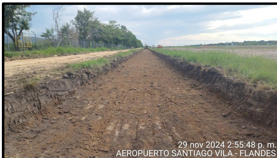
Ilustración 5 Descapote de canal derecho
