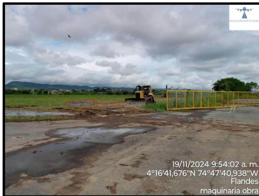
Ilustración 3 Descapote mecánico de zonas de seguridad de pista
