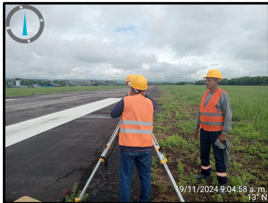
Ilustración 2 Localización y replanteo topográfico
