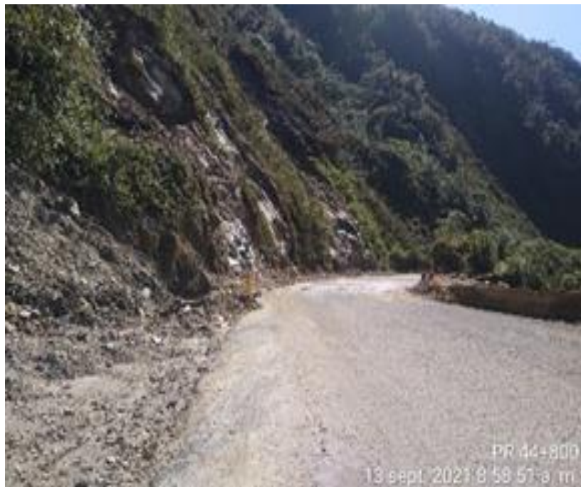
Fotografía 3: Remoción y retiro de material de derrumbe por el contratista INGEVIAS PR 42+880 Ruta 2003 A.
