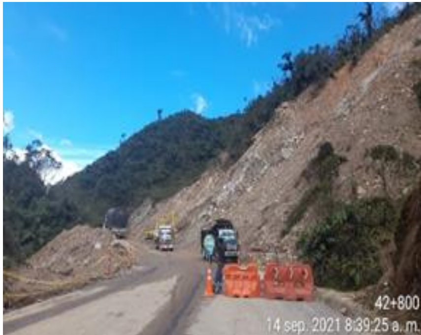
Fotografía 2: Remoción y retiro de material de derrumbe por el contratista INGEVIAS PR 42+880 Ruta 2003 A.
