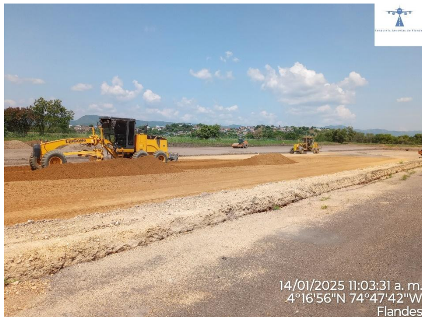
Ilustración 3 Céreo de afirmado para franja de seguridad
