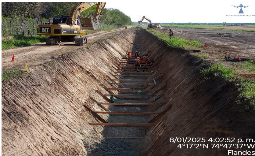
Ilustración 2 Instalación de plantillas para canal trapezoidal
