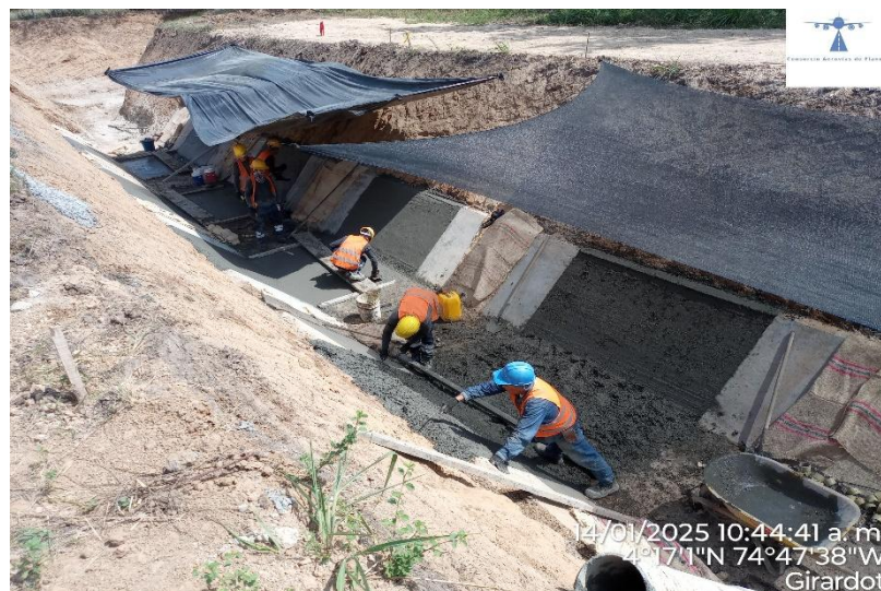
Ilustración 4 Vaciado de concreto para paredes de canal trapezoidal
