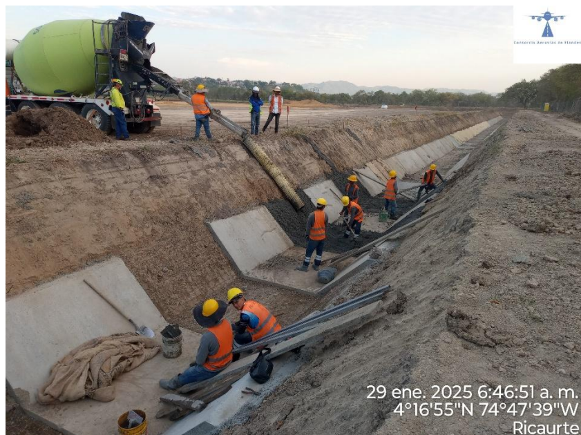
Ilustración 5 Vaciado de concreto para canal trapezoidal
