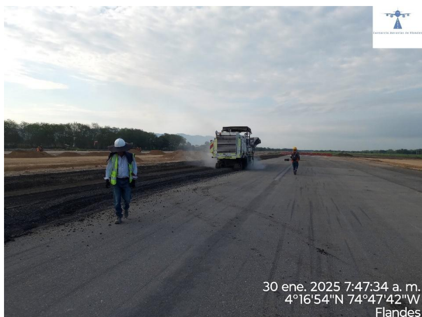
Ilustración 6 Fresado para pista
