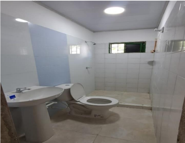
MANTENIMIENTO Y REPOSICION E INSTALACION ENCHAPE PARED CERAMICO.
