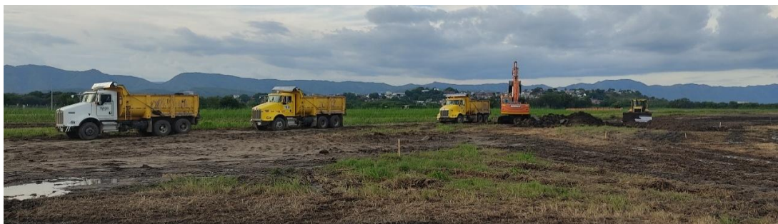
Ilustración 4- Disposición de equipos en el Frente de trabajo de descapote
