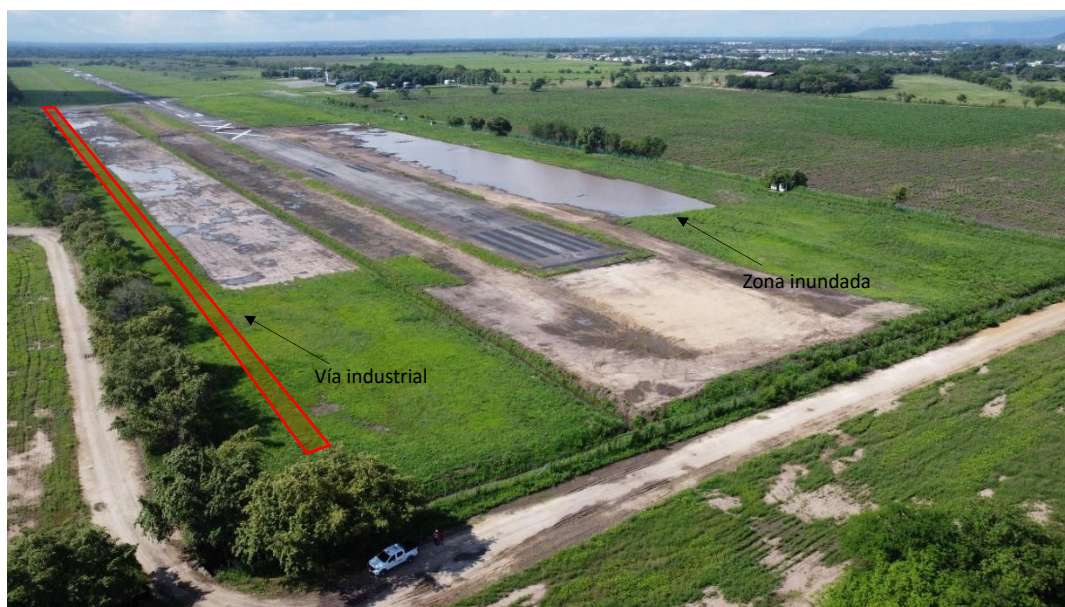
Ilustración 3-Zona intervenida, afectación invierno y vía industrial construida costado oriental (fuente propia)
