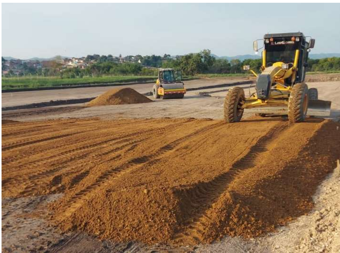
Ilustración 3- Disposición de equipos en el Frente de trabajo de descapote
