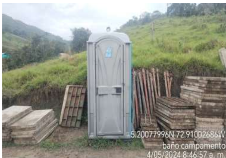
Fotografía No.1 Baño portátil en obra
