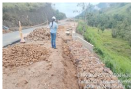
INSTALACIÓN DE GAVIONES PROTECCIÓN HOMBRO DE LA VÍA K5+990 Y VISITA PROFESIONAL AMBIENTAL DE INTERVENTORIA.
