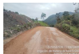
IRRIGACIÓN DE MATERIAL DE BASE K5+260
