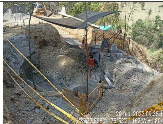
Fotografía No. 4. Excavación de caisson No. 1 y No. 2 puente No. 4
