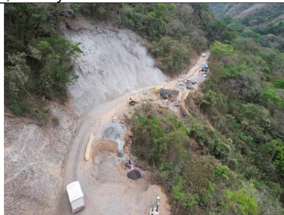
Fotografía No. 3. Localización general del puente No. 4
