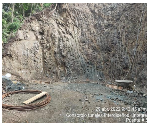
Fotografía No. 6. Inicia excavación para los pilotes No. 3 y No. 4 del estribo No. 2
