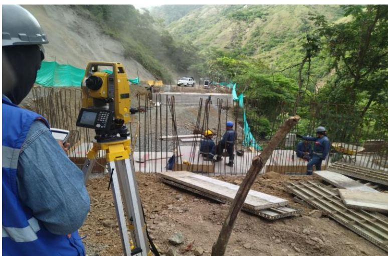
Chequeo y liberación para la excavación en chaflán del cielo abierto 12.
