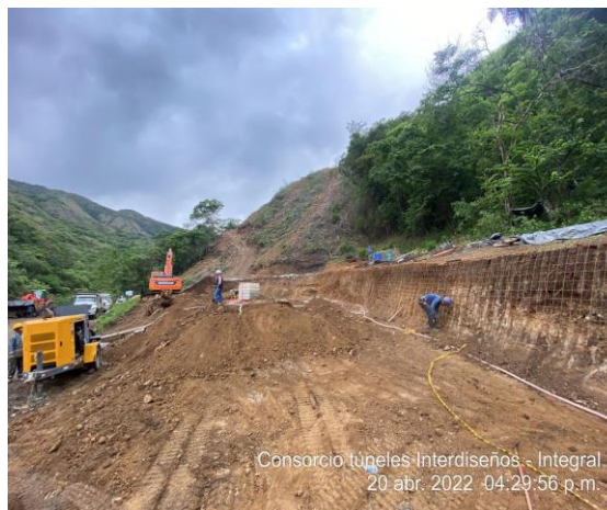
Chequeo y liberación para la excavación en chaflán del cielo abierto 12.
