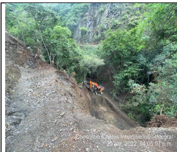
Fotografía No. 5. Excavación estructural para el estribo No. 2
