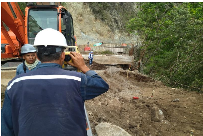
Levantamiento de excavaciones en muro 13 para localizar caisson A,B,C, y D.
