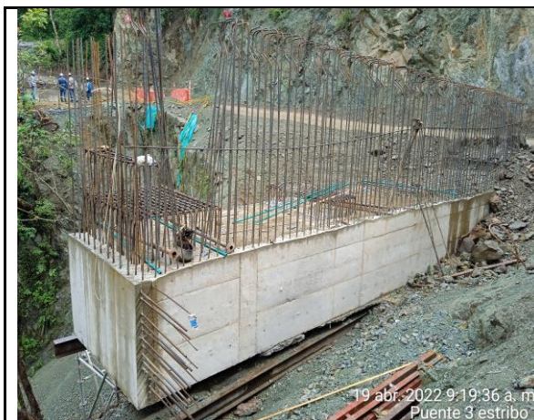
Fotografía No. 1. Aspecto terminado de viga cabezal estribo No. 1.
