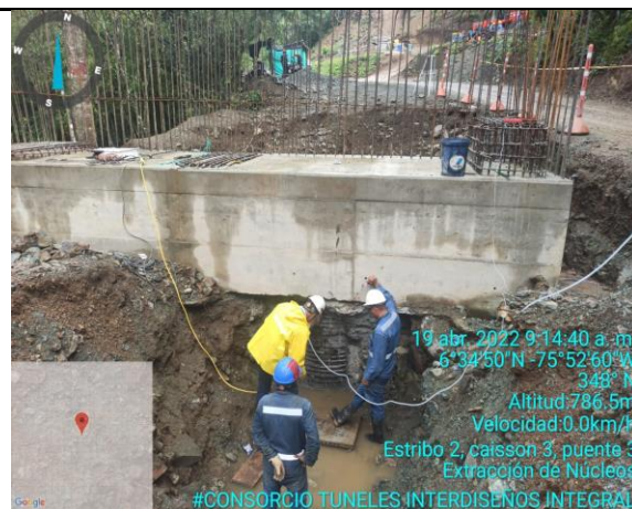
Fotografía No. 2. Aspecto de concreto en viga cabezal estribo No. 2 y toma de núcleos en pilote No. 3
