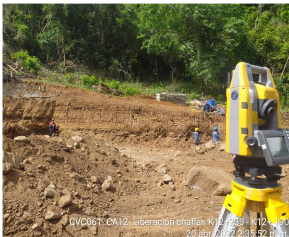
Chequeo y liberación para la excavación en chaflán del cielo abierto 12.
