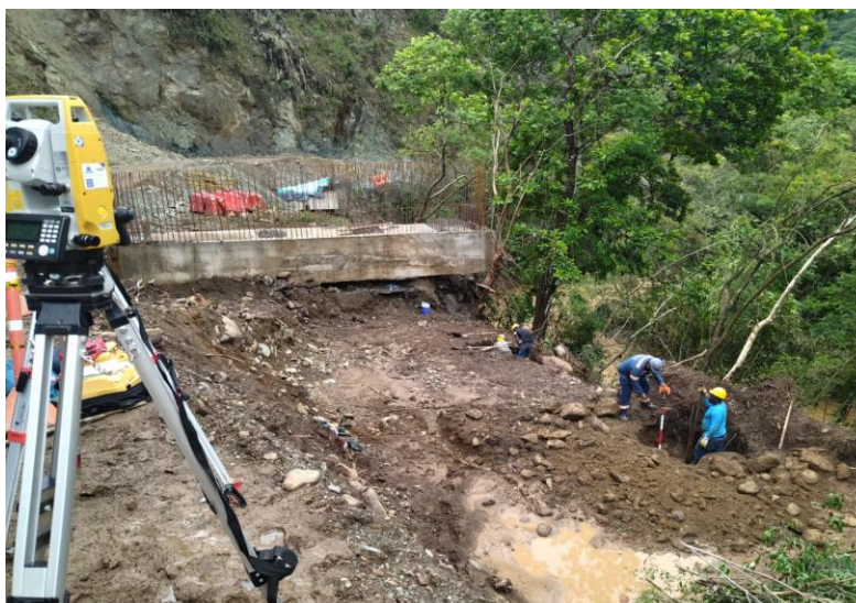
Chequeo y liberación de la instalación de arcos, excavación, y concreto lanzado en el túnel 8.
