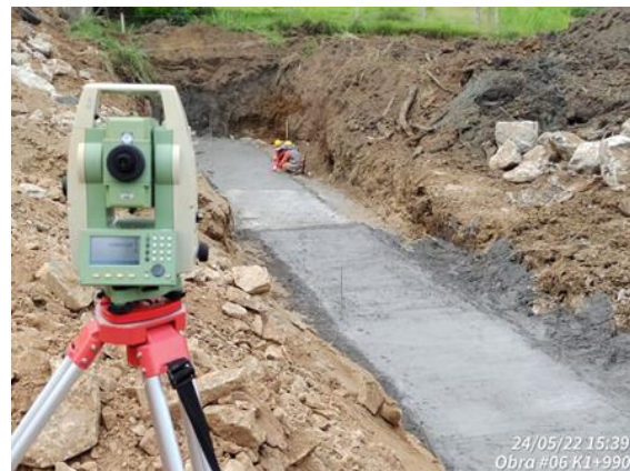
Foto No 4: Control de niveles para concreto de limpieza obra hidráulica K1+990
