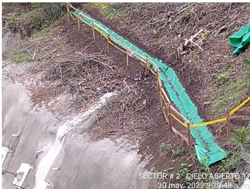
Foto: demarcación correcta de cunetas
