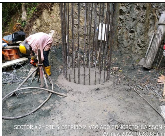
Fotografía No. 4. Hormigonado de los pilotes No. 3 y No. 4 del estribo No. 2
