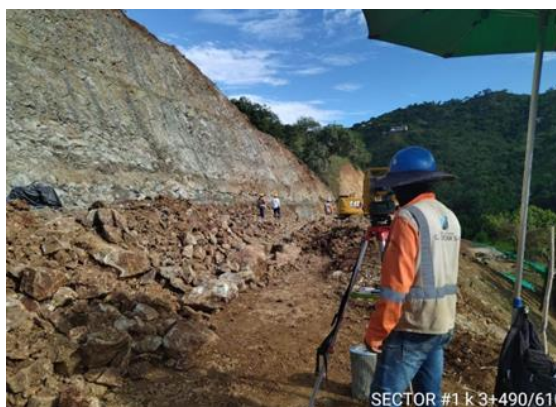
Foto No 8: Replanteo para instalación de solados para obra hidráulica K1+990
