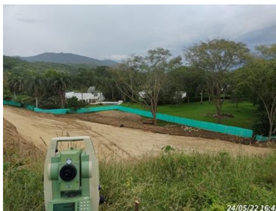
Foto No 6: Actividades de topografía terraplen K2+270/320
