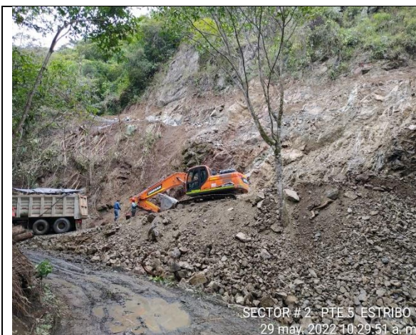
Fotografía No. 3. Excavación estructural para el estribo No. 1
