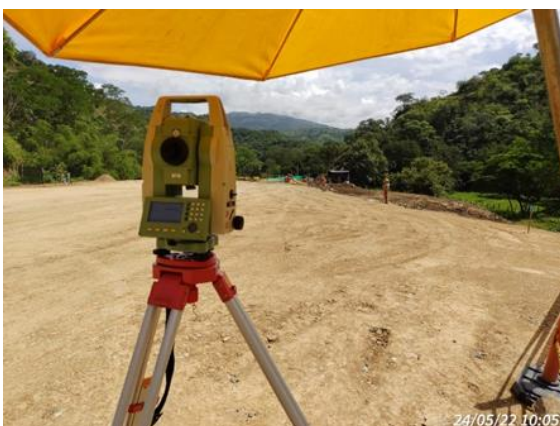
Foto No 5: Actividades de topografía (5) terraplen K2+020/220
