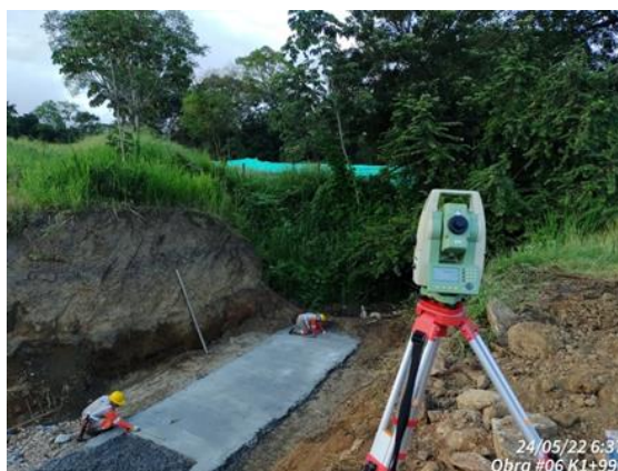
Foto No 8: Replanteo para instalación de solados para obra hidráulica K1+990
