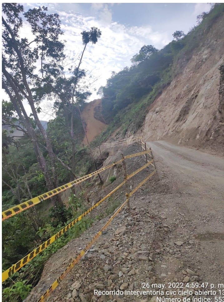
Foto: Carencia de elementos reflectivos para la demarcación de la vía
