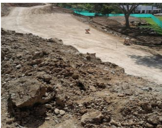
Foto No 9: Actividades de topografía Actividades de topografía terraplen K2+270/320
