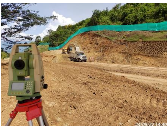
Foto No 7: Control de corte de talud K2+500/600
