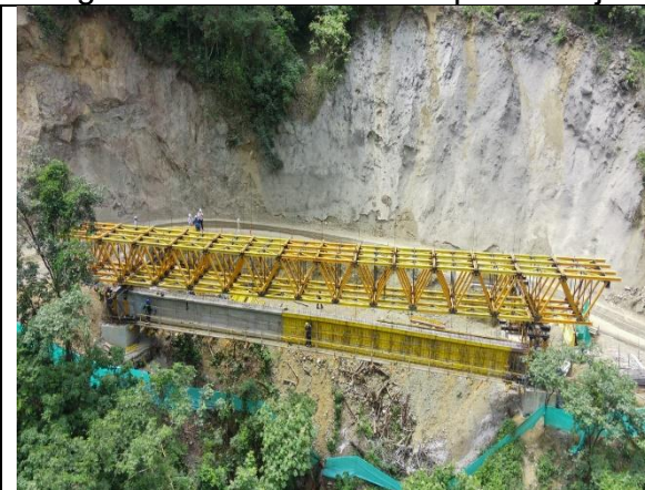
Fotografía No. 1. Viga postensada hormigonada
