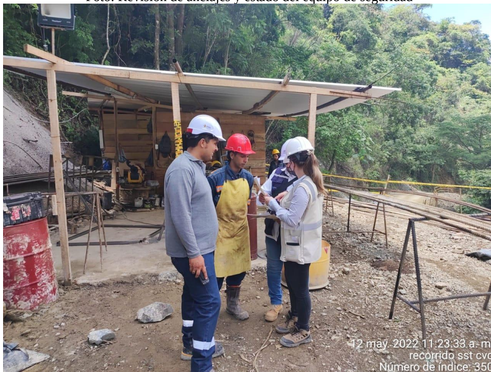
Foto: Revisión documental área SST al personal en los frentes de obra
