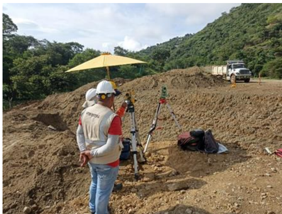
Foto No 3: Actividades de topografía Replanteo de obra No 15
