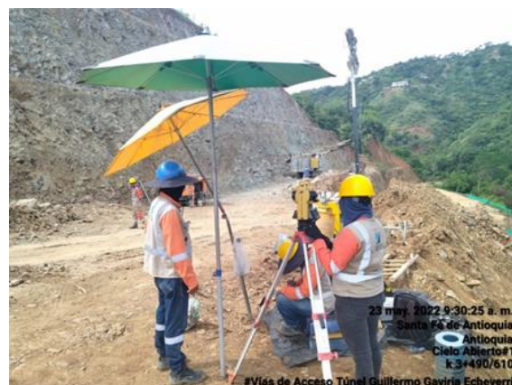
Foto No 14: Marcación de pernos talud K3+940/610
