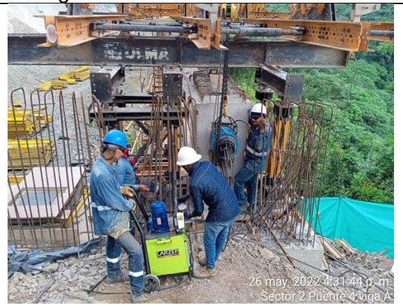
Fotografía No. 2. Labores de tensionamiento de vigas
