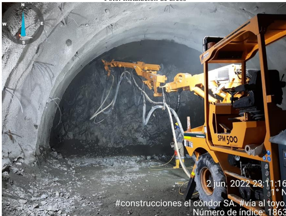
Foto lanzado de concreto
