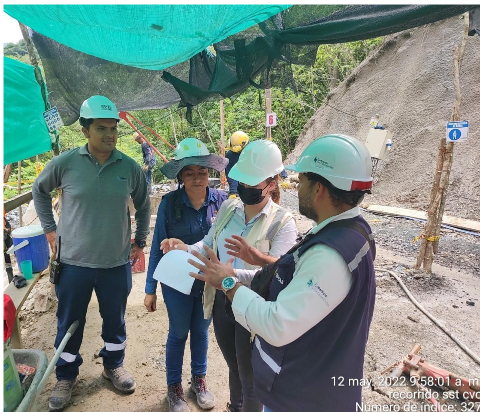
Foto: Revisión de permisos para espacios confinados en Puente 6
