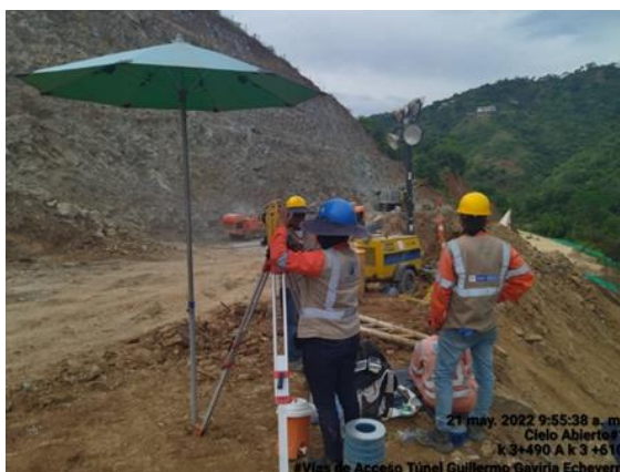
Foto No 13: Marcación de pernos talud K3+940/610
