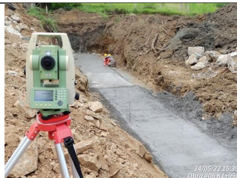
Foto No 4: Marcación niveles losa inferior obra hidráulica #6 cielo abierto 1 A k1+990
