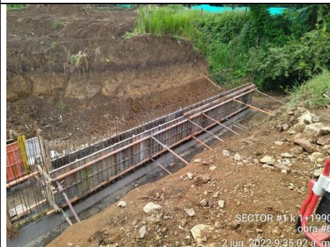
Foto No 6: Chequeo alineamiento de muro lateral obra hidráulica # 6 Cielo abierto 1 A k1+990
