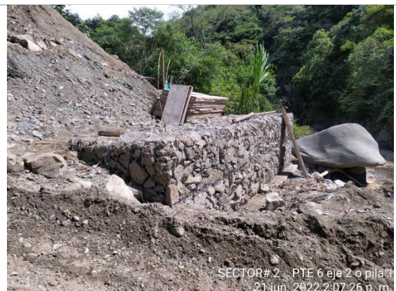
Fotografía No. 10 Armado de gaviones en estribo 1 del puente metálico provisional
