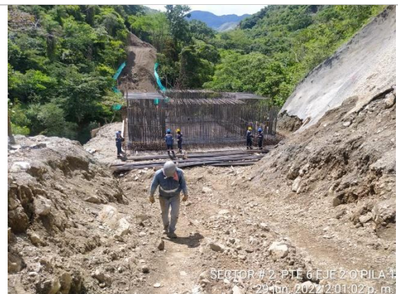
Fotografía No. 10 Armado de acero de refuerzo en dado de eje 2 pila 1
