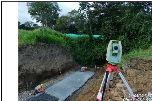
Foto No 3: Marcación niveles losa inferior obra hidráulica #6 cielo abierto 1 A k1+990
