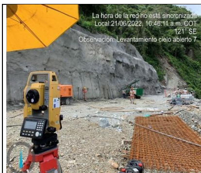
Foto No 17: Marcación para instalación de pernos de 6 metros en talud cielo abierto #7 K10+250
