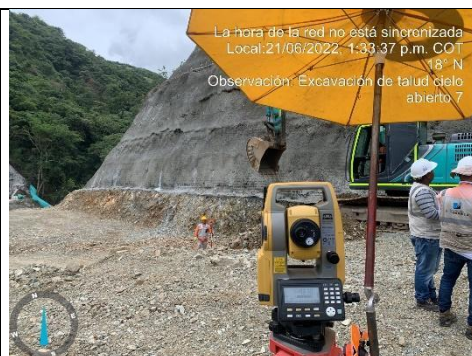
Foto No 18: Control de excavación de talud cielo abierto #7 abscisa k10+290
