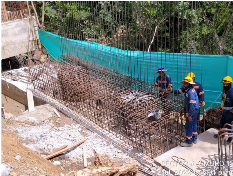
Foto trabajo coordinado de la cuadrilla de obra
