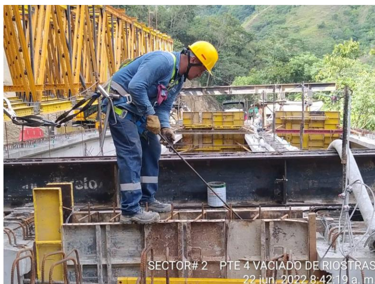
Foto Trabajo en alturas Puente 4
