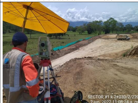
Foto No 8: Marcación de chaflanes en terraplén cielo abierto 1 A K2+030-220
