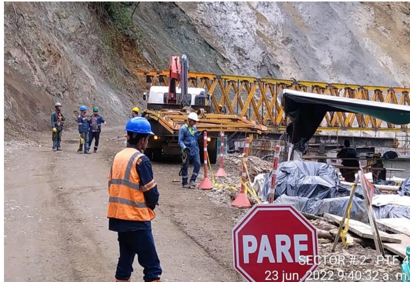
Foto señalización, orden y aseo en el Puente 4
