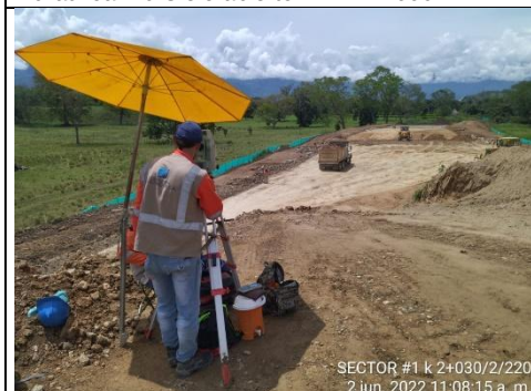
Foto No 7: Marcación de chaflanes en terraplén cielo abierto 1 A K2+030-220
