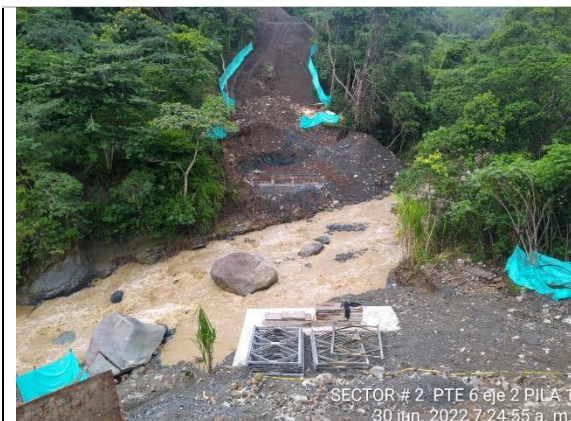
Fotografía No. 11 Aspecto general de trabajos en los apoyos del puente metálico provisional
