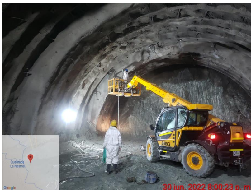
Foto: perforación con jumbo.
