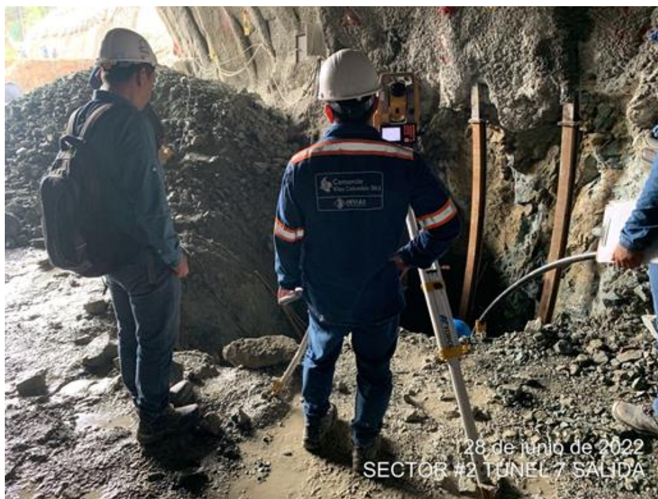
Acompañamiento de instalación de patas sección 1 arco1,2 y 3 portal salida túnel 7
