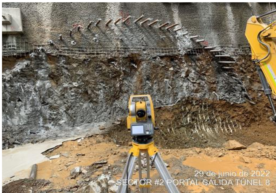
Excavación para instalación de arco 0 portal salida túnel 8 ABS K15+247.40 terreno tipo V
