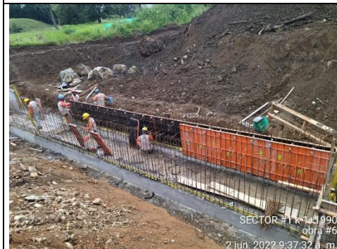
Foto No 5: Chequeo alineamiento de muro lateral obra hidráulica # 6 Cielo abierto 1 A k1+990
