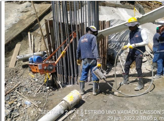
Fotografía No. 7 Hormigonado de pilote No. 2
