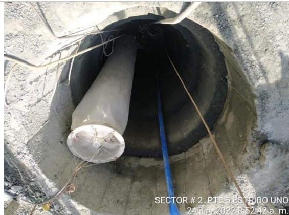
Fotografía No. 6 Aspecto interno de excavación de pilotes estribo No.1
