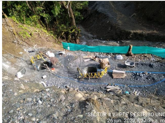
Fotografía No. 5 Avance de excavación de pilotes en estribo No. 1
