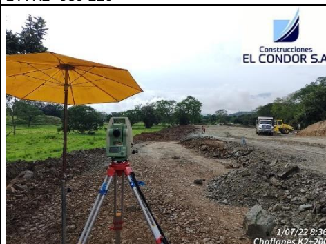
Foto No 8: Marcación de chaflanes en terraplén cielo abierto 1 A K2+030-220
