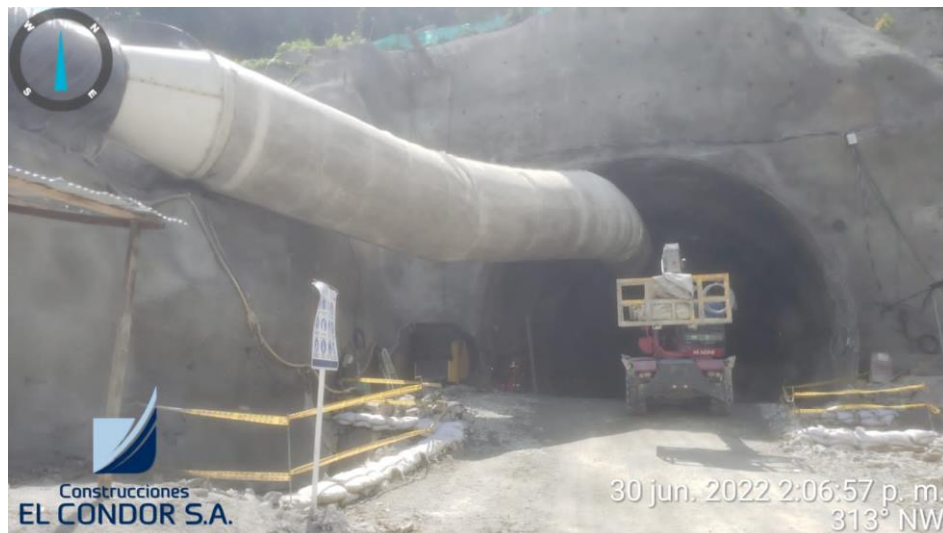
Foto: instalación de equipo extractor.
