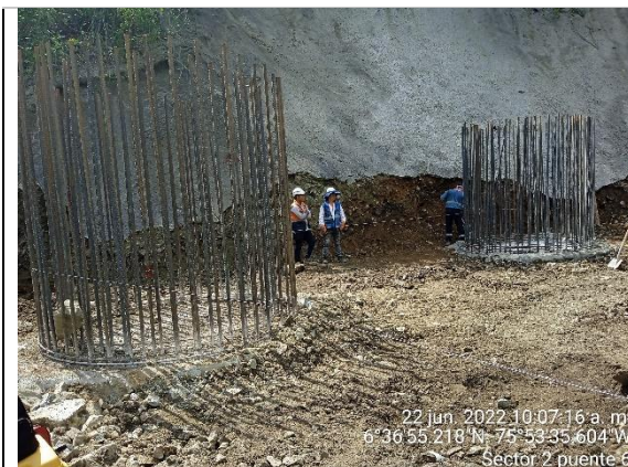
Fotografía No. 9 Pilotes terminados en eje 2 pila 1
