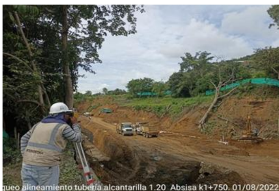
Foto No 1: Chequeo alineamiento alcantarilla k1+750.
