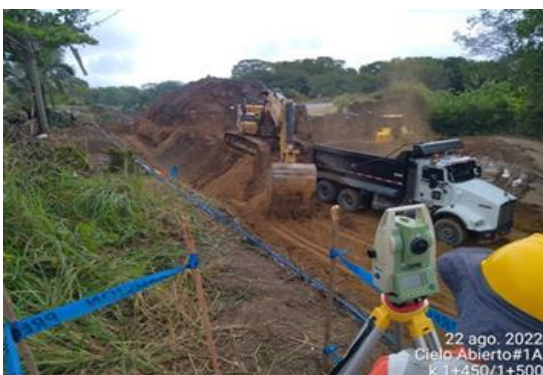
Foto No 13: levantamientos de excavación y descapote cielo abierto 1A
