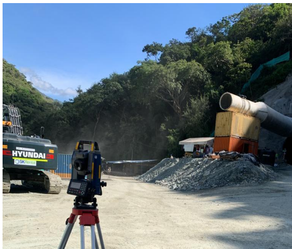
Foto No 1: Monitoreo a puntos de control Portal entrada Túnel 3
