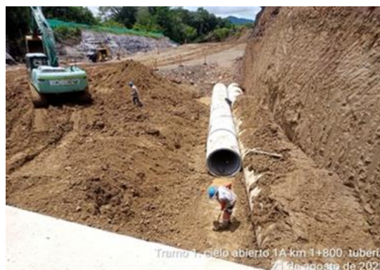
Foto No 14: Marcación de niveles para tubería doble Cielo abierto 1A
