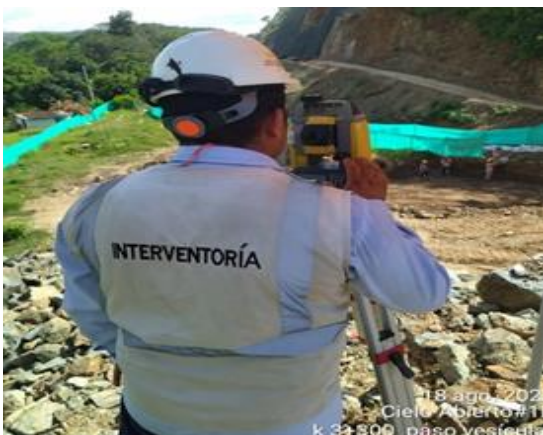
Foto No 9: Replanteo paso vehicular Cielo 1B, K3+340
