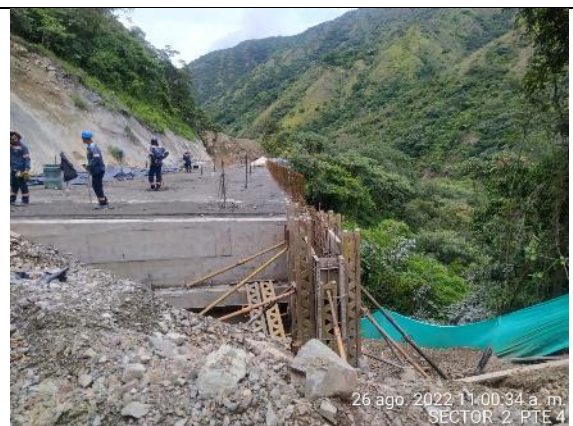
Fotografía 4. Instalación de acero de refuerzo para muros New Jersey.
