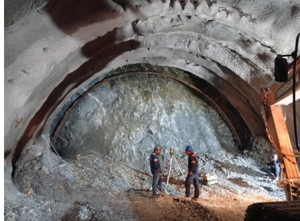
Foto No 12: Control de excavación e instalación de arco metálico – Túnel 8 Portal entrada – Abs: K15+101.00
