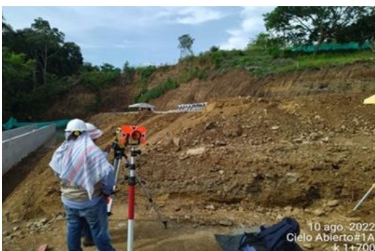
Foto No 7: Replanteo y marcación descole Obra #4
