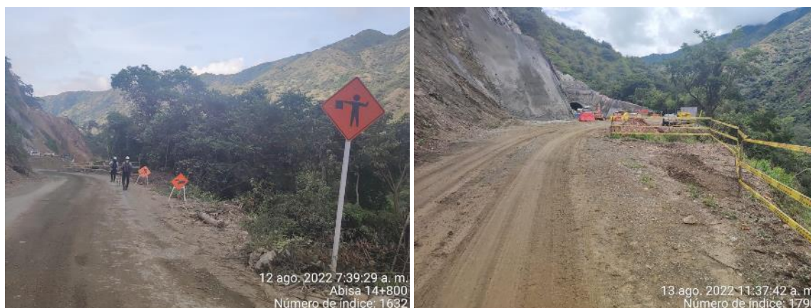
Verificación señalización vertical y demarcación del corredor vía paralelo al río Tonusco
