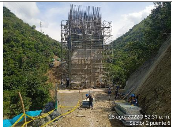
Fotografía 8. Avance de construcción de pila 1 en concreto de 35 Mpa.
