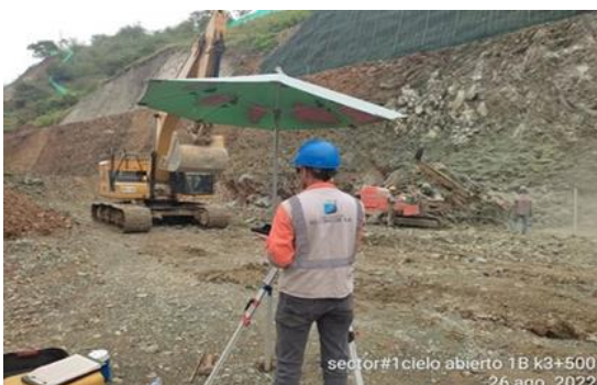
Foto No 19: Corte y perfilando de talud k3+500 a 3+590 borde derecho
