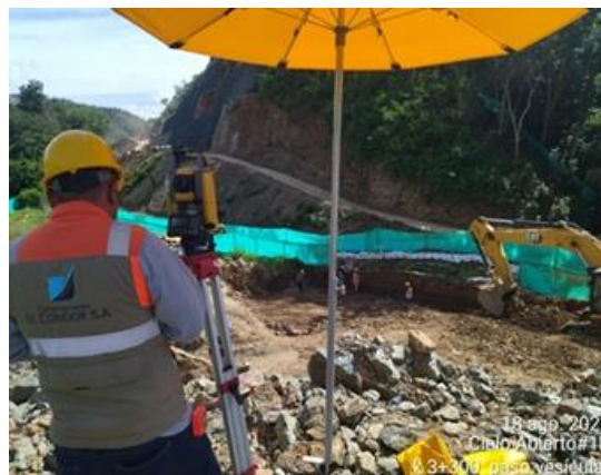
Foto No 10: Replanteo paso vehicular Cielo 1B, K3+340
