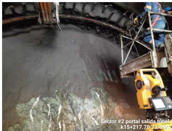
Foto No 10: instalación de arco metálico HEB100 Túnel 8 salida Abs: K15+217.70
