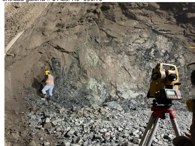
Foto No 10: Marcación de frente (límite de excavación) para avance Túnel 4 Abs: K10+566.40
