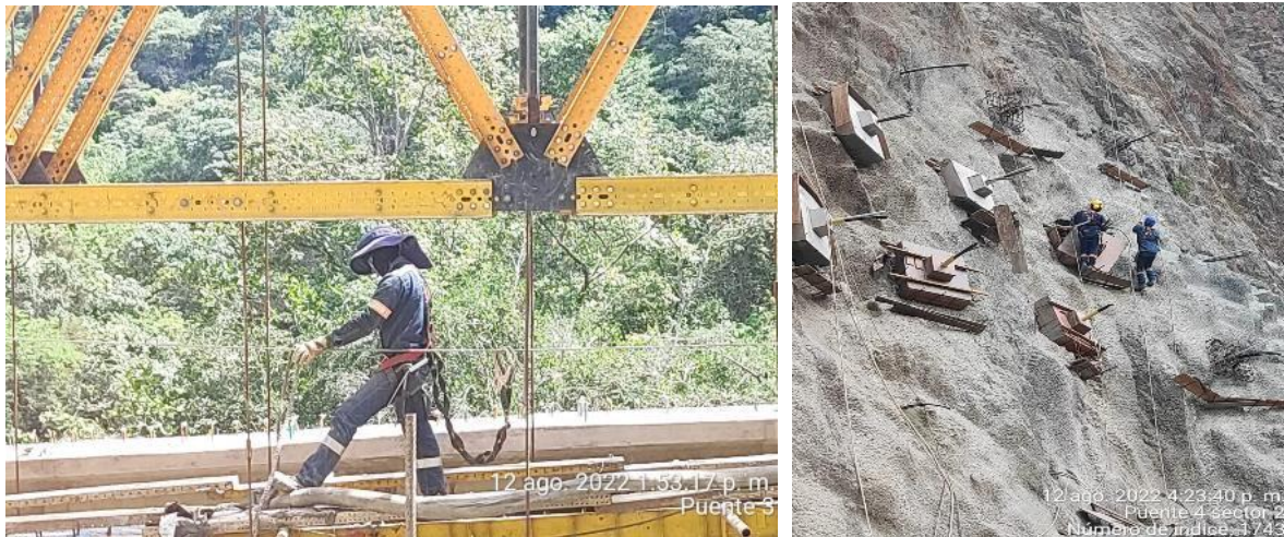
Registro fotográfico: trabajos en alturas registrados en puente 3 y túnel 5 portal salida.
