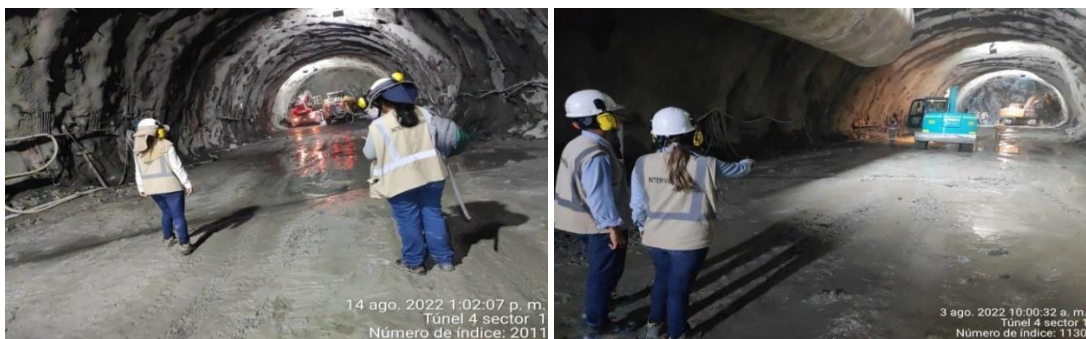
Verificación interdisciplinaria realizada por parte de la interventoría de las obligaciones contractuales
