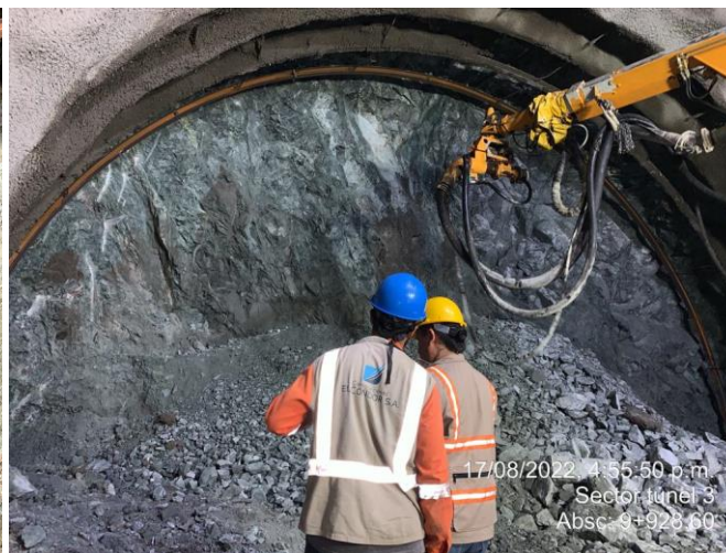
Foto No 6: Chequeo e instalación de arco HEB 100- terreno tipo 5 Abs: K9+928.60
