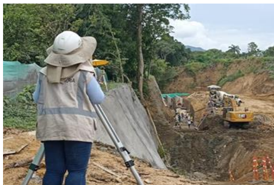
Foto No 4: Marcación niveles muros en canal abierto
