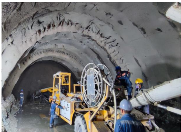
Foto No 9: Instalación de arco metálico HEB 100 # 5 Túnel 8 portal entrada.
