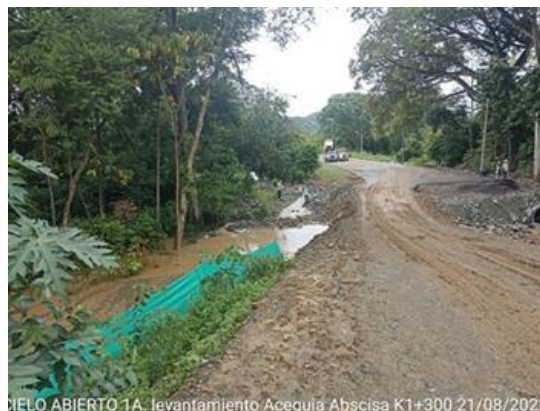
Foto No 12: Levantamiento acequia k1+300- k1+400
