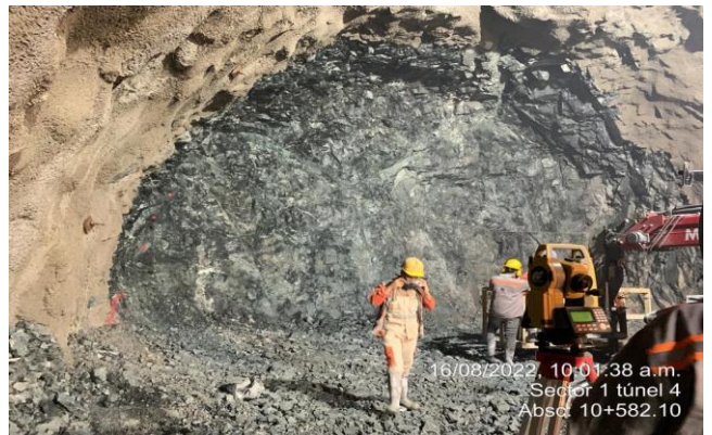
Foto No 12: Marcación de frente para control de excavación y barrenación para voladura . Túnel 4 – Abs: K10+582.1
