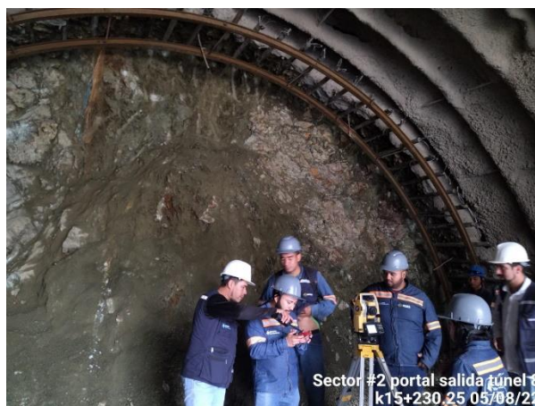
Foto No 6: Control de instalación arco metálico HEB 100 Túnel 8 portal salida Abs: 15+230.25
