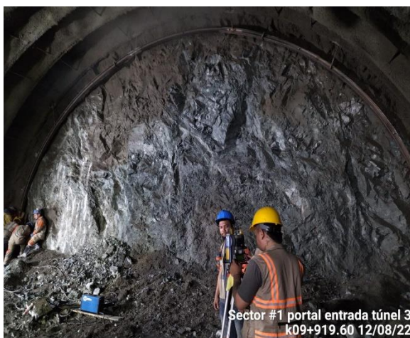
Foto No 3: Chequeo e instalación de arco terreno tipo 5 – Abs: K09+919.6
