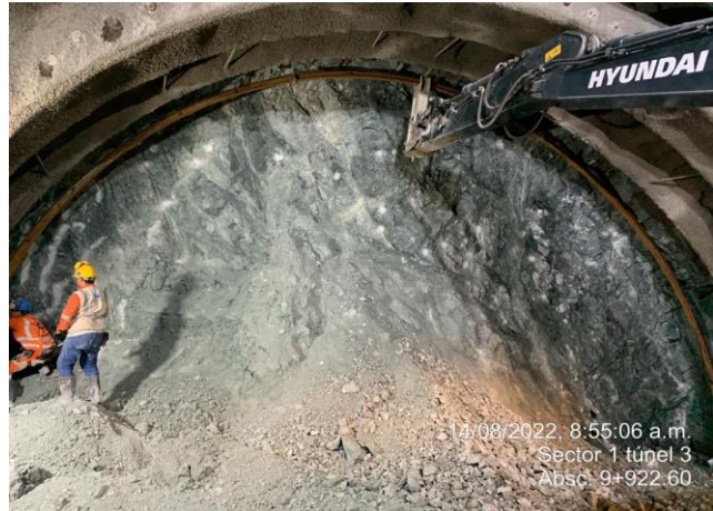
Foto No 14: Instalación de arco metálico HEB 100 -Túnel # 3 Abs: K9+922.60
