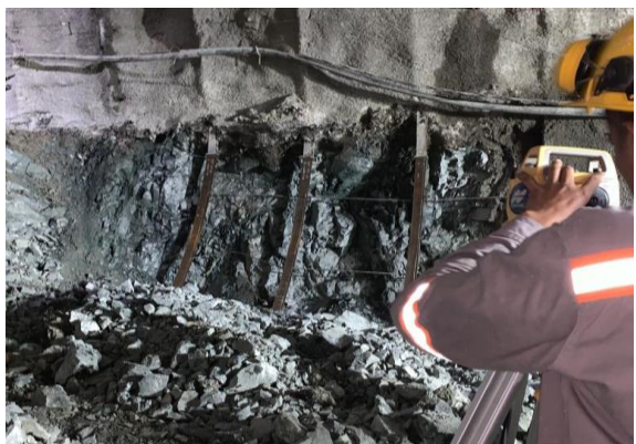
Foto No 11: Chequeo de instalación de patas de arco costado derecho – Túnel # 4 Abs: K10+486.70
