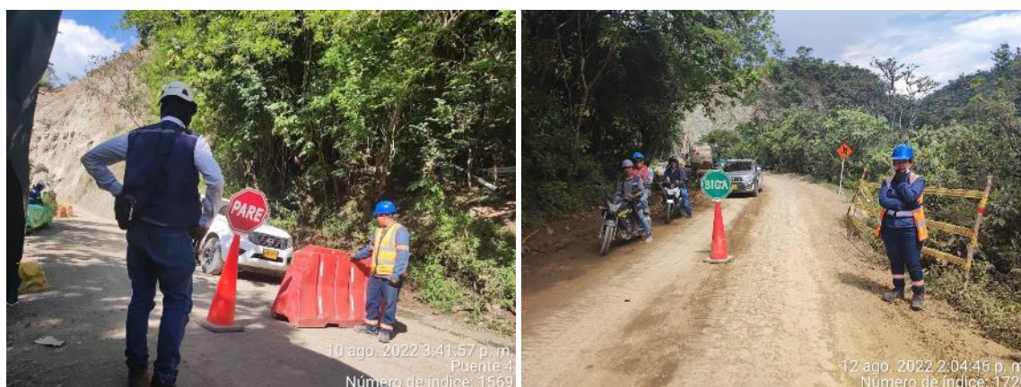
Control de tráfico en la zona rural de la vía industrial Antigua vía al mar
