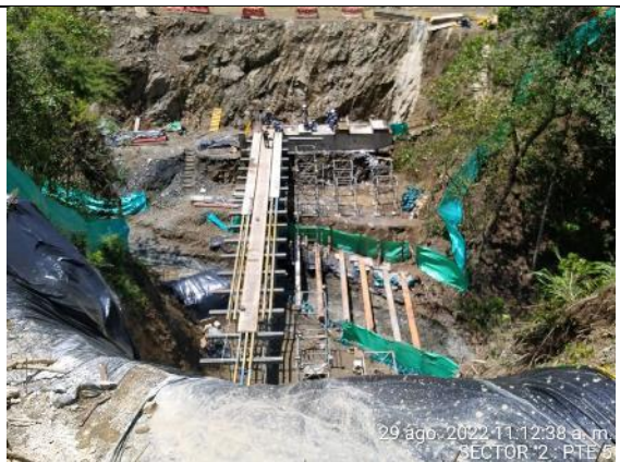
Fotografía 6. Ejecución de pista sobre andamios de carga para construcción de viga D
