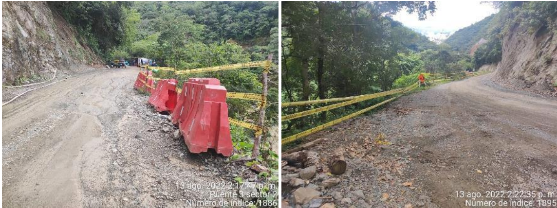
Imágenes Verificación señalización vertical y demarcación del corredor vía paralelo al río Tonusco
