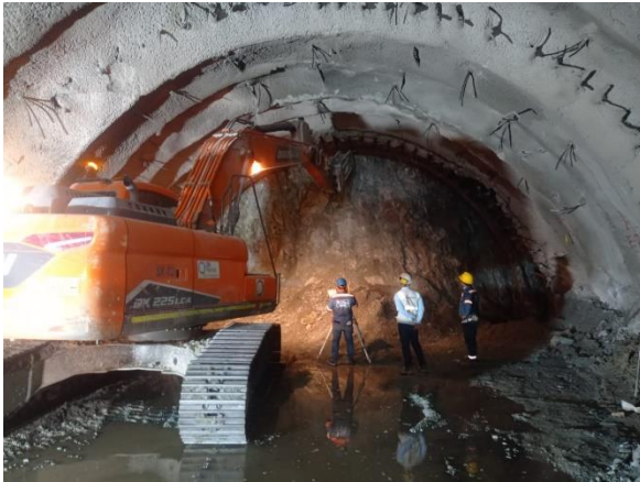
Foto No 11: Chequeo de instalación de arco metálico HEB100 Túnel 8 P.S Abs: K15+231.5
