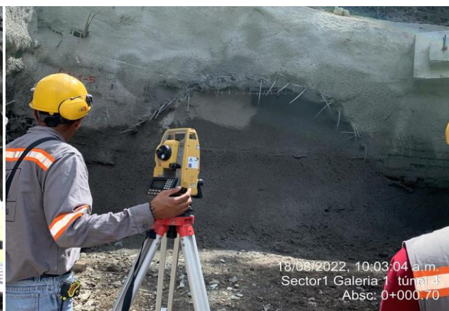
Foto No 8: Control topográfico para instalación de enfilajes portal entrada galería # 1 Abs: K0+000.70
