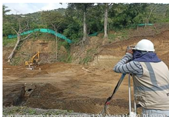
Foto No 2: Chequeo alineamiento alcantarilla k1+750.
