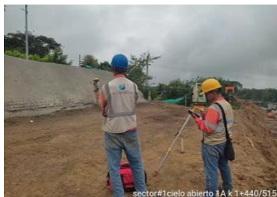
Foto No 16: Marcación chaflanes corte K1+440-K1+515 Margen izquierda
