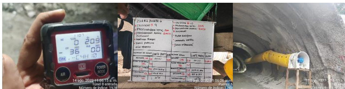
Registro documental tomado por la interventoría en campo: Medición de gases en túnel 8 y divulgación de medición de gases en actividades de caisson sector puente 6.
