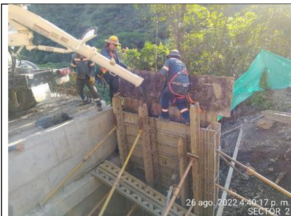
Fotografía 3. Hormigonado de aleta izquierda estribo 2.
