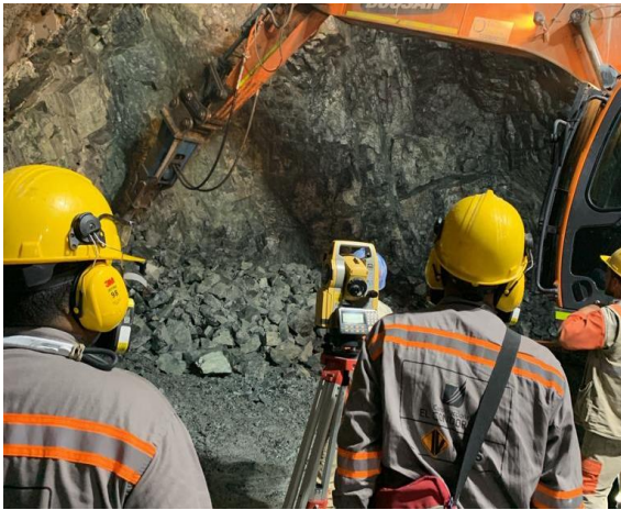
Foto No 13: Control de excavación – avance mecánico, túnel # 4.
