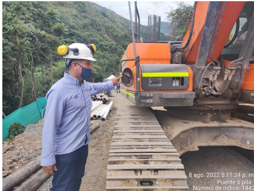
Registro fotográfico, inspección de maquinaria y equipo puente 6
