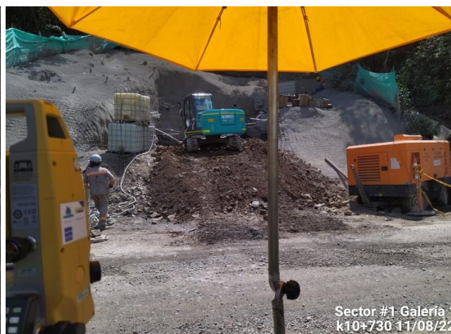
Foto No 4: Chequeo de excavación para Galería de escape # 1 Abs: K10+730.00
