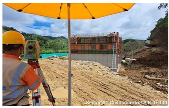
Foto No 18: Chequeo de niveles para vaciado de muros paso vehicular Abscisa k3+3450
