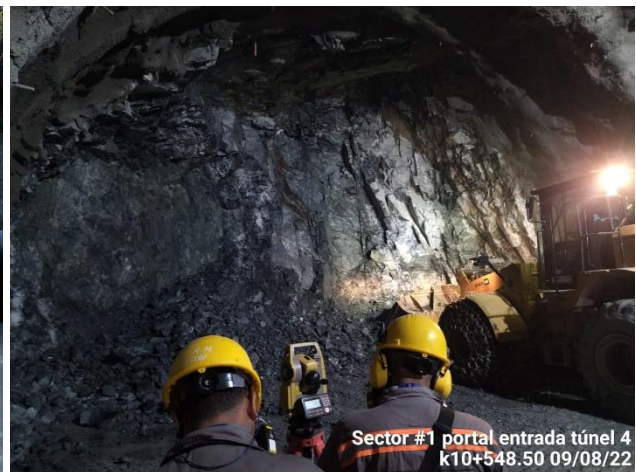
Foto No 2: Marcación de frente para avance de excavación terreno tipo 3 K10+548.50
