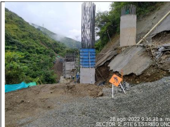
Fotografía 7. Construcción de columna circular 2 en estribo 1, concreto de 28 Mpa.
