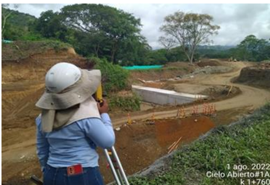
Foto No 3: Marcación niveles muros en canal abierto
