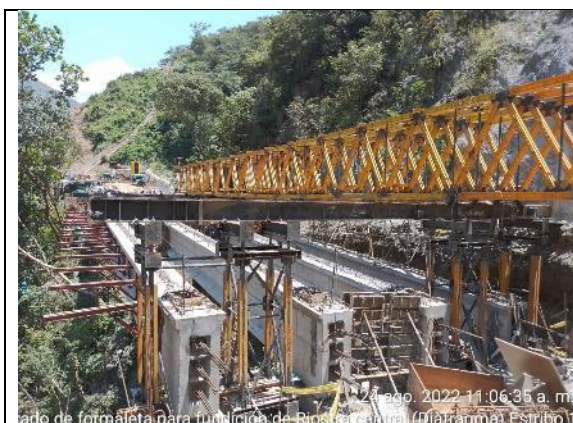
Fotografía 1. Avance de construcción de vigas postensadas.
