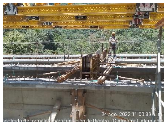
Fotografía 2. Avance de construcción de riostras en vano central.
