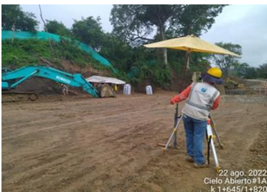
Foto No 15: Marcación de niveles para tubería doble Cielo abierto 1A
