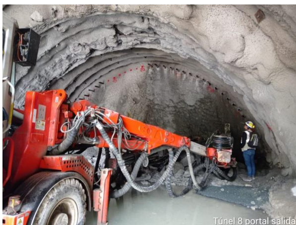
Foto No 5: Chequeo y posicionamiento de Jumbo para instalación de enfilajes K15+327 – Túnel 8 salida
