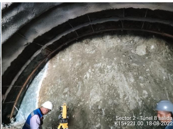
Foto No 8: Chequeo de instalación de arco metálico HEB100 Túnel 8 P.S Abs: K15+221.00
