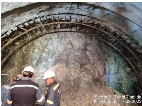
Foto No 7: Chequeo de instalación de arco metálico HEB100 Túnel 7 Portal salida Abs: K13+935.35
