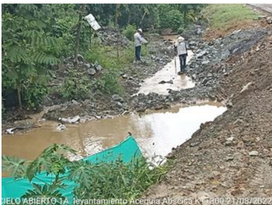
Foto No 11: Levantamiento acequia k1+300- k1+400
