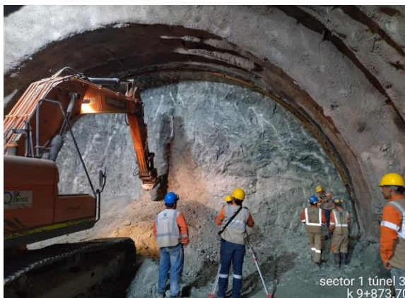
Foto No 11: Chequeo de instalación de arco metálico HEB100 Túnel 3 Abs: K9+873.70
