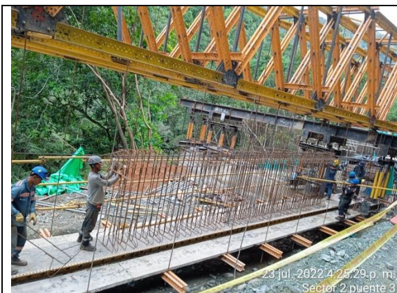
Fotografía No. 1 Armado de acero de refuerzo en viga D, sobre cimbra autoportante
