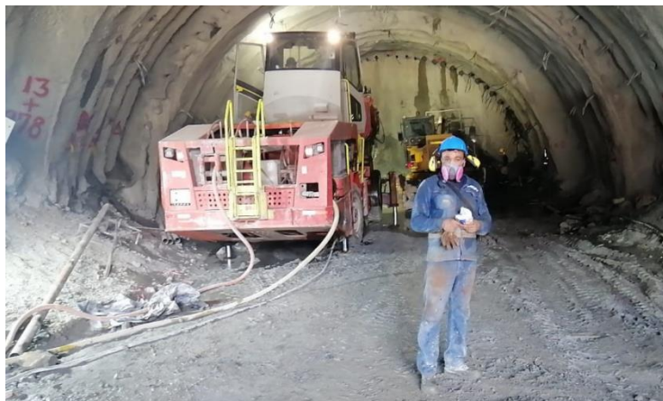
Foto: Entrega de EPP y dotación al personal de obra.
