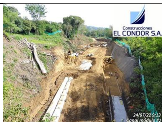
Foto No 14: 014 Chequeo localización segundo módulo canal en cielo abierto 1 A K1+645 – 665
