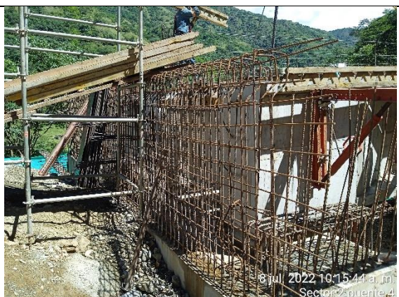
Fotografía No. 4 Armado de acero de refuerzo en el espaldar del estribo No. 1 para hormigonado.
