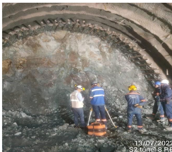
Foto No 4: Control de excavación y avance para instalación de arco-Túnel 8 P.E Abs: K15+064.25
