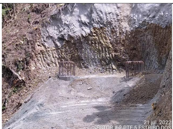
Fotografía No. 6 Adecuación de terreno para hormigonado de solado de limpieza para la construcción de la viga cabezal en estribo No. 2.
