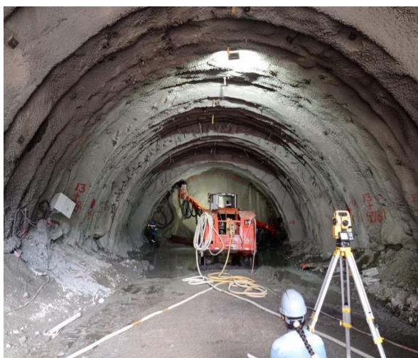
Foto No 3: Control de posición e inclinación a jumbo para instalación de enfilajes
