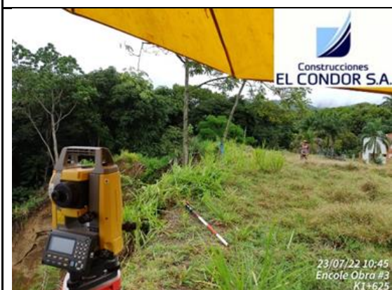
Foto No 13: 013 Chequeo localización encola obra hidráulica obra No 3 K1+625
