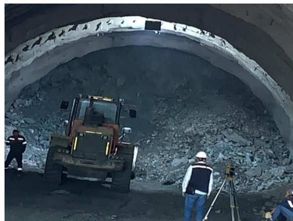
Foto No 12: Control de excavación y avance para instalación de arco-Túnel 8 P.E Abs: K15+076.25
