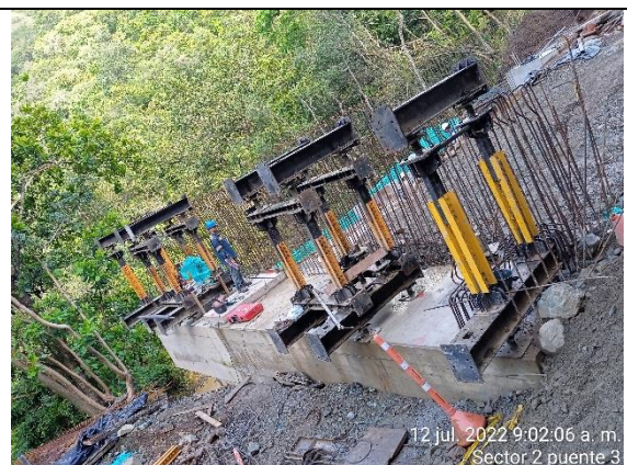
Fotografía No. 2 Apoyos de neoprenos hormigonados sobre viga cabezal y armado de cimbra autoportante
