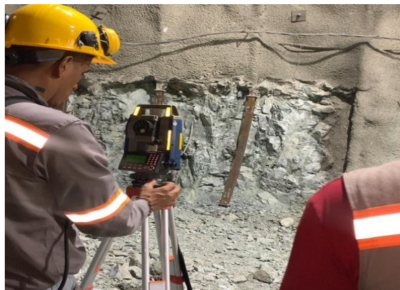
Foto No 12: Instalación de piezas inferiores ( patas ) de arco metálico HEB 100 Túnel 3 – K9+840.00
