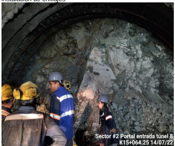
Foto No 3: Control de posición e inclinación a jumbo para instalación de enfilajes
