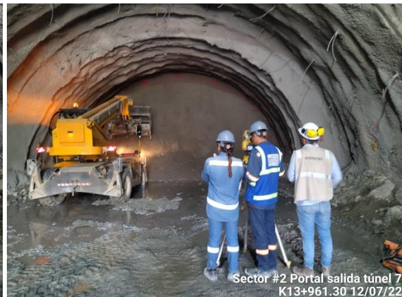
Foto No 2: Marcación para perforación de enfalajes Túnel # 7 Abs: K13+961.30
