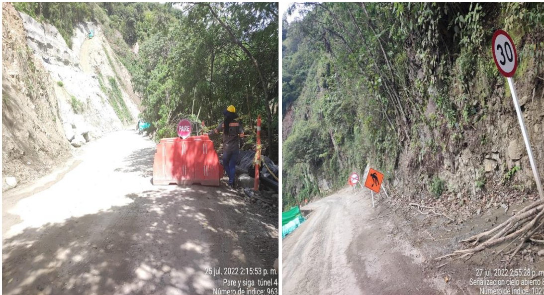
Foto: Inspección de PMT. Auxiliares de transito y señales de aproximación de obra.
