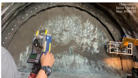
Foto No 11: Chequeo de instalación de arco metálico HEB100 Túnel 3 Abs: K9+873.70
