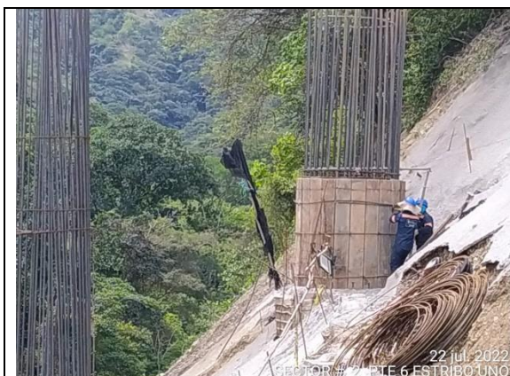
Fotografía No. 7 Construcción de pila sobre caisson No. 1 en estribo No. 1.
