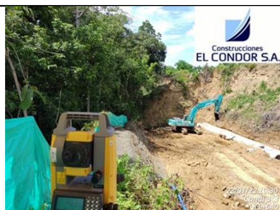
Foto No 10: 010 Chequeo alineamiento tubería alcantarilla cielo abierto 1 A K1+640
