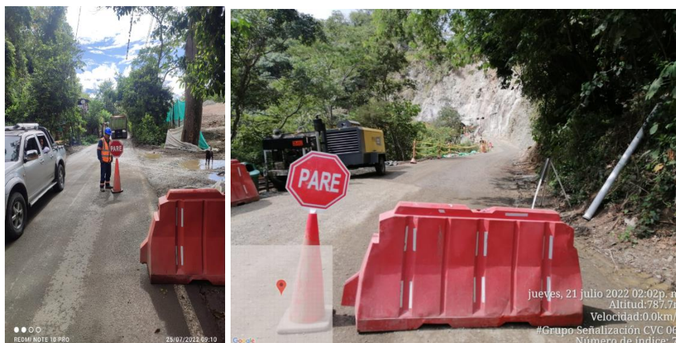
Foto: Inspección de PMT. Auxiliares de tránsito y señales de aproximación de obra.
