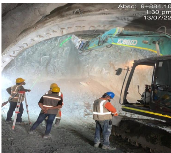
Foto No 5: Control de excavación – Túnel 3 Abs: K9+844.10
