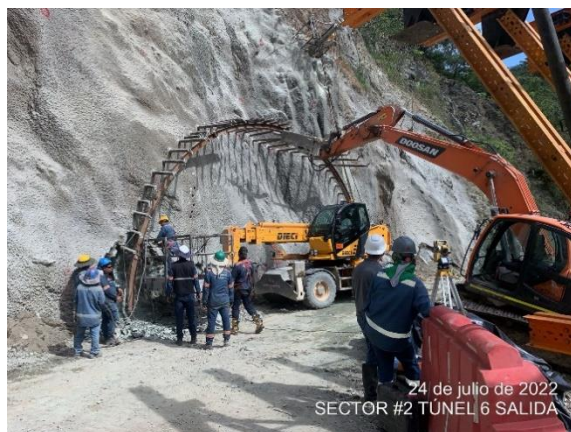
Foto No 10: instalación de arco metálico HEB100 Túnel 6 (Arco falso) P.S Abs: k12+099.00
