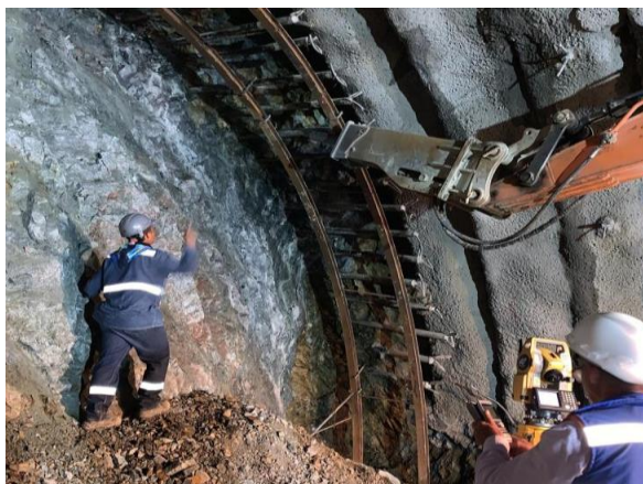
Foto No 11: Chequeo de instalación de arco metálico Túnel 7 P.S Abs: K13+955.60
