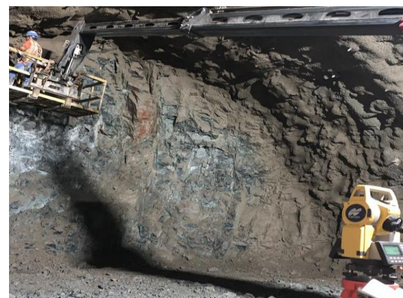
Foto No 10: Marcación de frente (límite de excavación) para avance Túnel 4 Abs: K10+492.60
