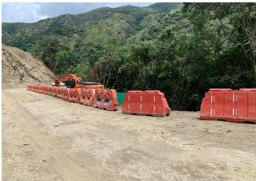
Foto: Inspección de PMT. Señalización de obra.
