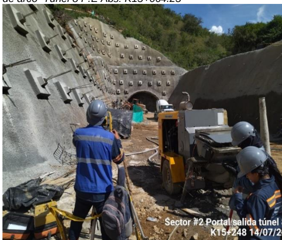
Foto No 4: Control de excavación y avance para instalación de arco-Túnel 8 P.E Abs: K15+064.25
