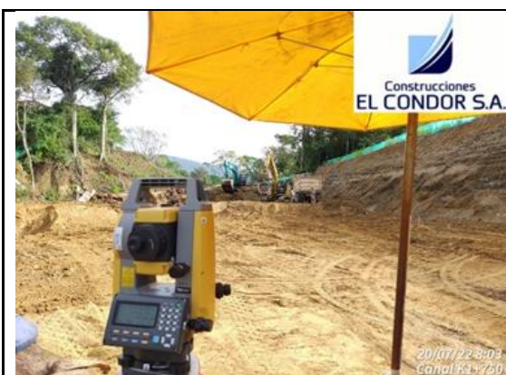
Foto No 9: 009 Marcación de alineamiento de canal Cielo Abierto 1 A K1+750
