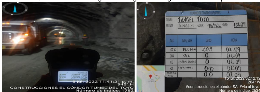
Foto: Medición de gases en túneles y registro en tablero de resultados arrojados por el equipo de medición. Se considera aire respirable y apto para trabajo en espacio confinado.
