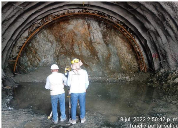
Foto No 1: Chequeo de instalación de arco metálico HEB100 Túnel 7 Abs: K1+966.60m
