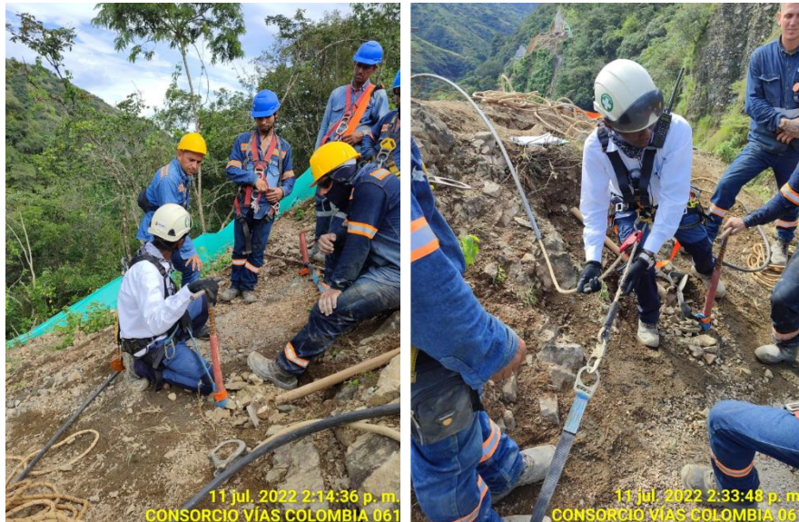
Foto: Acompañamiento capacitación e inspección de actividades de trabajo en alturas, inspección de eslingas, arnés, puntos de anclajes y preoperacionales de los equipos de alturas.
