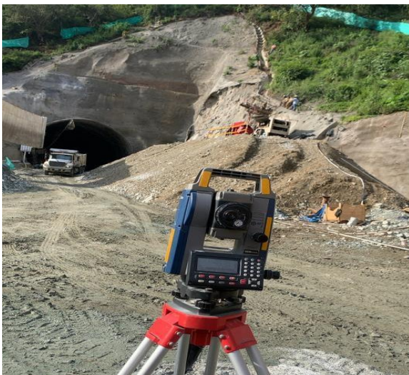
Foto No 3: Monitoreo Portal entrada Túnel 3
