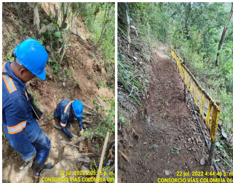
Foto: Señalización de seguridad en borde de vía con cinta de señalización y mejoramiento de accesos.
