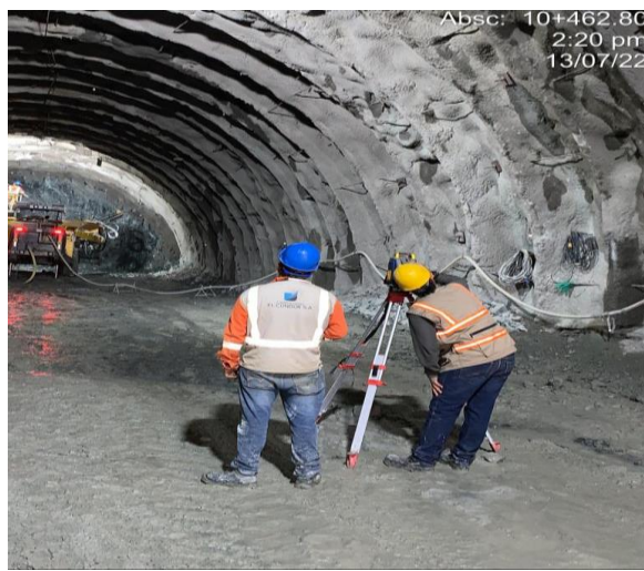
Foto No 6: Lectura y monitoreo de estaciones de convergencias – Túnel # 4
