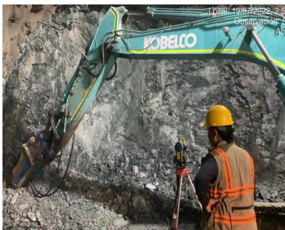
Foto No 7: Control de excavación y avance Terreno tipo 3 Túnel 4 Abs: K10+485.50
