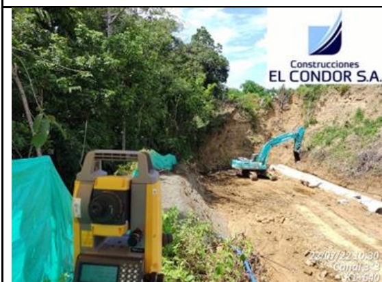
Foto No 11: 011 Chequeo alineamiento tubería alcantarilla cielo abierto 1 A K1+640
