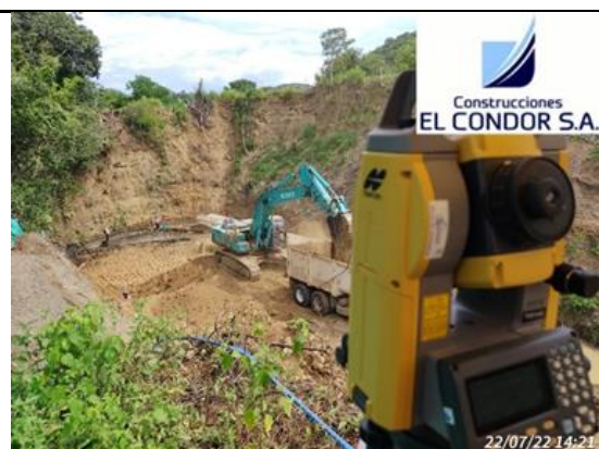
Foto No 12: 012 Chequeo excavación canal abierto Cielo Abierto 1 A K1+640 – 710
