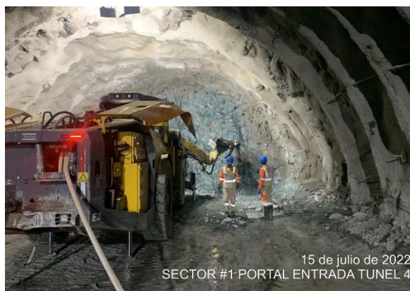
Foto No 14: Localización y control del esquema para barrenación de frontón Túnel # 4
