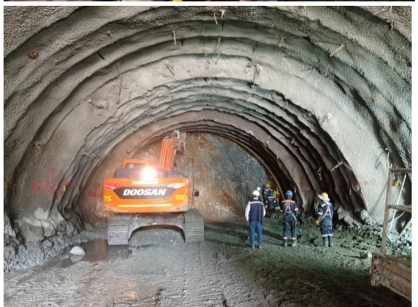
Foto No 9: Chequeo de instalación de arco metálico HEB100 Túnel 7 P.S Abs: K13+957.60
