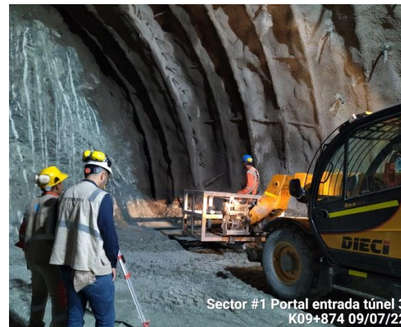
Foto No 4: Localización de pernos sistemáticos Túnel 3
