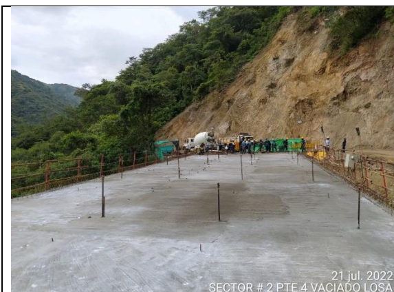
Fotografía No. 3 Tablero del puente hormigonado en concreto de 28 Mpa.
