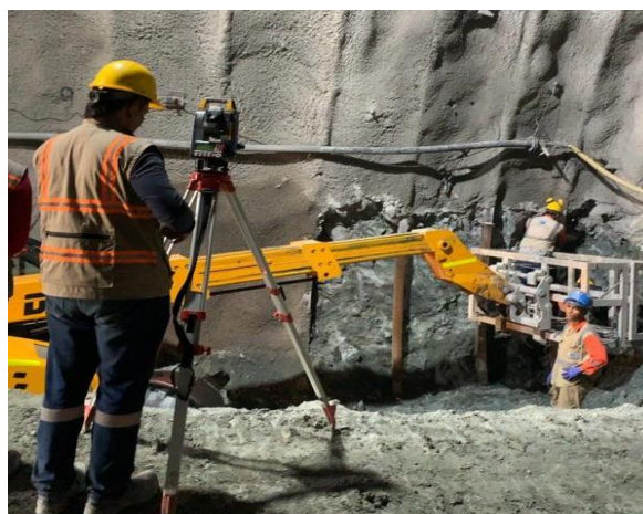
Foto No 8: Instalación de piezas inferiores arco metálico HEB 100 Túnel 3 – K9+853.60
