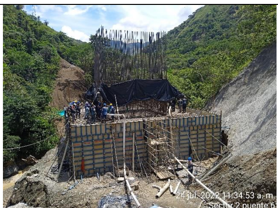
Fotografía No. 8 Hormigonado de dado de pila No. 1 e instalación parcial de acero de refuerzo.
