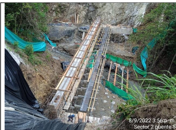
Fotografía 5. Instalación de pista para construcción de vigas
