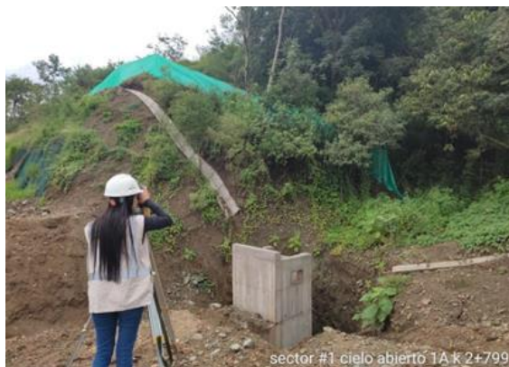
Foto No 24: Cielo abierto 1A k 2+799 levantamiento obra hidráulica #11 encole y descole
