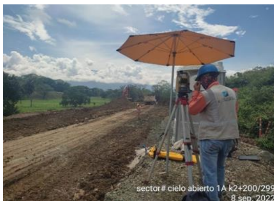
Foto No 14: Cielo abierto 1A k 2+200-299 Marcación de anchos de vía cajero y marcación de niveles para mejoramiento, acompañamiento a las actividades realizadas por el contratista
