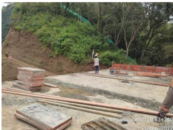
Foto No 35: cielo abierto 1 B k 3+340 instalación de puntos de control y levantamiento de los puntos losa superior paso vehicular
