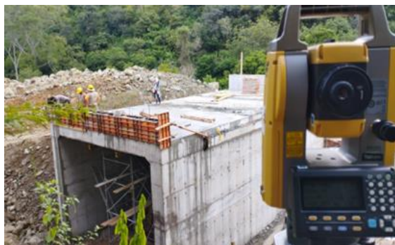
Foto No 34: cielo abierto 1B k 3+340 acompañamiento a marcación inicial de muro tierra armada
