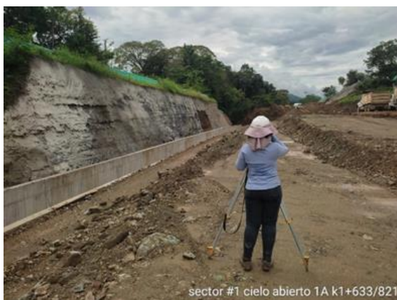
Foto No 1: cielo abierto 1A k1+633-821 levantamiento del canal 3x3
