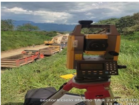
Foto No 23: cielo abierto 1A k 2+915-00 marcación de anchos de vía cajeo y marcación de niveles para mejoramiento, acompañamiento a las actividades realizadas por el contratista
