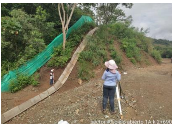
Foto No 9: Cielo abierto 1A k2+690 levantamiento zanja de coronación
