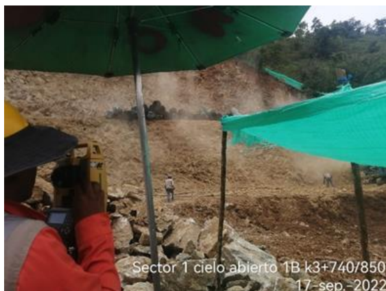
Sector 1 cielo abierto 1B k3+740/850 17 sep. 2022 Foto No 017 cielo abierto 1B k 3+740-850 Marcación de pernos y perfilación del talud, terraza 4 fila 2
