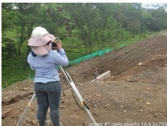
sector #1 cielo abierto 1A k 2+799 Foto No 25: Cielo abierto 1A k 2+799 levantamiento obra hidráulica #11 encole y descole
