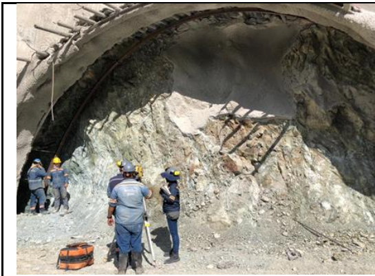
Foto No 9: Chequeo de posición en instalación de arco #1 T. tipo V – Abs: K12+104.36– Túnel 6 P.S 15+198.10
