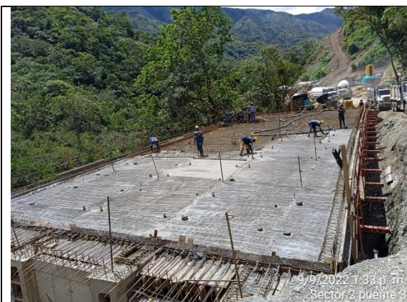
Fotografía 1. Hormigonado en concreto de 28 Mpa de tablero
