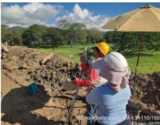
Foto No 21: cielo abierto 1A k 2+110-180 marcación de anchos de vía cajeo y marcación de niveles para mejoramiento, acompañamiento a las actividades realizadas por el contratista (2)
