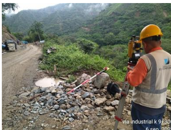
Foto No 46: levantamiewp vía industrial k9+300
