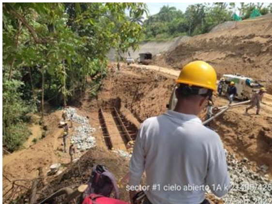
Foto No 39: cielo abierto 1A k 1+405-425 acompañamiento a marcación de niveles ciclópeo
