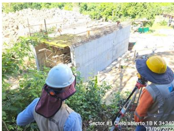
Foto No 22: Cielo abierto 1B k3+340 chequeo de niveles losa superior modulo 1 paso vehicular, acompañamiento a las actividades realizadas por el contratista
