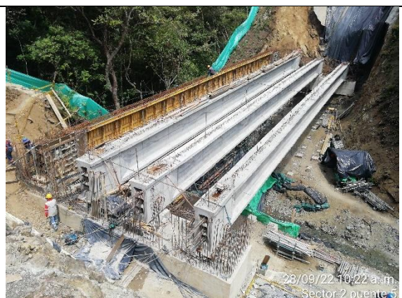
Fotografía 6. Aspecto de construcción de vigas postensadas
