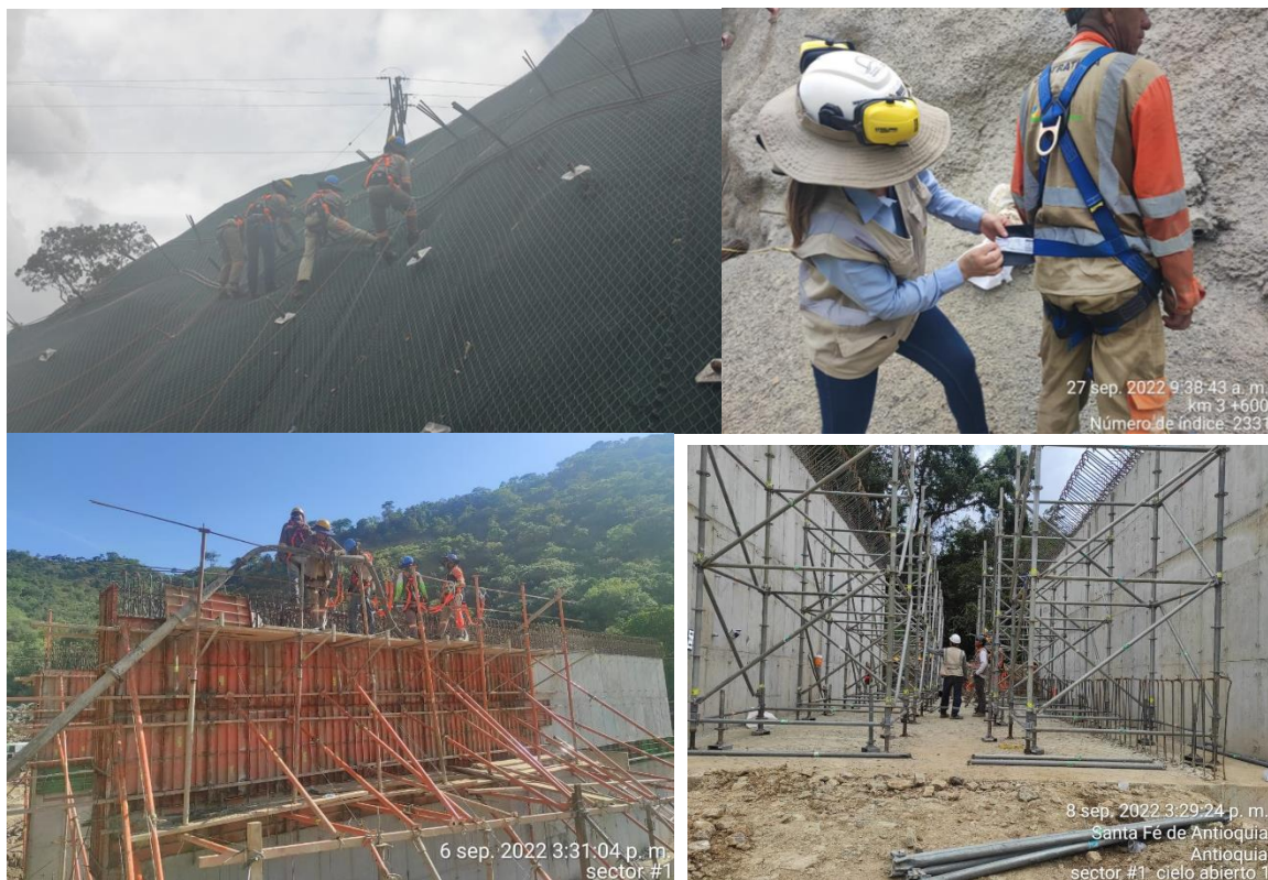
Inspección de andamios y barandas en actividades críticas.
