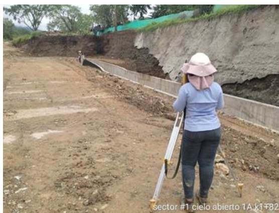
Foto No 2: Cielo abierto 1A k 1+821 levantamiento del boxcoulvert 3x3 obra hidráulica #5A
