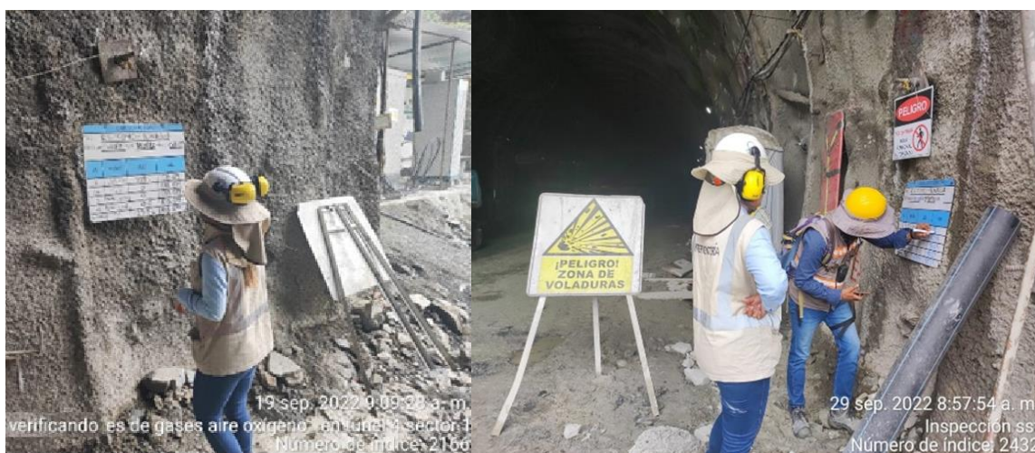
Verificación en campo de la divulgación de las mediciones de gases en la entrada de los túneles.
