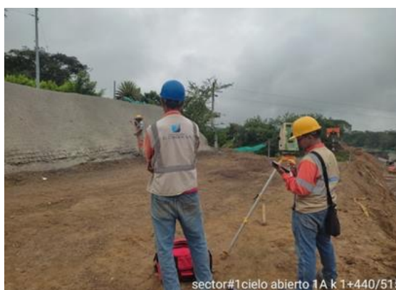
Foto No 12: Cielo abierto 1A k 1+440-513 marcación de chafianes para perfilación de talud margen izquierda, acompañamiento a las actividades realizadas por el contratista
