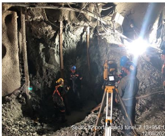
Foto No 6: Chequeo de instalación de patas de arco # 2 y # 3 Costado derecho – Abscisa: K13+954.10 / 952.60
