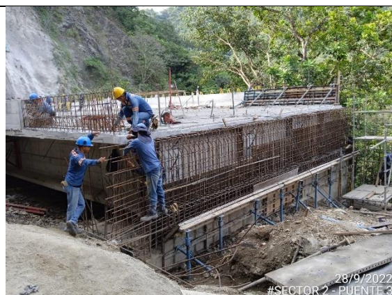
Fotografía 2. Avance de construcción de defensas de concreto tipo New Jersey y espaldar del estribo No. 2.
