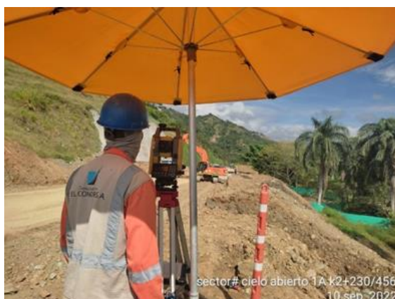
Foto No 18: Cielo abierto 1A K2+230-456 Marcación de anchos de vía cajero y marcación de niveles para mejoramiento margen derecha, acompañamiento a las actividades realizadas por el contra
