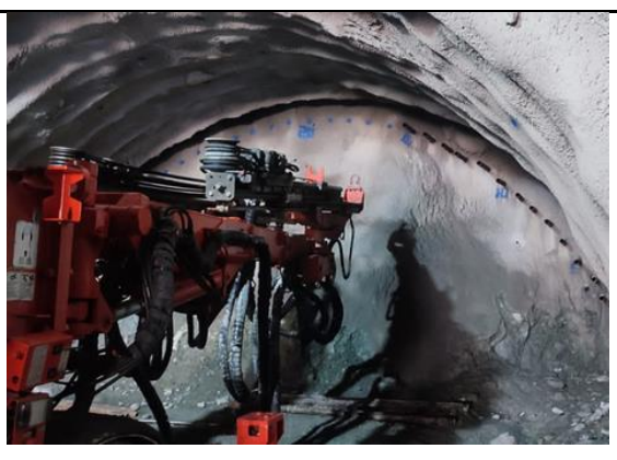
Foto No 2: Marcación para perforación de enfilajes Túnel # 8 P. Salida Abs: K15+205.40
