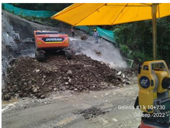
Foto No 45: Galería #1 control de corte y perfilación de talud para excavación de galería #1
