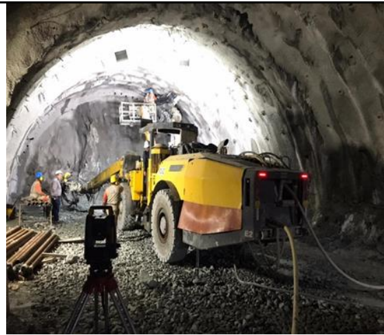
Foto No 13: Marcación para perforación de enfilajes Túnel # 3 Abs: K9+982.80
