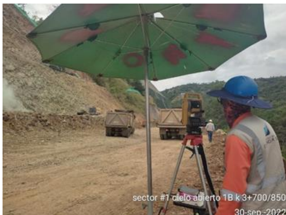
Foto No 41: cielo abierto 1B k 3+700-850 marcación de pernos y drenes terraza #4
