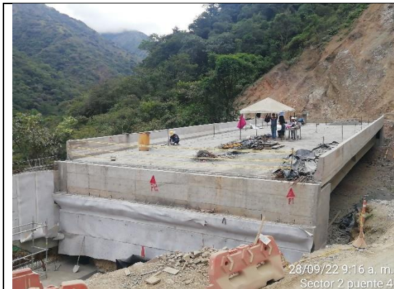
Fotografía 3. Defensas de concreto tipo New Jersey terminados.
