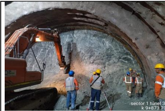
Foto No 11: Chequeo de instalación de arco metálico HEB100 Túnel 3 Abs: K9+873.70
