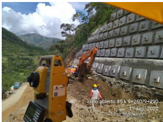
Foto No 42: ocalización de anclajes cielo abierto 5 Banco 1 K9+170
