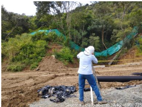
Foto No 33: cielo abierto 1A k 2+690-735 levantamiento zanja de coronación
