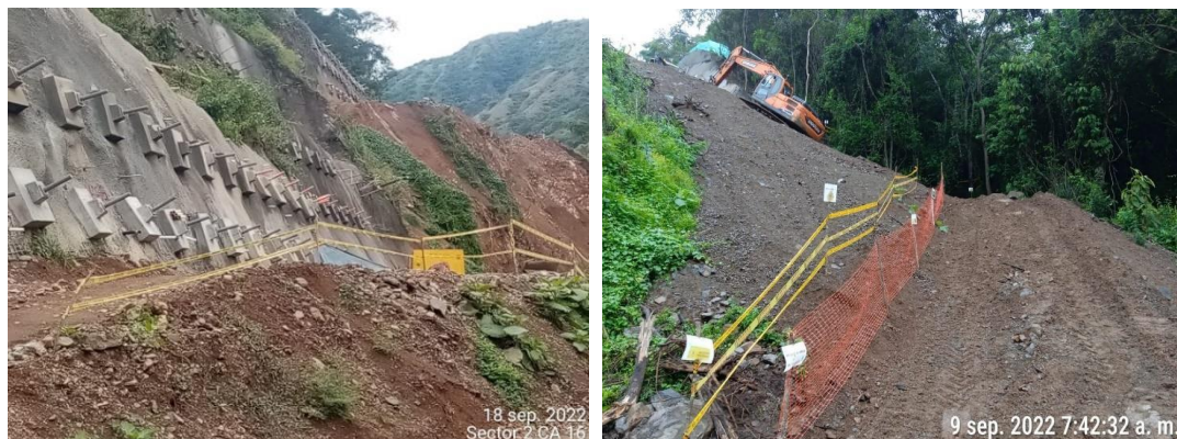
Durante los recorridos de obra se han vengo verificando la adecuación de accesos peatonales en los diferentes frentes de trabajo con su debida demarcación.
