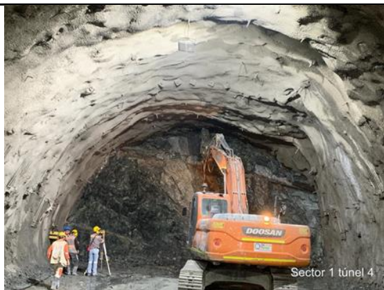
Foto No 5: Control de excavación – Túnel 4 Absc: 10+673.60 Abs: K9+844.10
