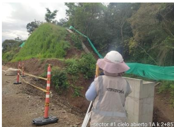
Foto No 6: Cielo abierto 1A k 2+857 levantamiento obra hidráulica #12
