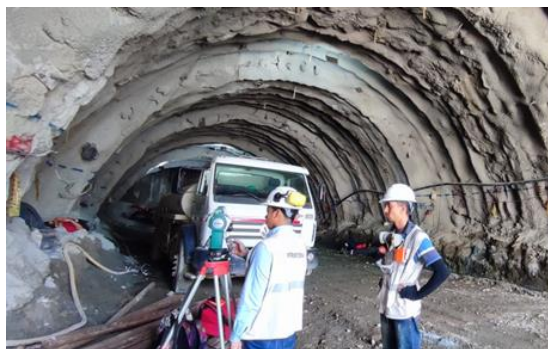
Foto No 8: Levantamiento topográfico para chequeo de secciones de excavación y avance. Túnel 8 P. Salida.
