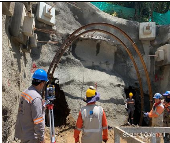
Foto No 8: Instalación de dos Arcos para emportalamiento de inicio de Galería.1
