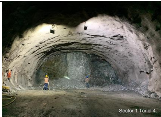
Foto No 10: Marcación de frente (límite de excavación) avance Túnel 4 Abs:10+753.50
