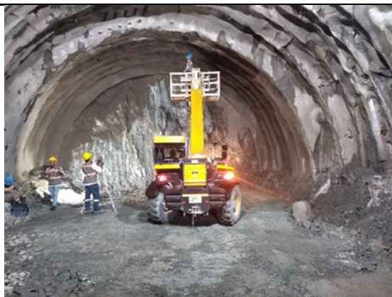
Foto No 6: Marcación para perforación de enfilajes Túnel # 3 Abs: K9+888.40
