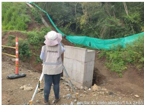
Foto No 4: Cielo abierto 1A k 2+857-799 levantamiento zanja de coronación
