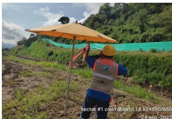
Foto No 38: cielo abierto k2+590-650 1A marcación de ancho de vía cajero y marcación de niveles para mejoramiento
