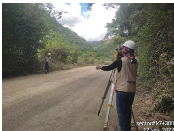
Foto No 20: cielo abierto 2 Replanteo puntos línea predial k 7+300
