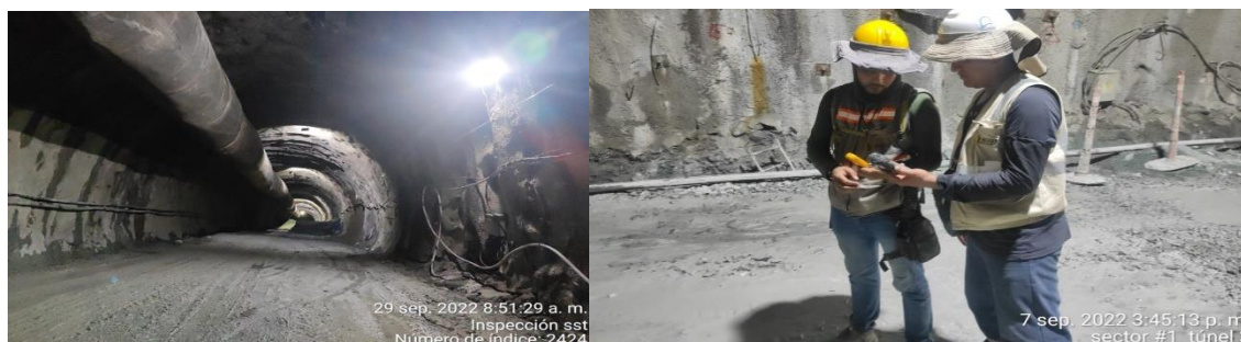
Registro documental: Verificación de iluminación, medición de gases y el funcionamiento del equipo extractor de aire en túneles.
