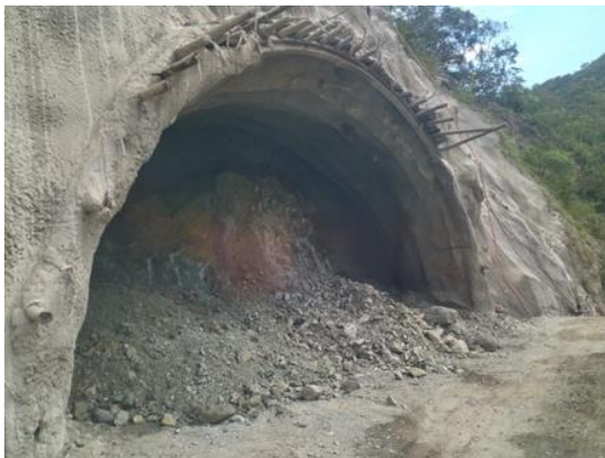
Foto No 11: Chequeo de excavación para instalación de arco # 5 tipo V – túnel 6 p. salida – Abs 12+099.35
