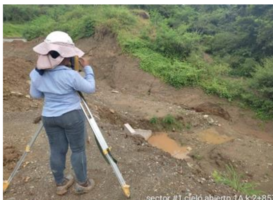
Foto No 8: cielo abierto 1A k2+857 levantamiento obra hidráulica #12 encole descole
