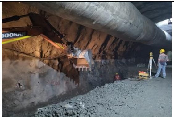
Foto No 12: Tunel 4 Hastial derecho: Perfilacion de banco izquierdo en k10+56
