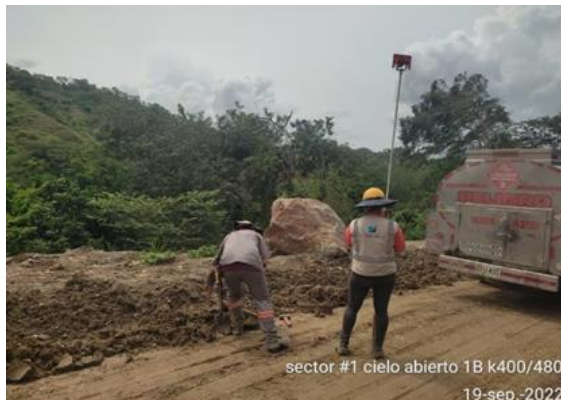
Foto No 34: cielo abierto 1B k 3+340 acompañamiento a marcación inicial de muro tierra armada
