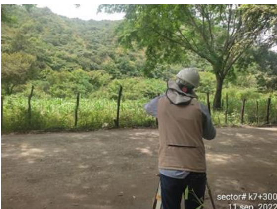
Foto No 19: Cielo abierto 2 Replanteo puntos línea predial k 7+300
