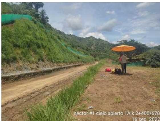
sector #1 cielo abierto 1A k 2+400/670 16 sep. 2022 Foto No 27: Cielo abierto 1A K2+400-690 Marcación de anchos de vía cajeo y marcación de niveles para mejoramiento margen derecha, acompañamiento a las actividades realizadas por el
