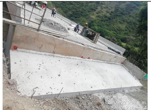
Fotografía 4. Losa de aproximación de estribo No. 2..
