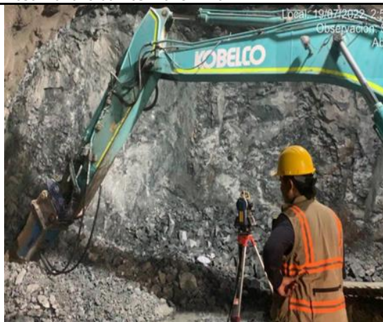
Foto No 7: Control de excavación y avance Terreno tipo 3 Túnel 4 Abs: K10+485.50
