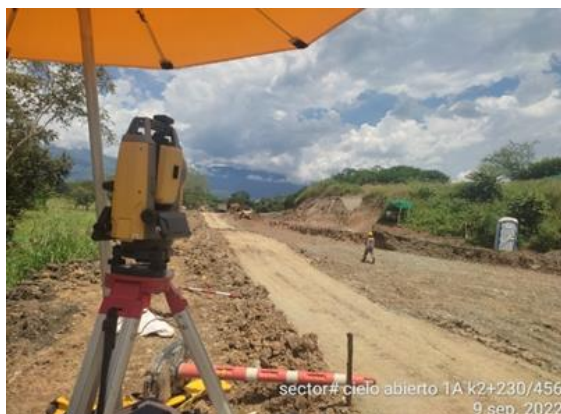
Foto No 16: Cielo abierto 1A levantamiento para diseño de canal k 2+240-456, Marcación de anchos de vía cajero y marcación de niveles para mejoramiento k2+230-456 margen izquierda
