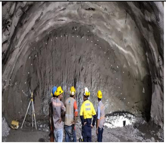
Foto No 14: Localización y control del esquema para barrenación de frontón Túnel # 4 10+749
