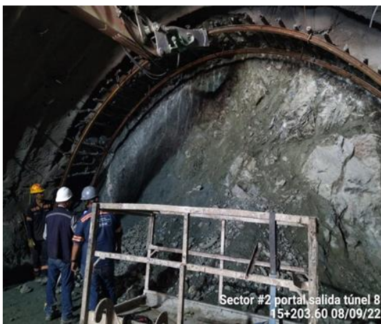
Foto No 5: Chequeo de instalación de arco metálico HEB100 # 0 – # 2 Túnel 8 P.S Abs: K15+203.60 / 205.10
