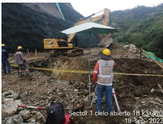
Foto No 31: Cielo abierto 1B k 3+490 instalación de tacos para excavación de solado, obra hidráulica #17
