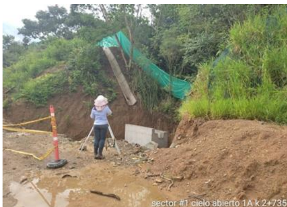
sector #1 cielo abierto 1A k 2+735 Foto No 29: cielo abierto 1A k2+735 levantamiento obra hidráulica #10 encole y descole
