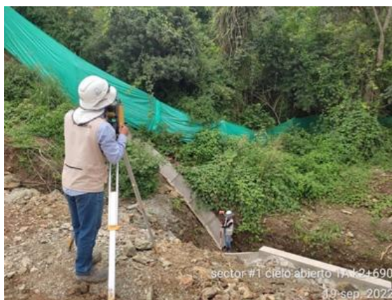
Foto No 32: cielo abierto 1A k 2+690 levantamiento obra hidráulica #9
