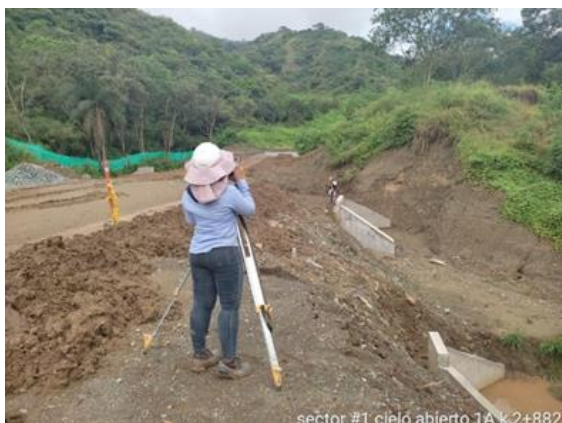
Foto No 5: Cielo abierto 1A k2+882 levantamiento boxcoulvert 2x2 obra hidráulica #13
