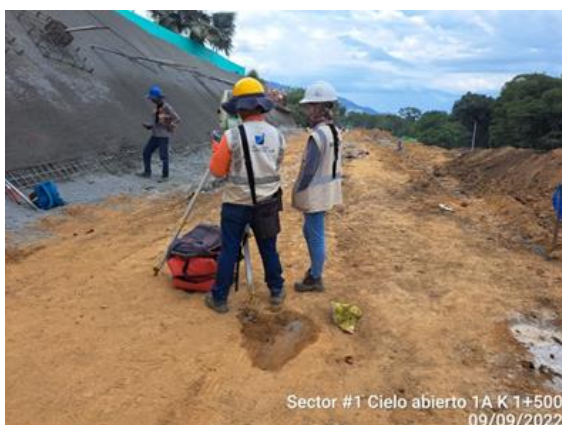
Foto No 17: Cielo abierto 1A Marcación de anclajes y drenes fila #2 terraza 1 k1+490 margen derecha
