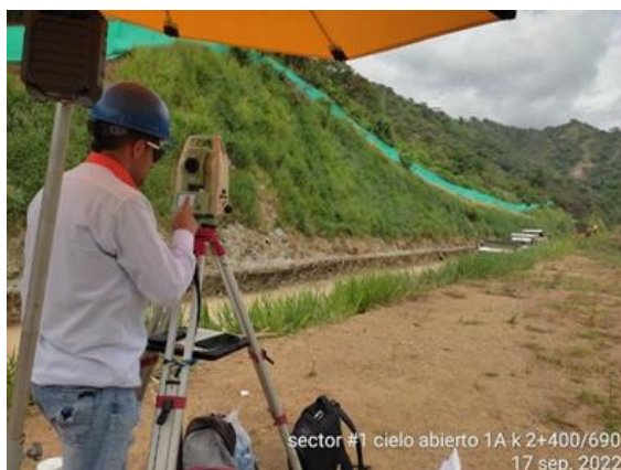
sector #1 cielo abierto 1A k 2+400/690 17 sep. 2022 Foto No 26: Cielo abierto 1A K2+400-690 Marcación de anchos de vía cajeo y marcación de niveles para mejoramiento margen derecha, acompañamiento a las actividades realizadas por el
