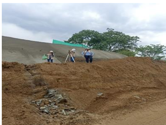
Foto No 10: Cielo abierto 1A k 1+525 levantamiento terreno para obra #3
