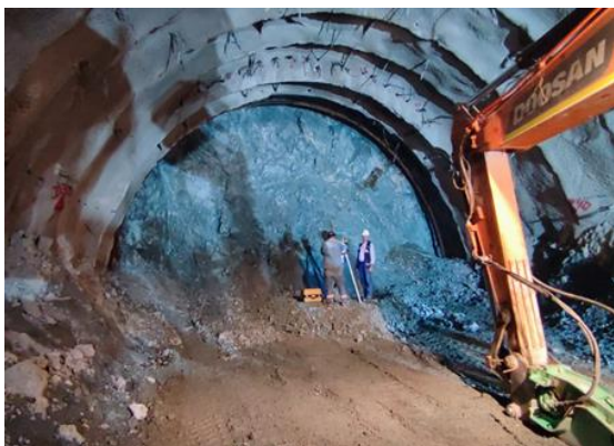
Foto No 3: Instalación de arco # 4 tipo IV Túnel 8 P. Salida Abs K15+113.00
