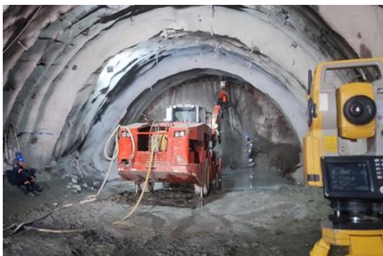
Foto No 7: Chequeo de posición y orientación de Jumbo para iniciar perforación de enfilajes – Abscisa: K15+199.10
