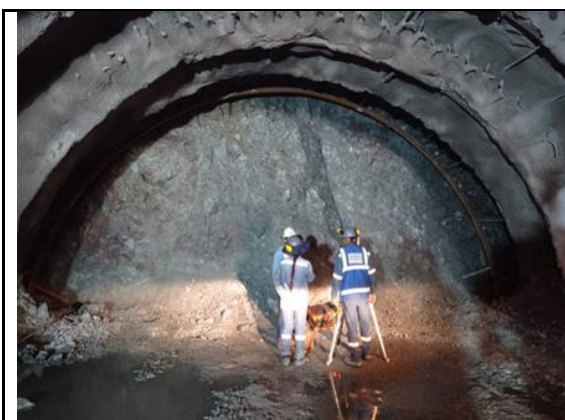
Foto No 1: Chequeo de instalación de arco metálico HEB100 Túnel 7 P. Salida Abs: K13+921.3 0m
