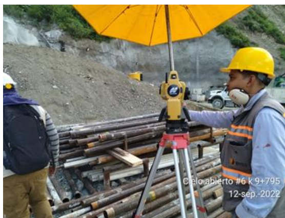
Foto No 44: Cielo abierto #6 corte y perfilación de talud k 9+795
