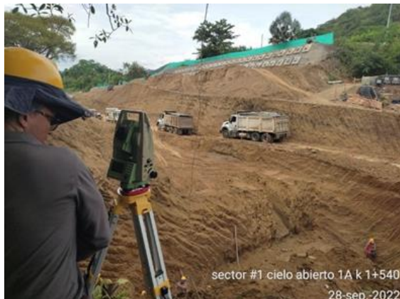
Foto No 40: cielo abierto 1A k 1+540 acompañamiento a chequeo niveles de excavación para solado obra hidráulica #2 y levantamiento de la excavación
