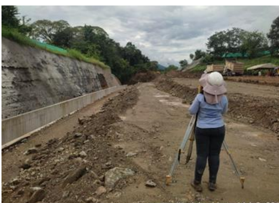
Foto No 11: Cielo abierto 1A k 1+821 Levantamiento del terraplén para filtro del canal
