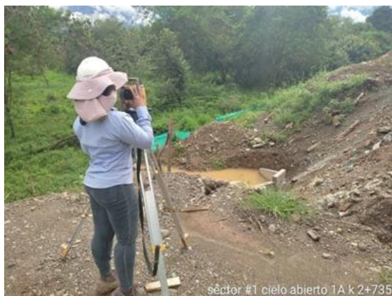
sector #1 cielo abierto 1A k 2+735 Foto No 30: cielo abierto 1A k2+735 levantamiento obra hidráulica #10
