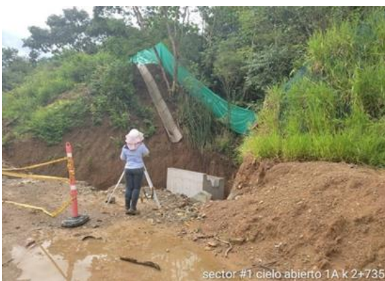
Foto No 7: Cielo abierto 1A k2+735 levantamiento zanja de coronación
