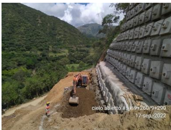
Foto No 43: cielo abierto #5 control de corte y perfilación de talud k9+260
