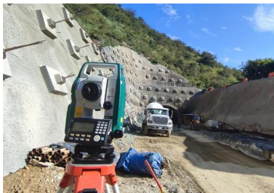
Foto No 4: Lectura y monitoreo de puntos de Control – Portal salida Túnel 8 – K15+247.5
