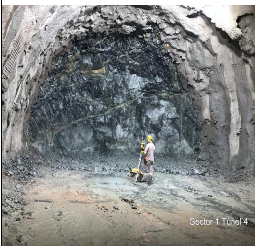
Foto No 7: Control de excavación y avance Terreno tipo III Túnel 4 chequeo de Perfilación de frontón km: 10+825.20 y toma de secciones de excavación.
