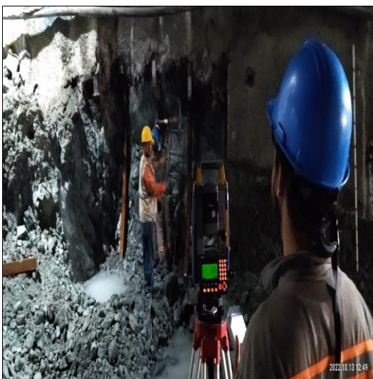
Foto No 13: Acompañamiento Túnel 3 chequeo liberación y toma de secciones de patas de arcos #5 k9+929.60 #6 k9+930.60 #7 k 9+931.40 #1 k9+932.00
