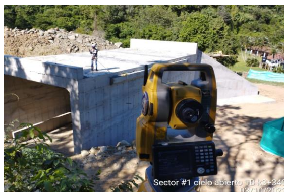
Foto No 6: Cielo abierto 1B k 3+340 levantamiento puntos de control losa superior paso vehicular
