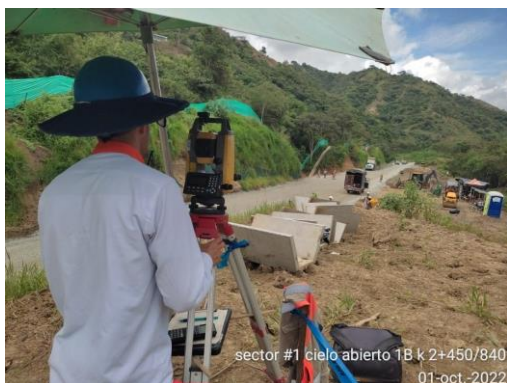
Foto No 1: Cielo abierto 1A k 2+450-840 instalación de tacos para niveles sub base, acompañamiento a las actividades realizadas por el contratista
