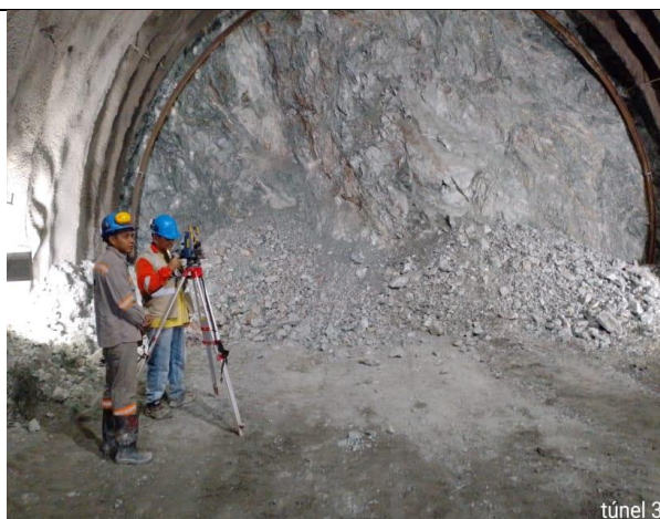
Foto No 10: Túnel 3 Chequeo y liberación de arco #7.
