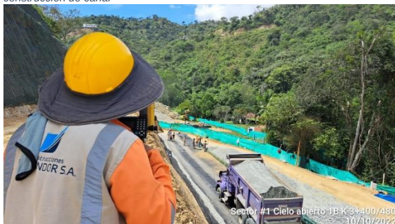
Foto No 21: Cielo abierto 1A k 2+300 cheque excavación mecánica para construcción de canal
