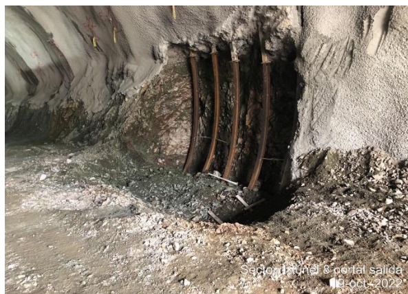
Foto No 10: Túnel 8 PORTAL SALIDA. Instalación de patas banco izquierdo KM 15+230,30 a KM 15+227,30 Terreno tipo IV.
