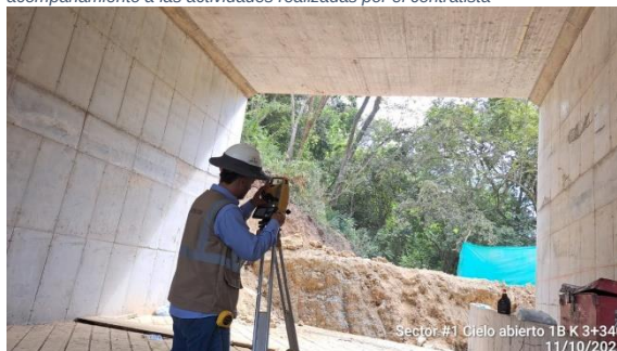
Foto No 22: Cielo abierto 1A k2+240-280 instalación de tacos para sub base en acompañamiento a las actividades realizadas por el contratista
