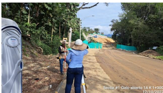
Foto No 25: Cielo abierto 1A k 1+300 levantamiento topográfico terreno natural
