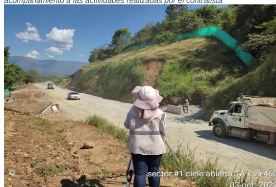
Foto No 4: Cielo abierto 1A k 2+460 levantamiento obra hidráulica #8
