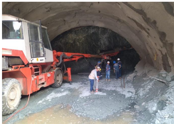
Foto No 8: Túnel 6 PORTAL Salida. Se levantó excavación para la instalación de arco noruego KM 12+090.65
