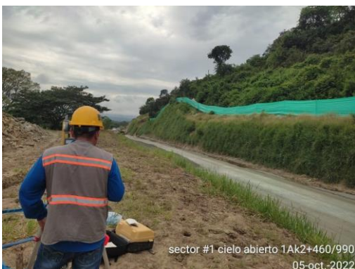
Foto No 11: Cielo abierto 1A k2+460-990 chequeo de tacos niveles para sub base, acompañamiento a las actividades realizadas por el contratista
