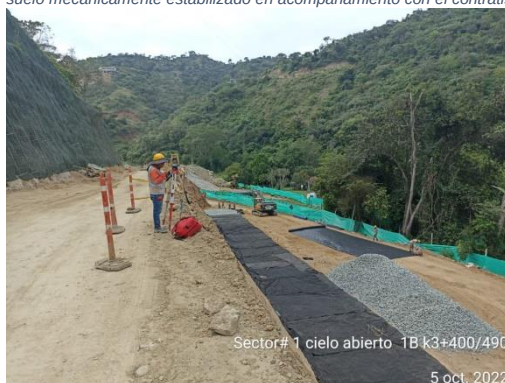
Foto No 12: Cielo abierto 1B k3+400-480 marcación alineamiento en muro en suelo mecánicamente estabilizado
