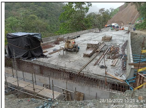
Fotografía 1. Construcción en concreto de 28 Mpa de espaldar del estribo 1.
