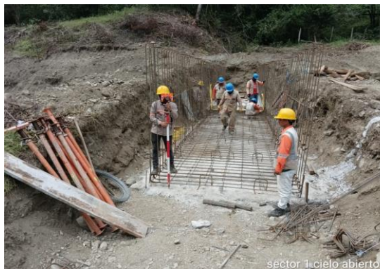
Foto No 42: Cielo abierto 4k8+294 chequeo cotas niveles de solado box coulver
