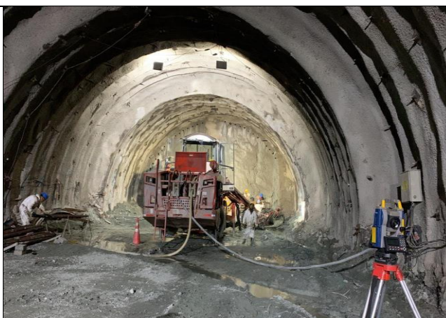
Foto No 2: Túnel 3. km: 10+039.00 seguimiento a la perforación para instalación de enfilajes
