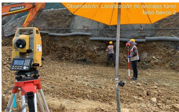
Foto No 47: túnel falso k9+560 chequeo de localización para anclajes
