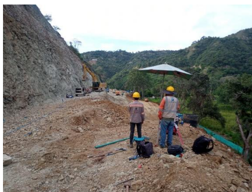
Foto No 20: Cielo abierto 1B k 3+700-850 chequeo corte y perfilación de talud terraza 5
