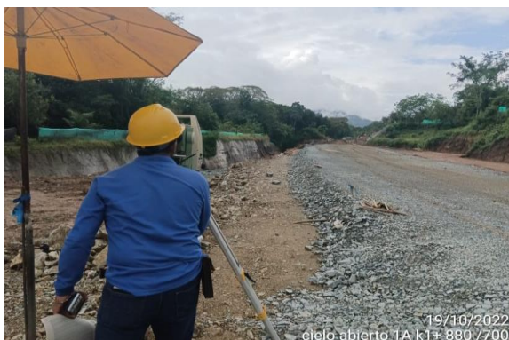
Foto No 33: Cielo abierto 1A k 1+700-880 marcación de bordes y niveles para corona sub rasante
