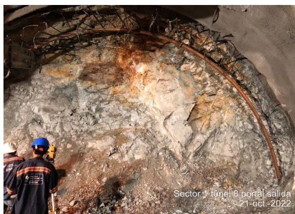
Foto No 12: Túnel 8 PORTAL SALIDA Chequeo e instalación de arco # 1 KM 15+171,20 consecutivo # 80
