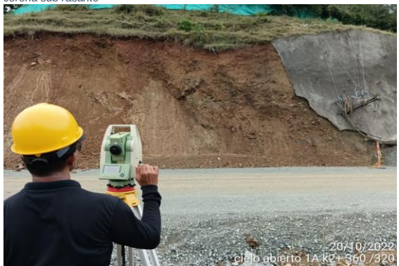
Foto No 35: Cielo abierto 1A k2+320-360 localización y marcación de pernos, terraza 1
