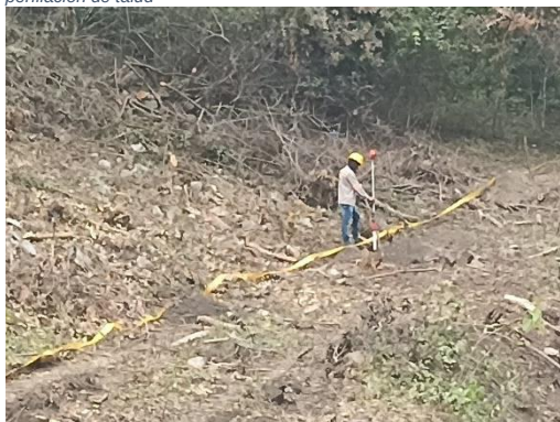
Foto No 41: Cielo abierto 4 k8+350 referenciación de tubería 8, red de agua
