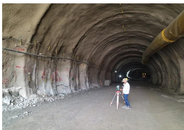
Foto No 6: Túnel 7 PORTAL Salida. Se realizó levantamiento de lanzado desde la KM 13+731 hasta KM 13+701
