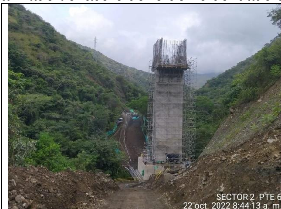
Fotografía 7. Construcción de dovelas 0 y 1 en pila 1 en concreto de 42 Mpa.
