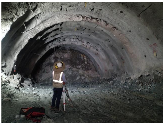
Foto No 7: Túnel 8 PORTAL Salida. Se realizó el levantamiento faltante del regularizado KM 15+225-200
