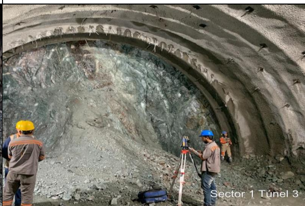
Foto No 16: Túnel 3. km 9+990.90. Acompañamiento en chequeo de excavación para instalar arco#3. Y toma de secciones
