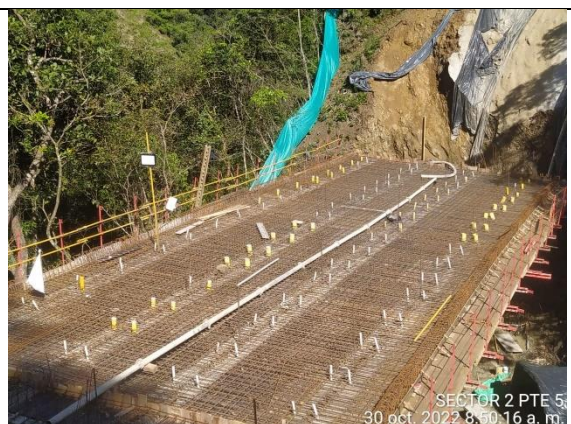
Fotografía 6. Instalación de parrillas de acero de refuerzo, previo al hormigonado del tablero
