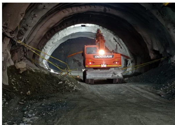
Foto No 14: Túnel 7 PORTAL SALIDA Chequeo de excavación mecánica para instalación arco, terreno tipo IV KM 13+896.10
