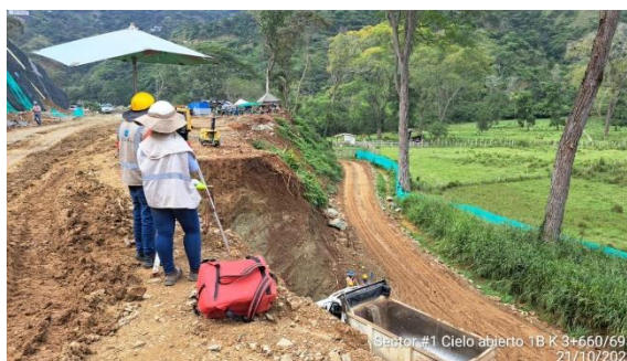
Foto No 38: Cielo abierto 1 B k 660-690 chequeo de excavación y marcación de niveles para mejoramiento en muro (SME) acompañamiento a las actividades
