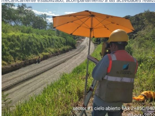
Foto No 5: Cielo abierto 1A k2+850-040 instalación de tacos para niveles sub base, acompañamiento a las actividades realizadas por el contratista
