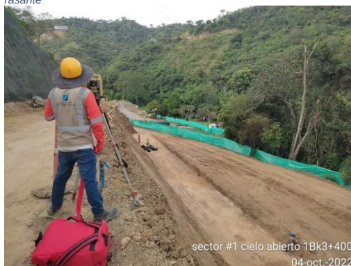
Foto No 10: Cielo abierto 1B k 3+400 levantamiento excavación para muro en suelo mecánicamente estabilizado en acompañamiento con el contratista
