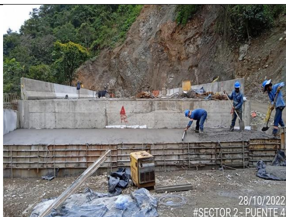
Fotografía 4. Hormigonado de losa de aproximación de estribo 1, en concreto de 28 Mpa.
