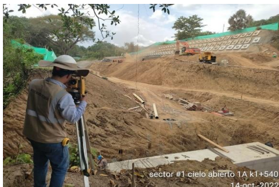
Foto No 28: Cielo abierto 1A k1+540 levantamiento obra hidráulica #2
