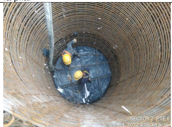
Fotografía 8. Hormigonado de pilotes 7 a 10 en la base de la pila 2.
