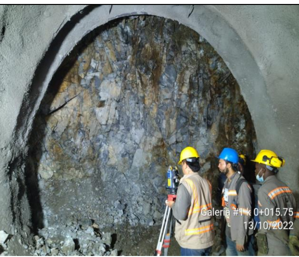
Foto No 12: Galería 1 chequeo de excavación y liberación de arco #3 k 0+015.75
