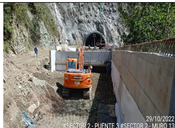
Fotografía 2. Avance de construcción de relleno estructural para la losa de aproximación del estribo No. 2.
