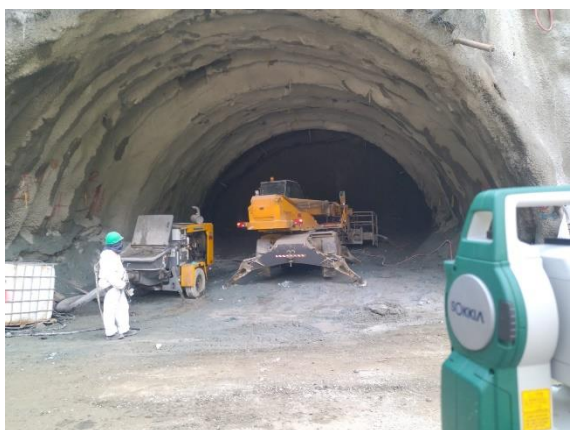
Foto No 11: Túnel 6 PORTAL Salida. Se realiza chequeo de excavación tipo IV, KM 12+087.40
