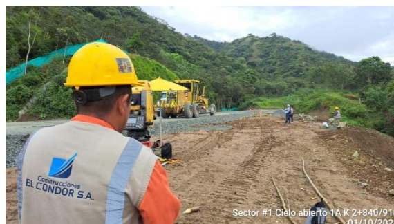
Foto No 2: Cielo abierto 1A k 2+840-910 conformación de corona sub rasante, acompañamiento a las actividades realizadas por el contratista
