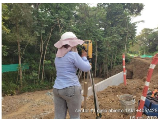
Foto No 19: Cielo abierto 1A k 1+403-427 levantamiento muro y levantamiento inicial del corte
