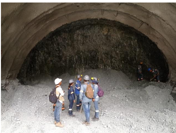
Foto No 3: Chequeo de excavación para arco 4 KM 12+091.55 Terreno tipo IV.
