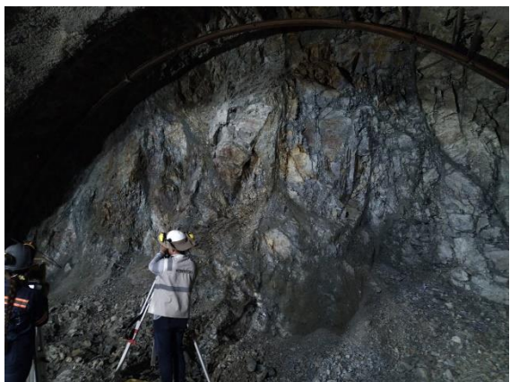
Foto No 15: Túnel 7 PORTAL Salida. Se chequea radios de arco 0 y 2 terreno tipo IV en las KM 13+896.15 y KM 13+897.65.
