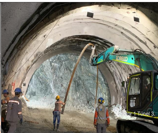
Foto No 14: chequeo de instalación de arco #3. km 10+040.30
