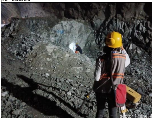
Foto No 15: chequeo para instalación de pernos en el banco derecho del km10+703 (1), km 10+707 (1) km 10+711(1) y km 10+715 (1).
