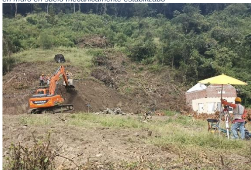
10/21/2022 Sector 1, Perfilación de talud cielo abierto #4, Abscisa k8+290 21/10/2022
