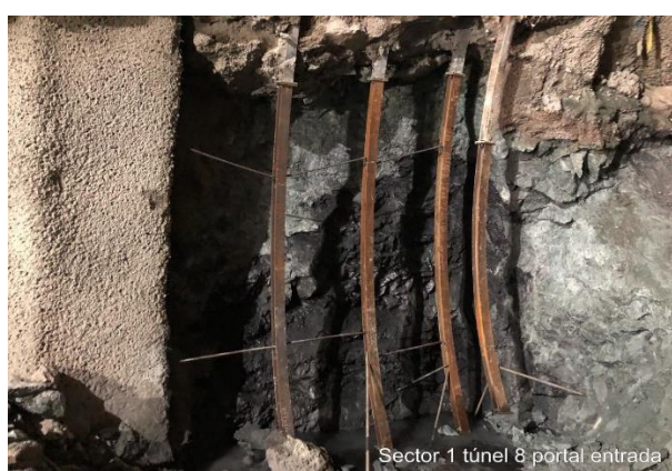
Foto No 4: Túnel 8 PORTAL ENTRADA. Chequeo e instalación de hastial izquierdo # 4 # 5 #6 y #0 ABS 15+067,20
