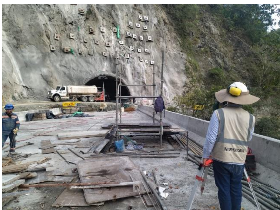
Foto No 9: Túnel 6 PORTAL SALIDA. Chequeo de puntos de asentamiento, ABS 12+099 – Talud portal salida
