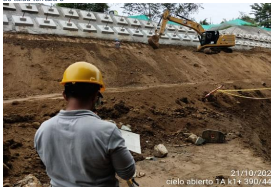
Foto No 36: Cielo abierto 1A k 1+390-440 control de excavación y perfilación de talud banco #2
