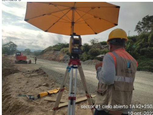
Foto No 22: Cielo abierto 1A k2+240-280 instalación de tacos para sub base en acompañamiento a las actividades realizadas por el contratista
