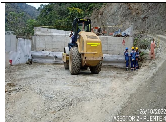
Fotografía 3. Ejecución de relleno con material de excavación para la construcción de la losa de aproximación estribo 1.
