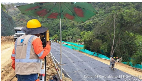
Foto No 37: Cielo abierto 1B k 3+400-480 marcación de alineamiento y niveles en muro en suelo mecánicamente estabilizado
