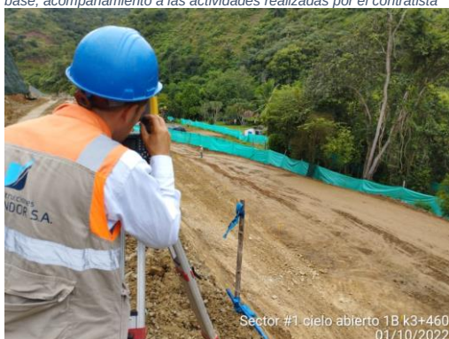
Foto No 3: Cielo abierto 1B k 3+460 Replanteo en muro en suelo mecánicamente estabilizado, acompañamiento a las actividades realizadas por el contratista
