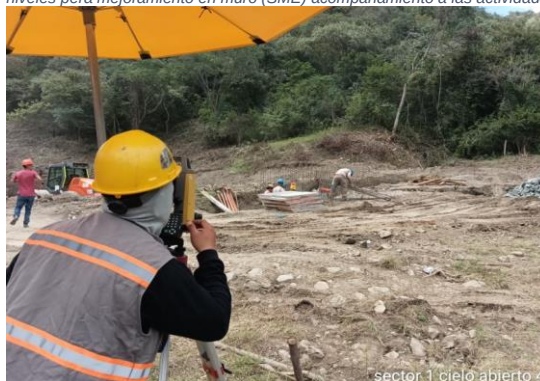
Foto No 40: Cielo abierto 4 k 8+294 replanteo localización box coulver 2x2
