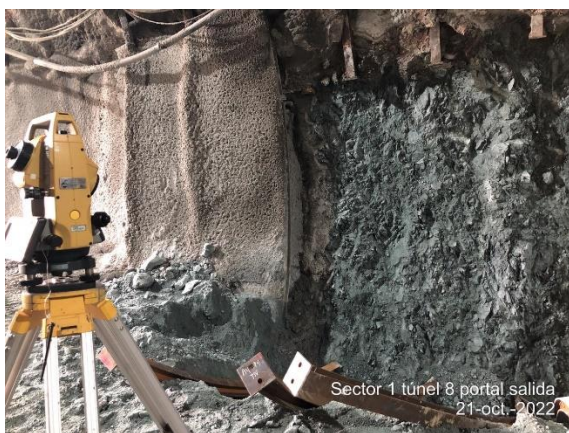
Foto No 13: Túnel 8 PORTAL SALIDA Chequeo de excavación para patas bancó derecho, terreno tipo IV.
