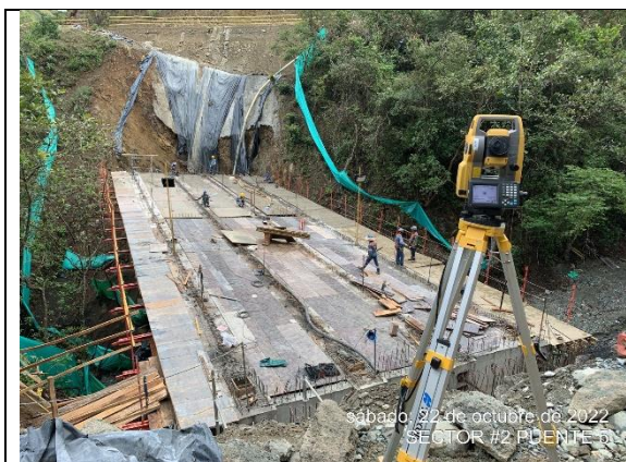
Fotografía 5. Instalación de obra falsa y fromaleta para construcción de tablero
