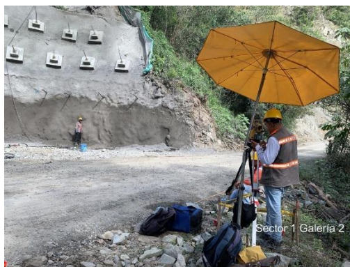
Foto No 48: galería #2 k10+715 chequeo de excavación para corte
