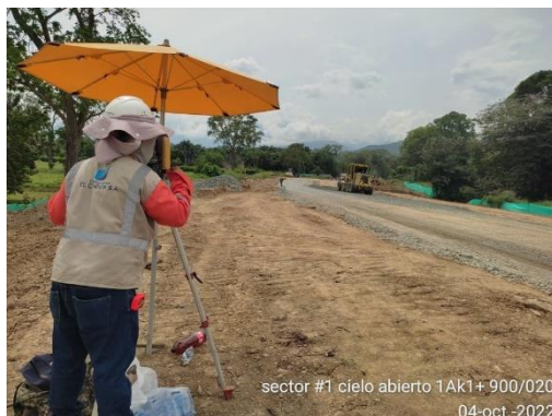
Foto No 8: Cielo abierto 1A k 1+900-020 instalación de tacos para niveles sub rasante
