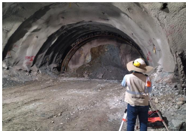
Foto No 16: Túnel 7 PORTAL Salida. Se instaló arco en la KM 13+894.60 arco 3 tipo IV y se realizó el levantamiento de la excavación.
