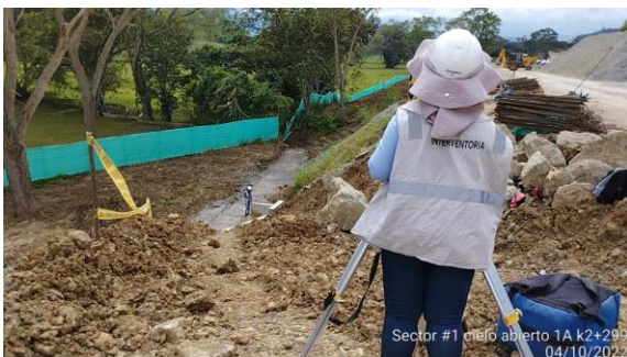
Foto No 7: Cielo abierto 1 A k 2+299 levantamiento obra hidráulica # 7
