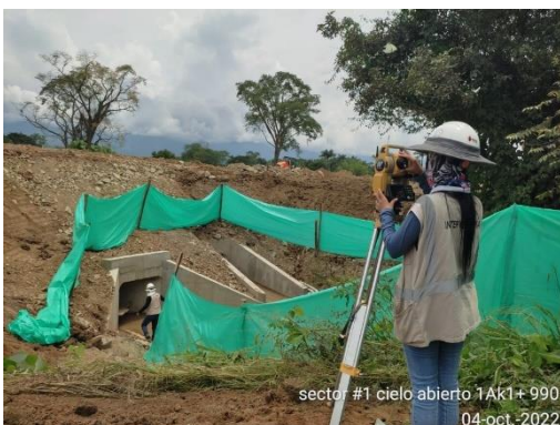
Foto No 9: Cielo abierto 1A k 1+990 levantamiento obras hidráulicas 5 y 6
