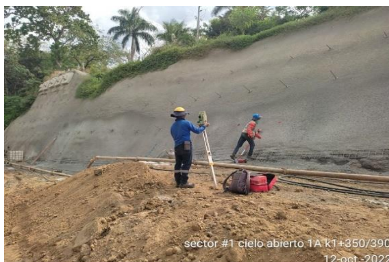
Foto No 26: Cielo abierto 1A k1+350-390 marcación de pernos terraza 1 fila #3
