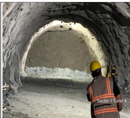
Foto No 9: Túnel 4. Acompañamiento en Marcación de frente y Marcación de pernos sistemáticos KM: 10+841.30
