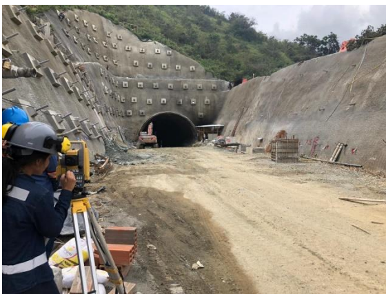
Foto No 1: Túnel 8 PORTAL SALIDA. Acompañamiento que en chequeo de puntos de control ABS frente KM 15+246
