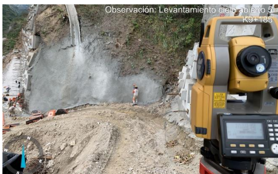
Foto No 43: Cielo abierto 5 k9+240 chequeo de marcación para corte de talud segunda terraza
