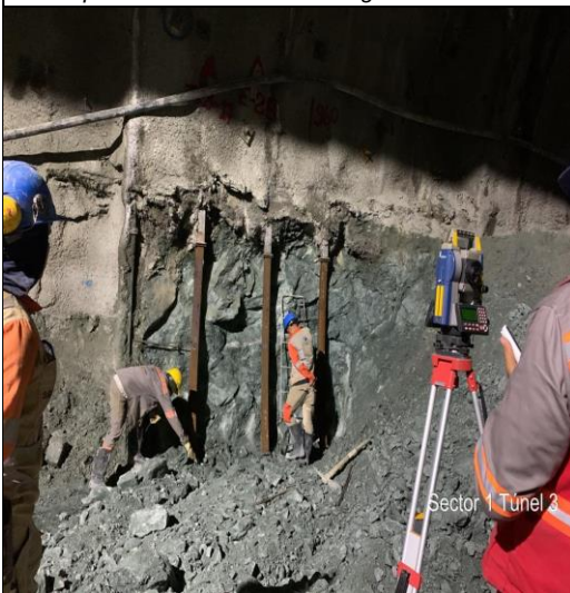
Foto No 3: Instalación de piezas inferiores (patas) de arco metálico HEB 100 Túnel 3, km 9+958 – km 9+960.20
