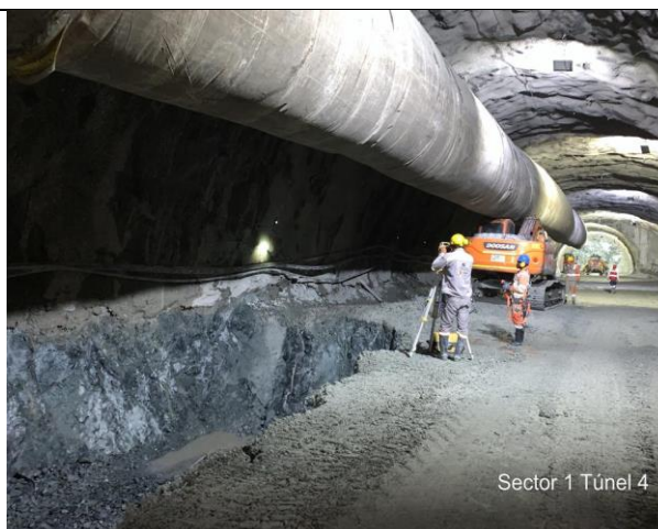
Foto No 6: Túnel 4. Chequeo de Perfilación de excavación de banca izquierda km 10+720/ 730
