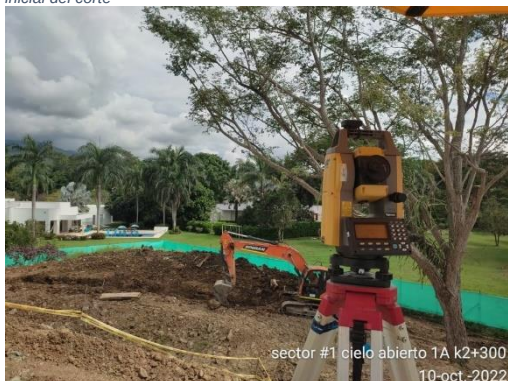
Foto No 21: Cielo abierto 1A k 2+300 cheque excavación mecánica para construcción de canal
