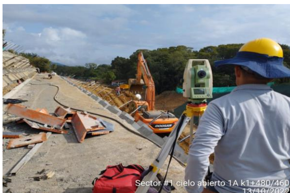
Foto No 27: Cielo abierto 1A k1+460-480 control de excavación y perfilación de talud
