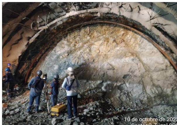
Foto No 2: Túnel 8 PORTAL SALIDA. Liberación de arco # 2 terreno tipo IV KM 15+175.70
