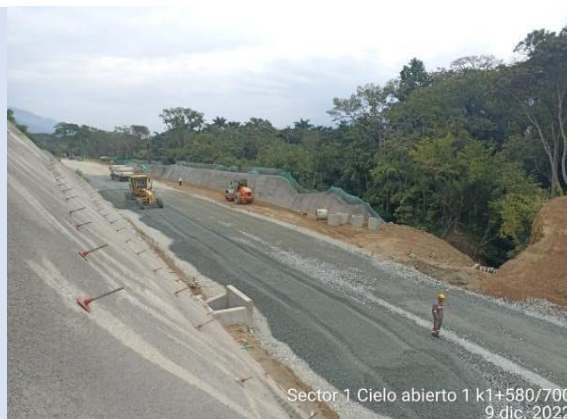
Foto 3-10 K1+580-700 instalación de subbase granular
