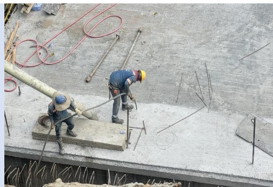
Foto 4-29 Inyección con lechada a acero de presfuerzo de familias 1,2,3 y 4 en vigas A,B,C y D.
