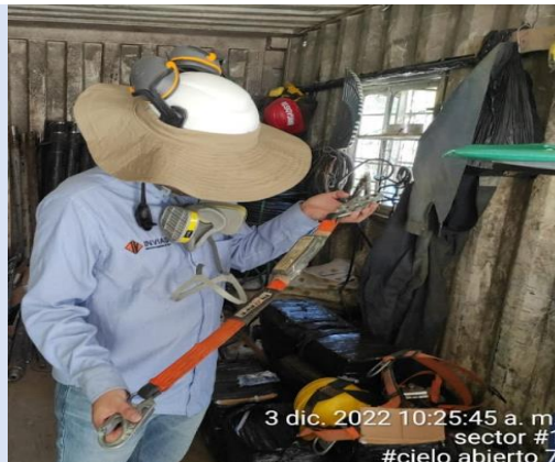
Foto 3-28 Tunel 3, Cielo abierto 7, Verificación de eslingas, arnes, etc.
