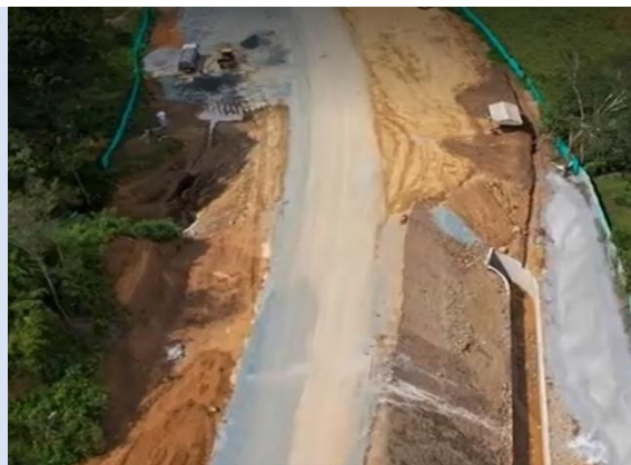
Foto 3-4 K2+300 al K2+600, estado actual
