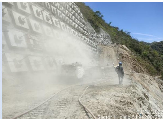
Foto 3-15 K9+200-K9+250 perforaciones para anclajes activos
