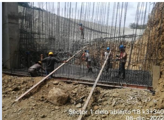
Sector 1 cielo abierto 1B k3+340 08-dic.-2022 Foto 3-11 K3+340 Armado refuerzos para las aletas de Box Culvert
