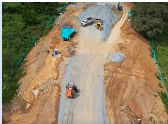
Foto 3-6 K3+050 – K3+330, estado actual
