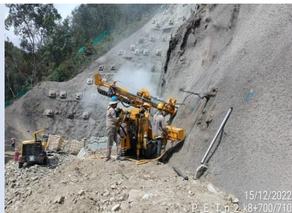
Foto 3-13 K8+700-710 Perforaciones para anclajes activos
