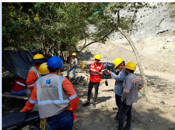
Foto 3-30 Tunel 4, Capacitacion personal
