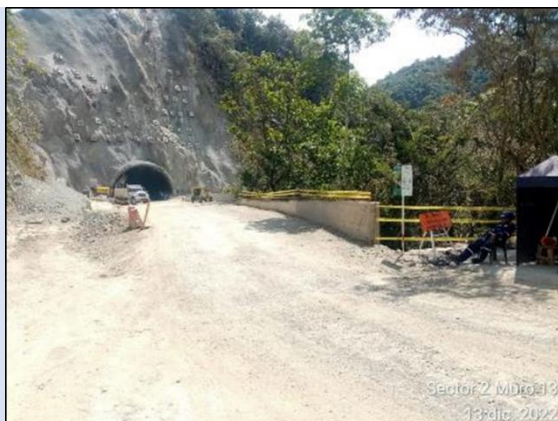
Foto 4-9 Cielo abierto 12, muro 13
