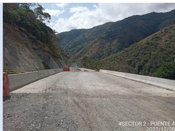
Foto 4-27 Habilitación a tránsito vehicular sobre el puente 4.
