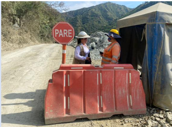
Foto 3-23 Cielo abierto 5, Inspección Auxiliar de tránsito
