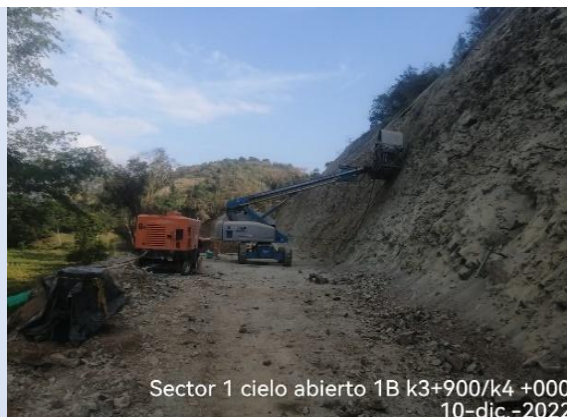
Sector 1 cielo abierto 1B k3+900/k4 +000 10-dic.-2022 Foto 3-12 K3+900-k4+00 Perforaciones para pernos pasivos
