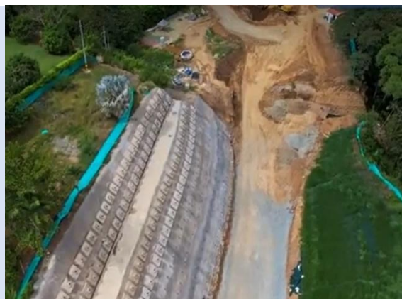
Foto 3-2 K1+600 al K1+800, estado actual
