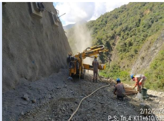
Foto 3-21 K11+610-k11+630 perforaciones para anclaje activos.
