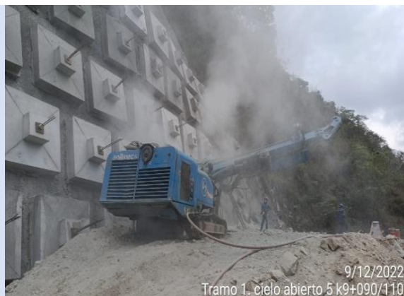
Foto 3-16 K9+090-K9+110 perforaciones para anclajes activos.
