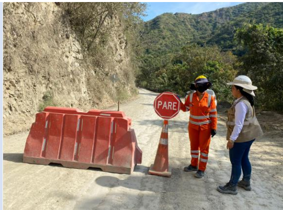
Foto 3-24 Túnel 4, Verificación dispositivos de tránsito
