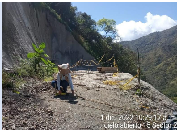
Foto 4-37 Cielo abierto 15, Verificación de equipos de protección contra caídas
