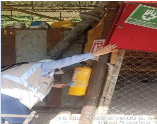
Foto 3-36 Sector 1 K 2 + 700, verificación de elementos del plan de emergencia.
