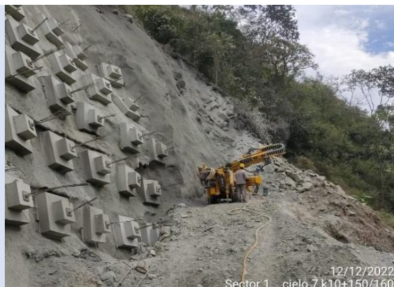
Foto 3-20 K10+150-k10+160 perforaciones para anclaje activos.
