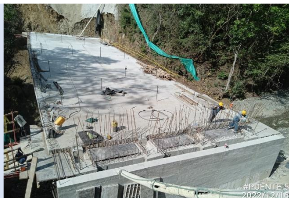
Foto 4-30 Amarre de acero de refuerzo de sección final del tablero. Curado al hormigón del muro espaldar del estribo 1.
