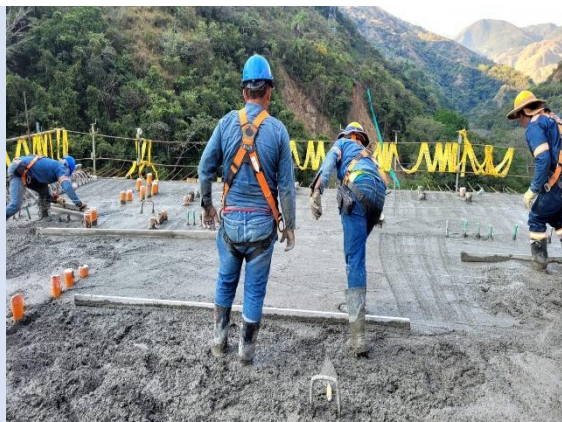
Foto 4-32 Hormigonado de sección 3 de muros y losa superior de dovela 0 y 1 de los voladizos 1 y 2 de la pila 1.
