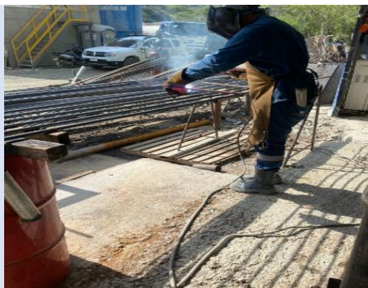
Foto 3-26 Tunel 3, Verificación del estado de los EPPs
