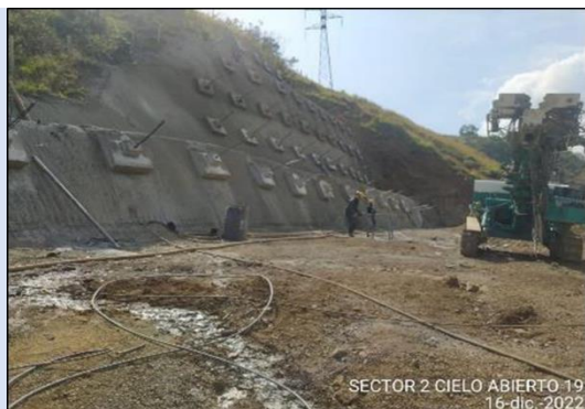
Foto 4-23 Cielo abierto 19, excavaciones en material común y roca
