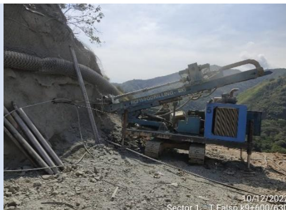
Foto 3-18 K9+600-k9+630 perforaciones para anclajes para malla sistema Tecco.
