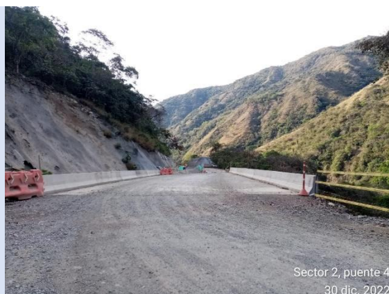
Foto 4-28 Habilitación a tránsito vehicular sobre el puente 4.
