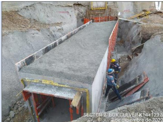
Foto 4-17 Cielo abierto 15, construcción de obra hidráulica No. 42 – Box culvert
