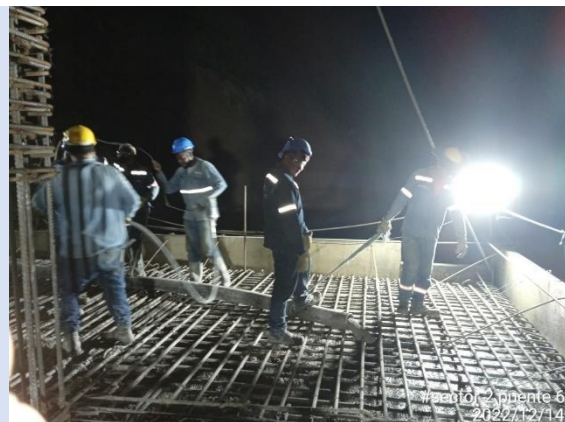
Foto 4-31 Hormigonado de segunda etapa de dado de cimentación pila 2.
