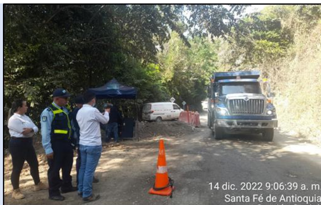
Foto 4-41 Vía industrial, control de velocidad vehículos de obra, en compañía tránsito de SFA.
