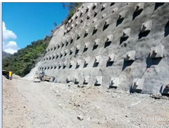
Foto 4-12 Túnel falso 2, excavaciones y tensionamientos.
