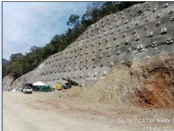
Foto 4-14 Cielo abierto 13, actividades de sostenimiento
