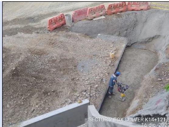
Foto 4-18 Cielo abierto 15, construcción de obra hidráulica No. 42 – Box culvert
