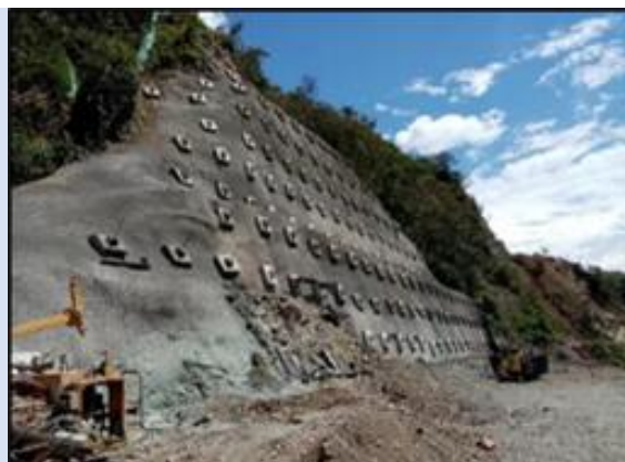
Foto 4-2 K12+356 -K13+664, estado actual
