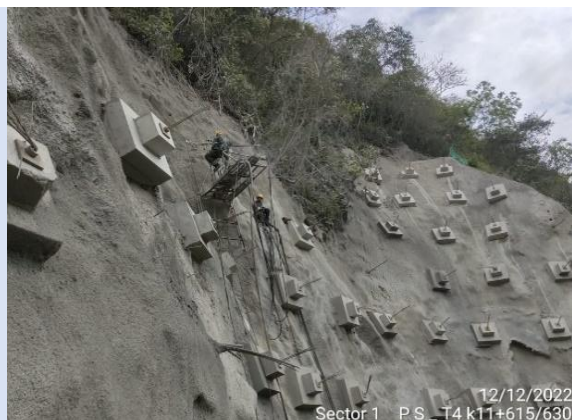
Foto 3-22 K11+615-k11+630 perforaciones para anclaje activos.
