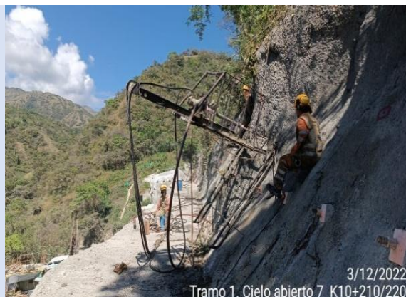
Foto 3-19 K10+210-k10+220 perforaciones para pernos autoperforantes.
