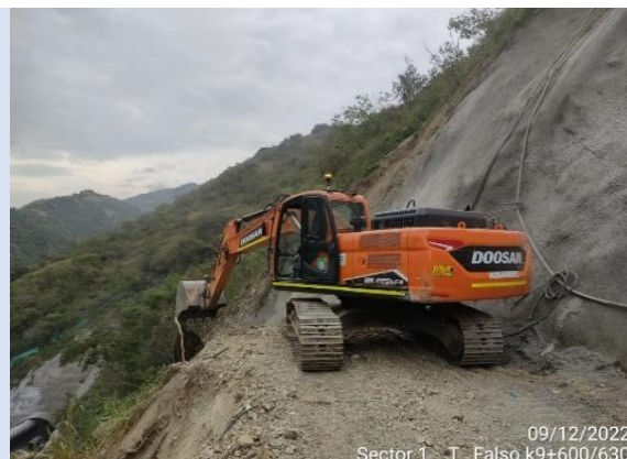
Foto 3-17 K9+600-k9+630 excavación de talud
