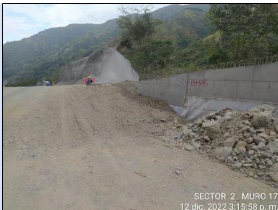
Foto 4-15 Cielo abierto 13, muro 17, compactación de material de relleno.
