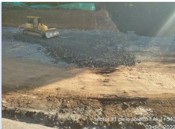
Foto 3-9 K1+540-600 Mejoramiento de subrasante
