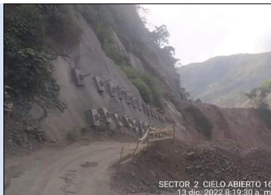
Foto 4-20 Cielo abierto 16, actividades de sostenimiento.
