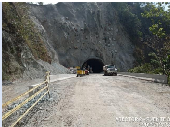
Foto 4-25 Habilitación a tránsito vehicular sobre el puente 3.
