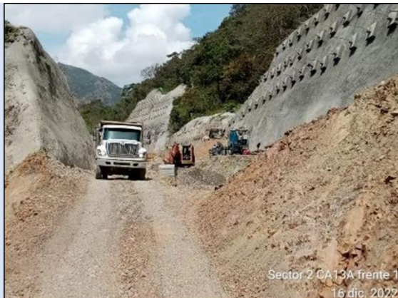
Foto 4-13 Cielo abierto 13, excavaciones en material común y en roca
