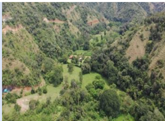
Foto 3-5 K3+050 – K3+330, estado inicial
