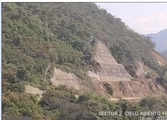
Foto 4-19 Cielo abierto 16, excavaciones en material común.
