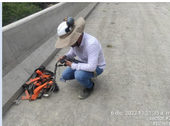
Foto 4-38 Tunel 3, Túnel 6, Verificación de eslingas, arnes, etc.
