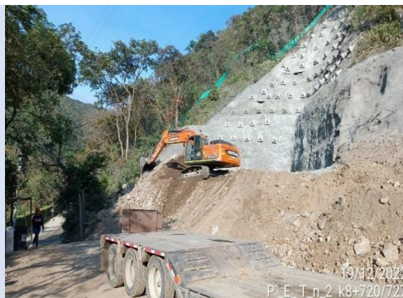
Foto 3-14 k8+700-710 Excavación para acceder al portal de Túnel 2
