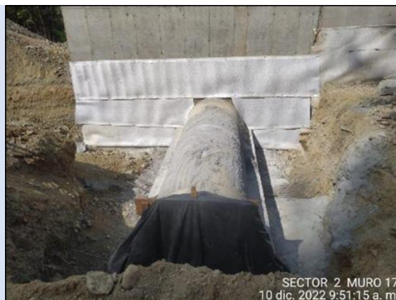
Foto 4-16 Cielo abierto 13, muro 17, vaciado de la zapata, y hormigonado de vástagos lleno estructural con material de sitio.
