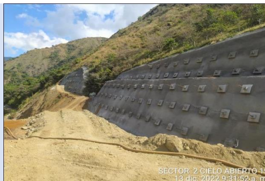
Foto 4-24 Cielo abierto 19, actividades de sostenimiento.
