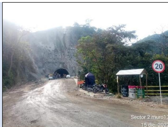
Foto 4-10 Cielo abierto 12, muro 13
