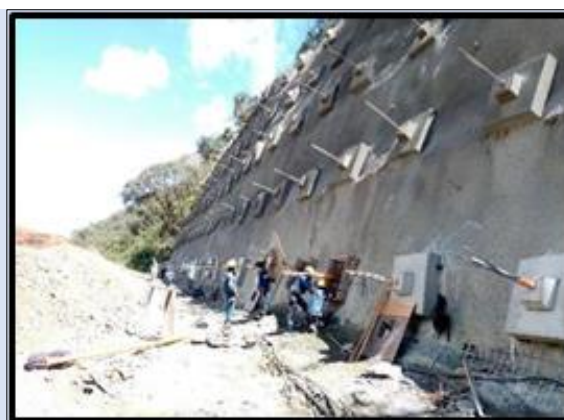
Foto 4-4 K12+356 -K13+664, estado actual
