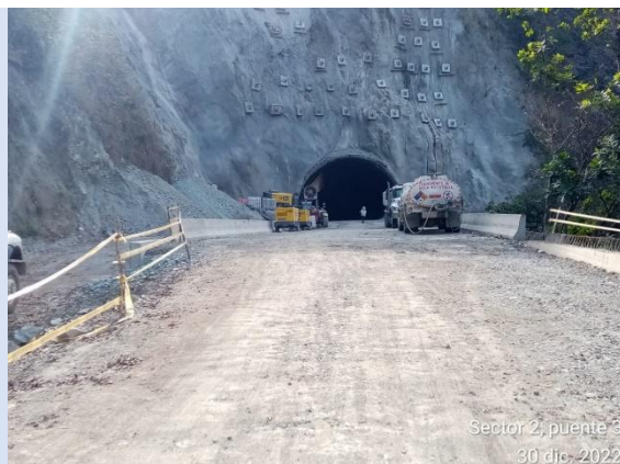
Foto 4-26 Habilitación a tránsito vehicular sobre el puente 3.
