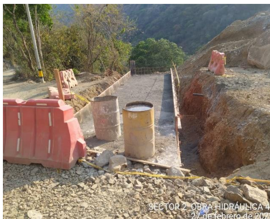
Foto 420 Obra hidráulica No. 41 – Box Colbert Armado de acero de refuerzo, y hormigonado del módulo 5 del Box
