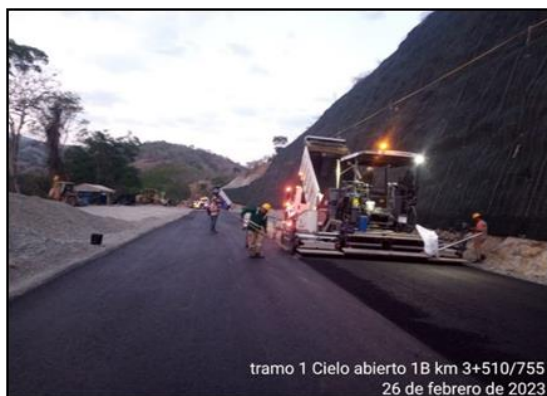
Foto 3-11 Cielo 1 B K3+300 – K3+800 Instalación de mezcla MSC-25
