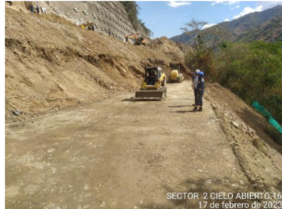
Foto 425 Terraplén del K14+554- K14+615, relleno de terraplén con material de sitio
