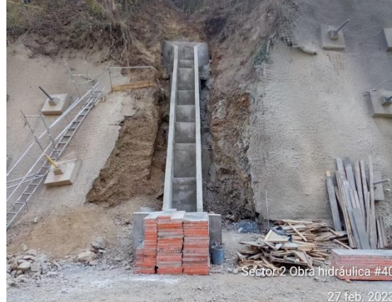
Foto 418 Obra hidráulica No 40 alcantarilla de 1200mm desencofrado de escalera dissipadora
