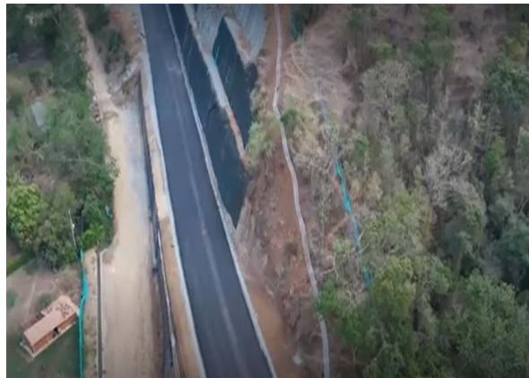
Foto 3-6 K3+050 – K3+330, estado actual
