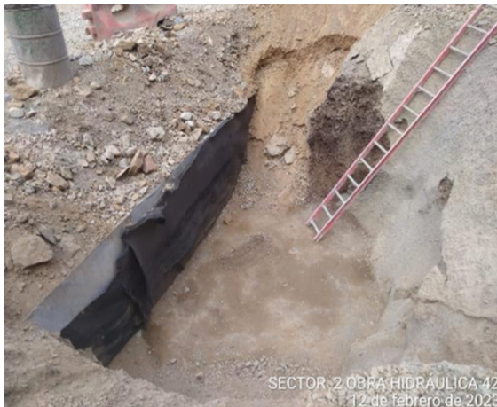
Foto 4-21 Obra hidráulica No. 42 – Box Colbert Relleno estructural con material de sitio, e instalación de geo dren planar
