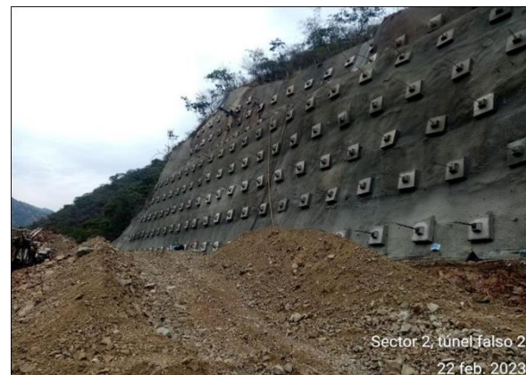
Foto 4-12 Túnel falso 2, excavaciones y tensionamientos.
