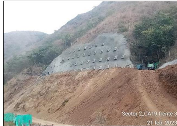
Foto 4-29 Cielo abierto 19, actividades de sostenimiento frente 3
