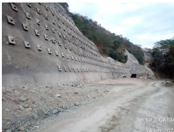
Foto 4-14 Cielo abierto 13, actividades de sostenimiento
