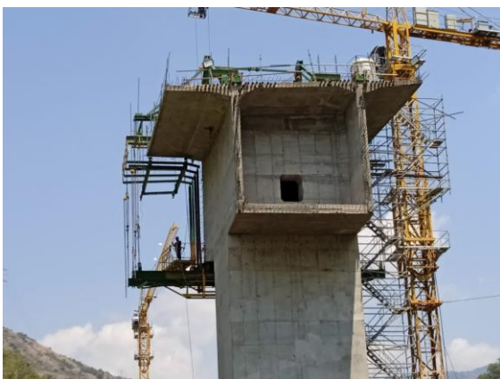
Foto 4-34 Montaje de carro de avance en pila 1.
