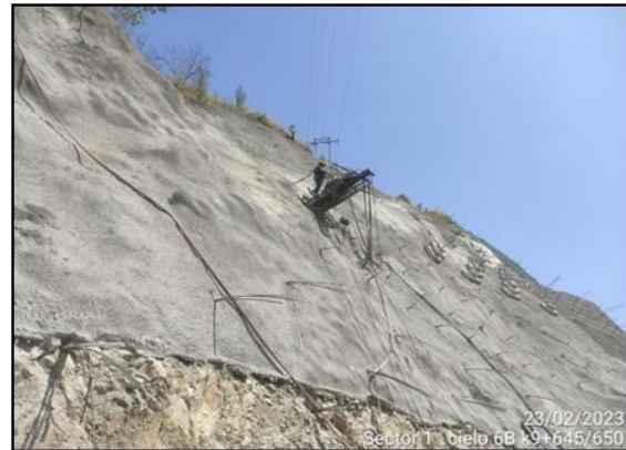
Foto 3-18 Cielo abierto 6 - K9+640-660 Perforaciones para anclajes activos.
