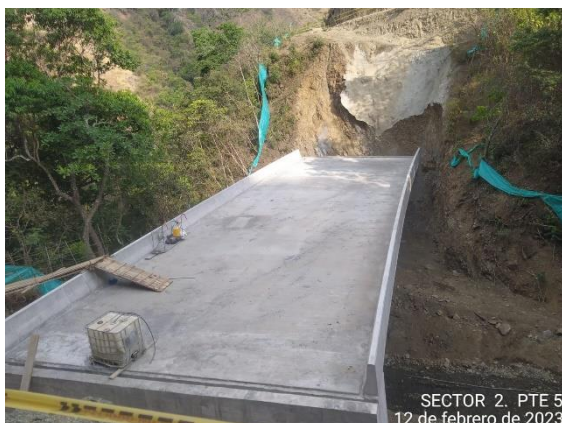
Foto 4-32 Aspecto del puente terminado, lado estribo 1.
