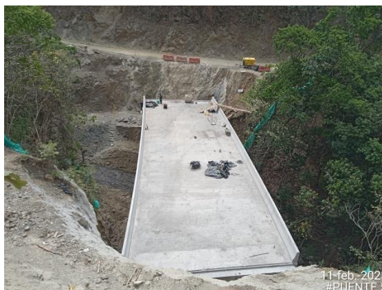
Foto 4-33 Aspecto del puente terminado, lado estribo 2
