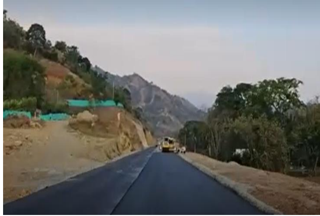
Foto 3-4 K2+300 al K2+600, estado actual
