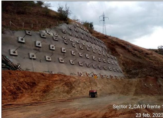
Foto 4-28 Cielo abierto 19, Actividades de sostenimiento frente 1
