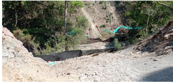
Foto 431 Accesos parciales a estribo 2 y pila 2.
