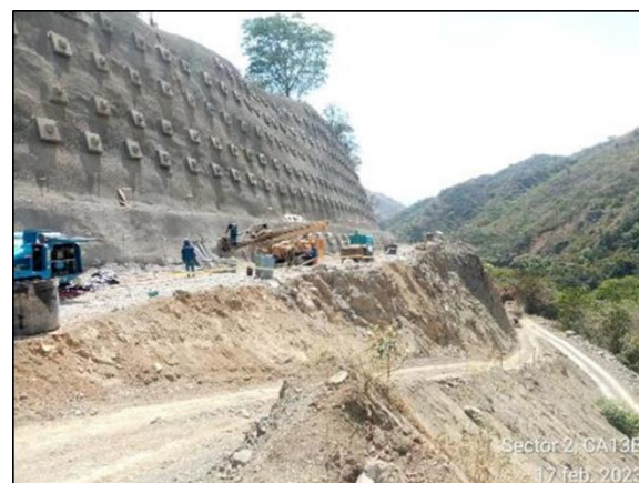
Foto 4-4 K12+356 -K13+664, estado actual
