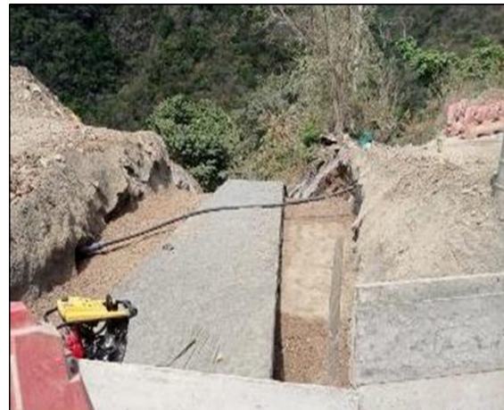
Foto 4-22 Obra hidráulica No. 42 – Box Colbert Relleno estructural con material de sitio, e instalación de geo dren planar
