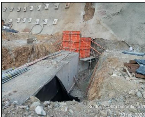
Foto 419 Obra hidráulica No. 41 – Box Colbert Excavaciones varias sin clasificar y hormigonado del módulo 1 y caja de encofe
