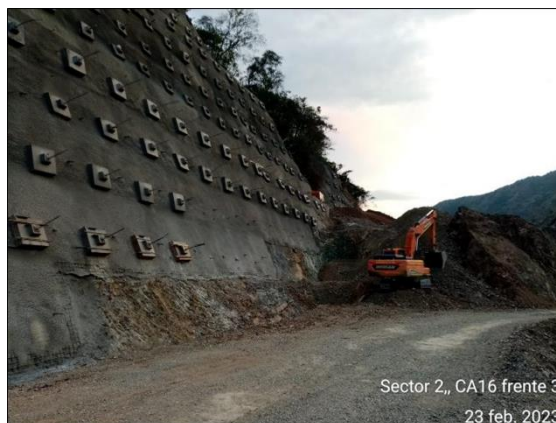
Foto 4-24 Cielo abierto 16, excavaciones en material común
