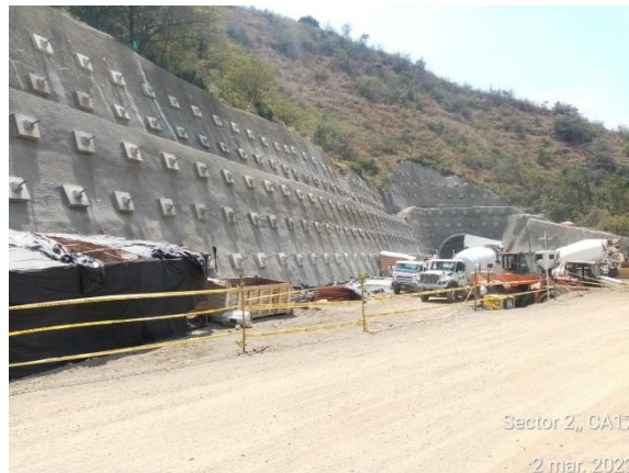
Foto 4-6 K15+246 – K15+506, estado actual
