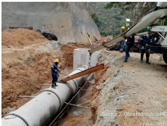
Foto 4-26 Obra hidráulica No 47 alcantarilla de 1200mm atraque de tubería con concreto de 14MPA
