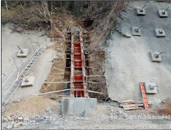
Foto 417 Obra hidráulica No 40 alcantarilla de 1200mm encofrado y hormigonado del dissipador
