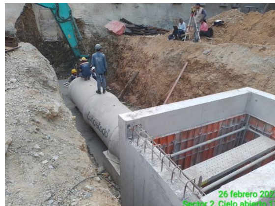
Foto 4-27 Obra hidráulica No 47 alcantarilla de 1200mm instalación de tubería de concreto de diámetro 1200mm
