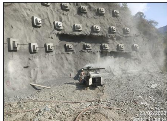
Foto 3-22 Portal S T No 4- K11+610-630 perforaciones para anclajes activos.
