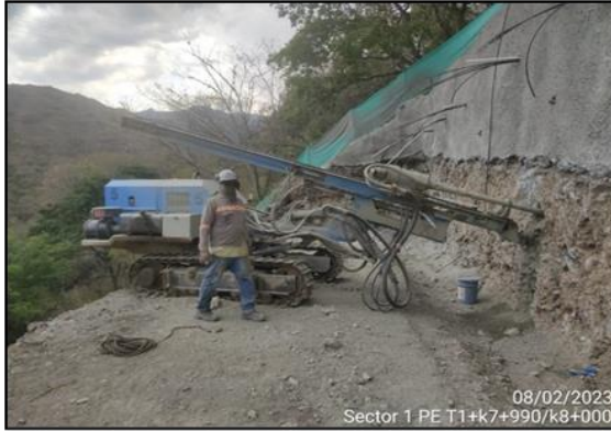
Foto 3-13 Portal entrada túnel No 1 K7+990-K8+00 perforaciones para anclajes activos.
