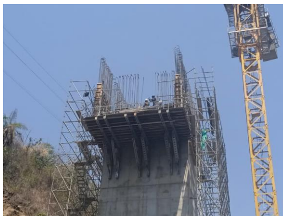
Foto 4-35 Avance de construcción de dovelas en pila 2.
