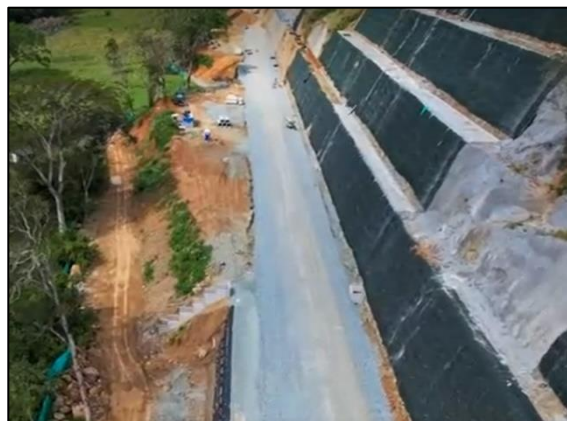
Foto 3-8 K3+330 – K3+900, estado actual
