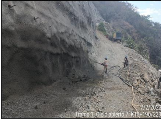
Foto 3-19 Cielo 7 – K10+190-220 instalación de concreto lanzado.
