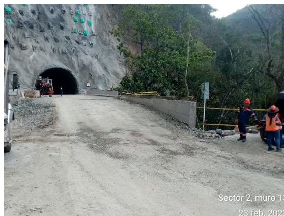
Foto 4-10 Cielo abierto 12, el corte de CA12 esta a nivel de rasante
