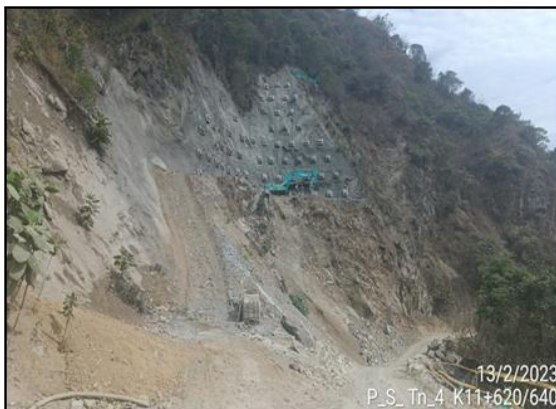
Foto 3-21 Portal S T No 4- K11+620-640 corte de talud.
