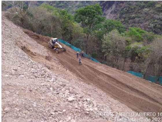
Foto 4 del K14+554- K14+615, relleno de terraplén con material de sitio.
