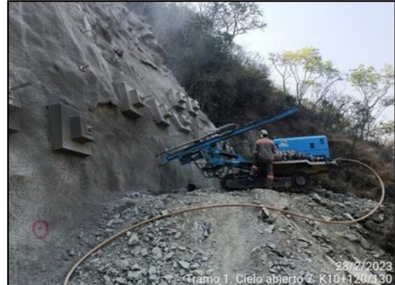
Foto 3-20 Cielo 7 – K10+120-130 Perforaciones para anclajes activos.
