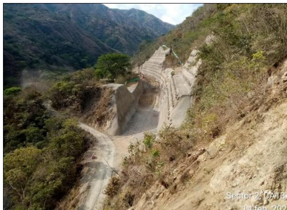
Foto 4-2 K12+356 -K13+664, estado actual
