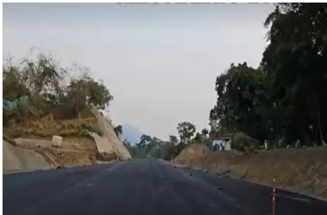
Foto 3-2 K1+600 al K1+800, estado actual
