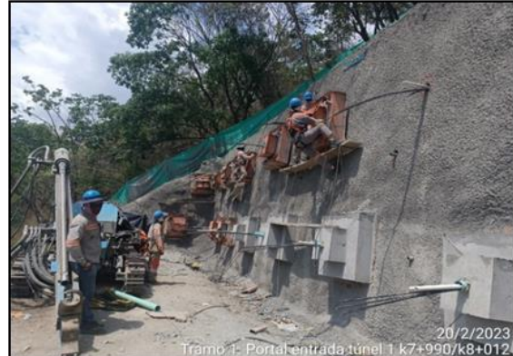
Foto 3-14 Portal entrada túnel No 1 K7+990-K8+00 armado de aceros y encofrados para dados de los anclajes activos.
