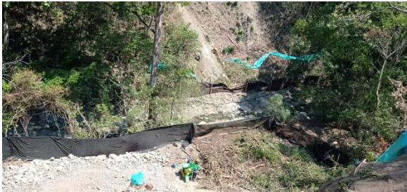
Foto 430 Accesos parciales a estribo 2 y pila 2.
