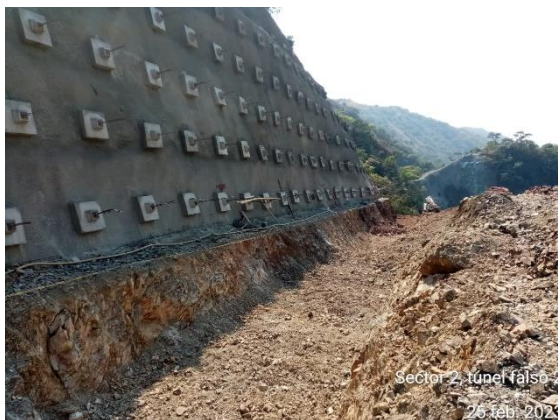
Foto 4-11 Túnel falso 2, actividades de sostenimiento
