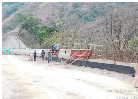
Foto 4-16 Muro 17, armado de acero de refuerzo para new jersey
