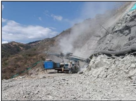
Foto 3-17 Cielo abierto 6 - - K9+600-630 Perforaciones para anclajes activos.
