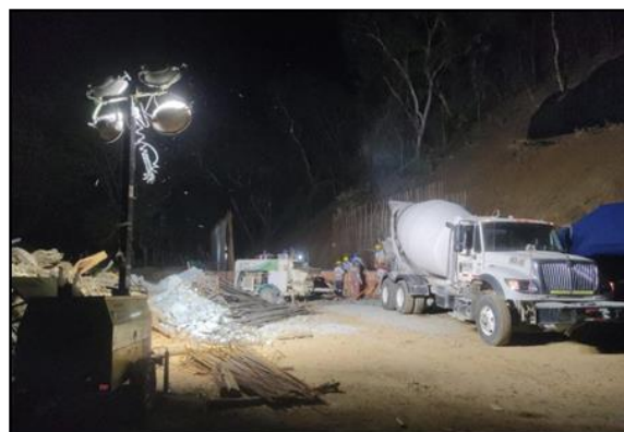
Foto 3-12 Cielo 1 B K4+110 Construcción de Box Coulvert vehicular.
