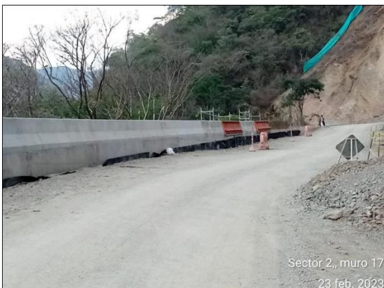
Foto 4-15 Muro 17, hormigonado de new jersey con concreto de 28 MPA
