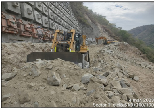
Foto 3-15 Cielo abierto 5 - K9+100-190 corte y perfilado del talud.
