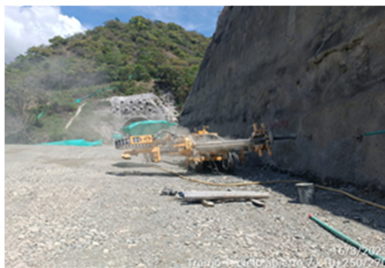
Foto 3-20 Cielo 7 – K10+190-290 Perforaciones para instalación de drenes profundos.
