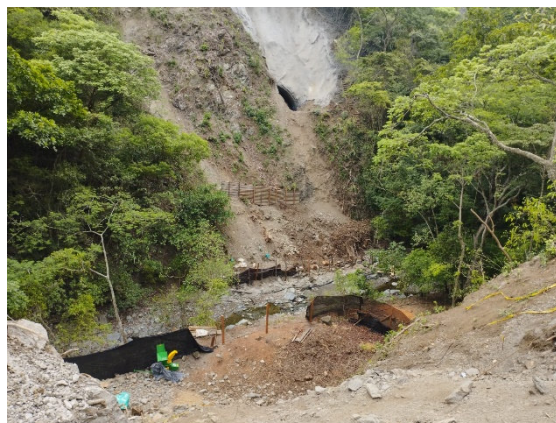
Foto 439 Obras de protección del cauce, pila 2 y estribo 2.
