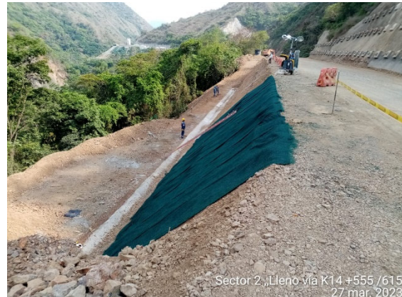
Foto 433 Terraplén del K14+554- K14+615, instalación de geomalla de fachada tipo TRM 500 para muro de tierra estabilizada mecánicamente
