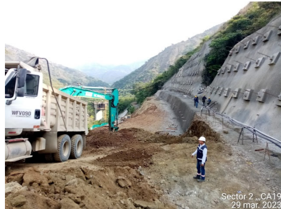
Foto 4-37 Cielo abierto 19, actividades de sostenimiento frente 3
