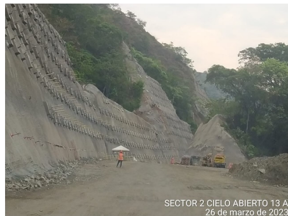
Foto 4-18 Cielo abierto 13, se termina actividades de sostenimiento en el talud corte a nivel de rasante de vía.
