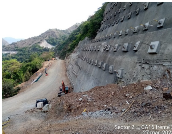
Foto 4-32 Cielo abierto 16, excavaciones en material común
