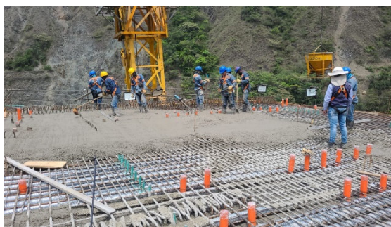
Foto 443 Armado de acero, ductos y hormigonado de losa superior de dovelas sobre pila 2.
