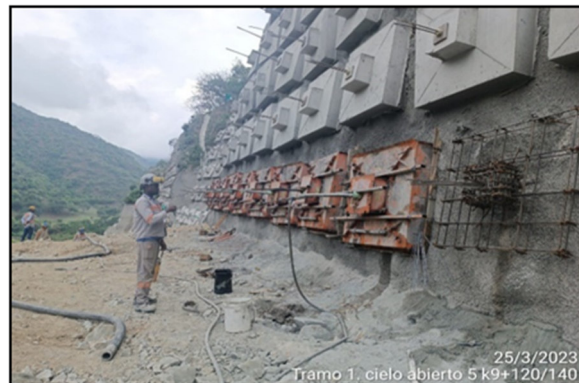
Foto 3-16 Cielo abierto 5 K9+120-K9+140 armado de aceros y encofrados para dados de los anclajes.
