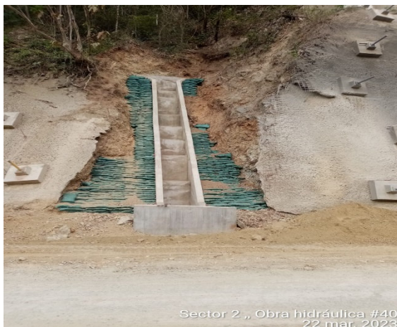
Foto 425 Obra hidráulica No 40 alcantarilla de 1200mm relleno de laterales del dissipador con sacos de suelo
