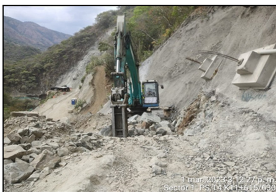
Foto 3□21 Portal S T No 4- K11+620-640 fragmentación de reoca con martillo hidráulico para cote del talud.
