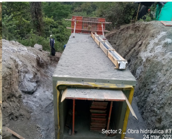
Foto 420 Obra hidráulica No 37 box Colbert de 2x2 desencofrado y curado del módulo 2
