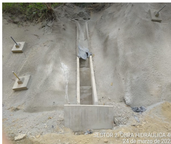
Foto 426 Obra hidráulica No 40 alcantarilla de 1200mm actividad de concreto lanzado para empalmar el cielo abierto con el dissipador
