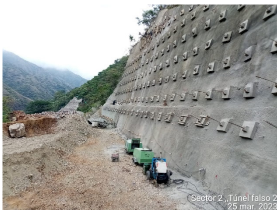
Foto 4-15 Túnel falso 2, actividades de sostenimiento
