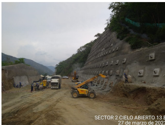
Foto 4-17 Cielo abierto 13, excavaciones en material común y en roca
