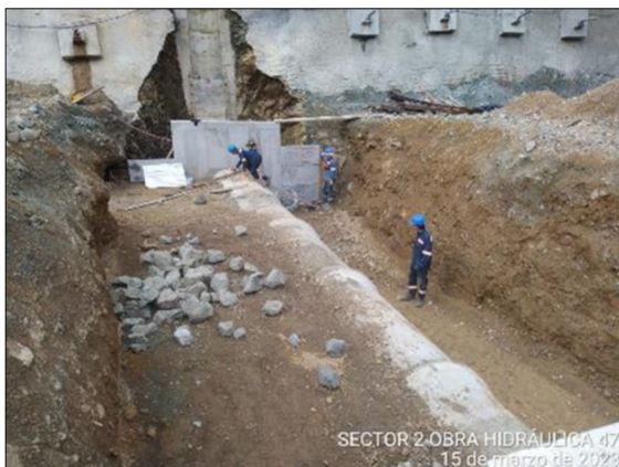
Foto 4-34 Obra hidráulica No 47 alcantarilla de 1200mm relleno para estructuras con material de sitio.
