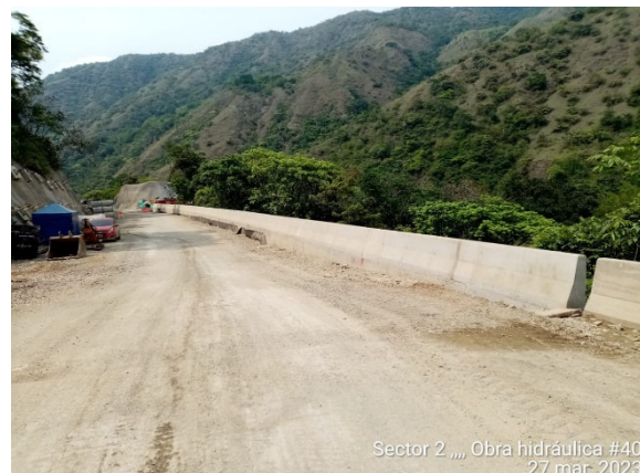
Foto 4-24 Muro 17, muro 17 terminado al 100% new jersey
