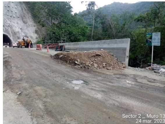
Foto 4-14 Cielo abierto 12, muro 13 hormigonado de los módulos 1,2,3
