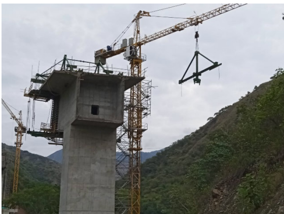
Foto 4-40 Montaje de carro de avance en pila 1.
