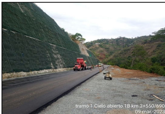
Foto 3-11 Cielo 1 B K3+550 – K3+690 Instalación de capa intermedia MSC-25
