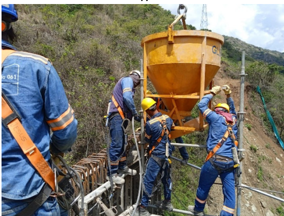
Foto 442 Hormigonado de muros de dovelas sobre pila 2.
