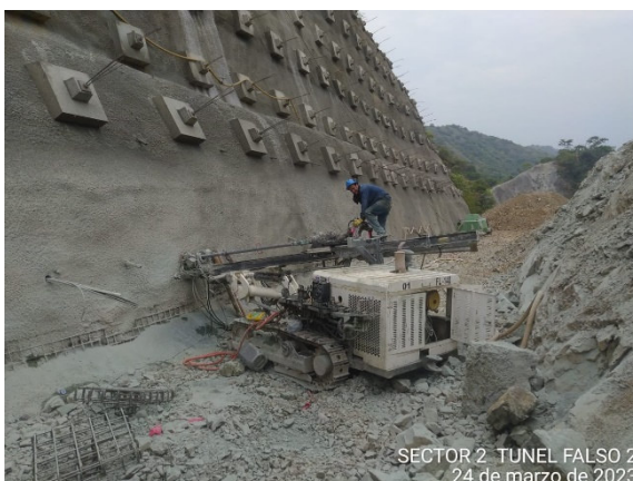
Foto 4-16 Túnel falso 2, perforaciones de anclajes y tensionamientos.
