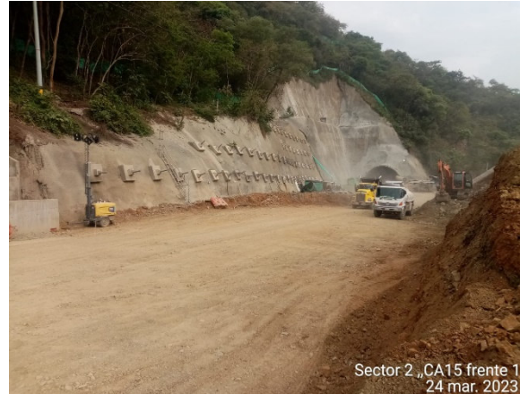
Foto 46 K 14+030 –K14+200, estado actual
