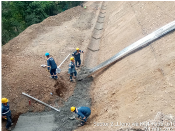
Foto 4 del K14+554- K14+615, relleno de terraplén con material de sitio, construcción de cuneta en v en la terraza del terraplén.
