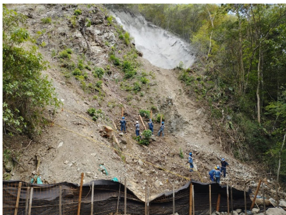
Foto 438 Obras de protección del cauce, estribo 1 y pila 1.
