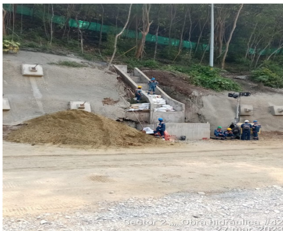
Foto 4-29 Obra hidráulica No. 42 – Box Colbert colocación en los laterales de la escalera disipadora unos saco suelos con material de sitio
