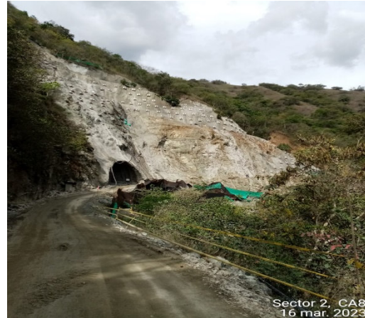
Foto 4-12 Cielo abierto 8, frente inactivó
