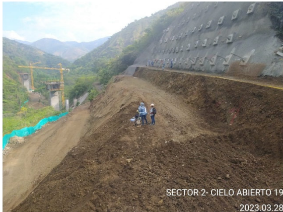
Foto 4-36 Cielo abierto 19, Actividades de sostenimiento frente 1
