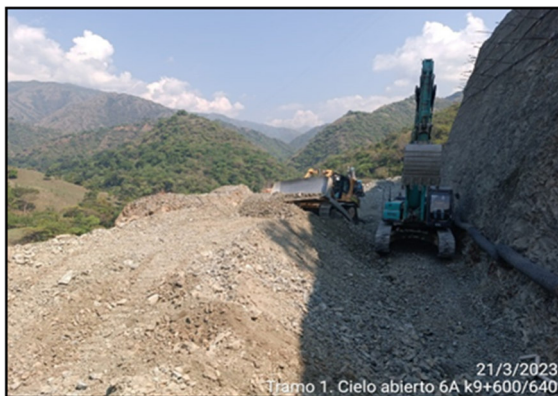
Foto 3-17 Cielo abierto 6A - K9+600-640 corte y perfilado del talud.
