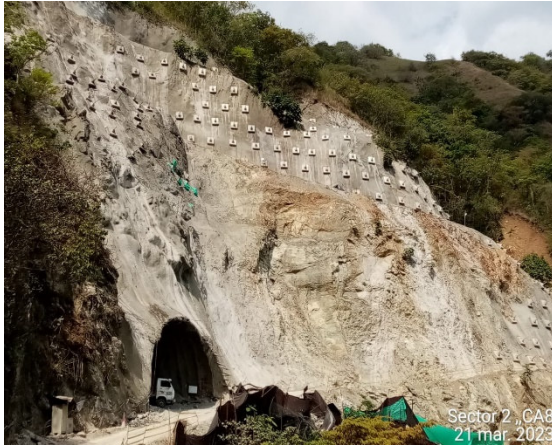
Foto 4-11 Cielo abierto 8, frente inactivó
