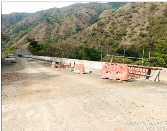
Foto 4-23 Muro 17, hormigonado de new jersey con concreto de 28 MPA
