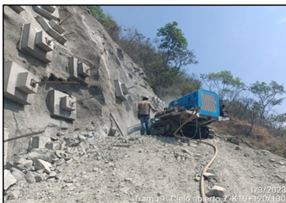
Foto 3-19 Cielo 7 – K10+120-130 perforaciones para anclajes activos.
