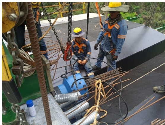
Foto 4-41 Tensionamiento de dovelas sobre pila 1.
