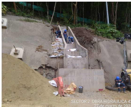
Foto 4-30 Obra hidráulica No. 42 – Box Colbert colocación en los laterales de la escalera disipadora unos saco suelos con material de sitio
