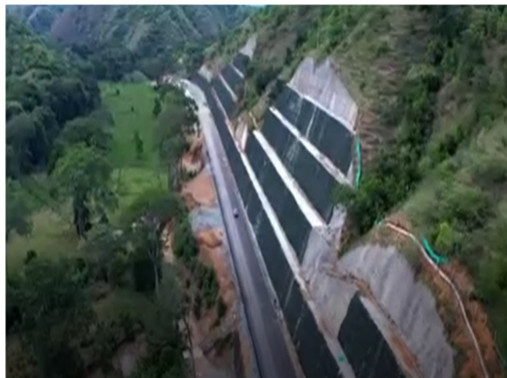
Foto 3-6 K3+330 – K3+900, estado actual
