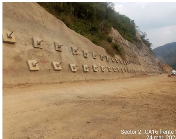
Foto 48 K 13+330 –K14+670, estado actual
