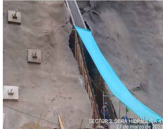
Foto 428 Obra hidráulica No. 41 – Box Colbert Armado de acero de refuerzo, y encofrado de los muros de la escalera disipadora.
