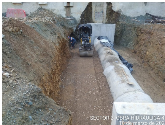
Foto 4-35 Obra hidráulica No 47 alcantarilla de 1200mm compactación del material de sitio y toma de densidades.
