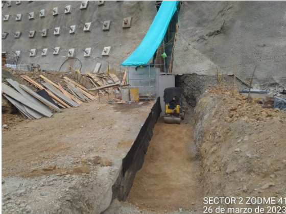
Foto 427 Obra hidráulica No. 41 – Box Colbert conformación de relleno estructural con material de sitio del módulo 2.
