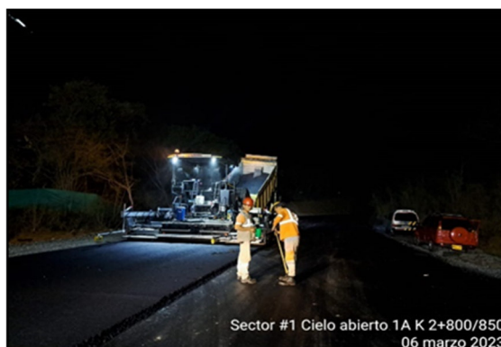
Foto 3□10 Cielo 1 A K2+800-850 Instalación de capa asfáltica intermedia MSC-25.
