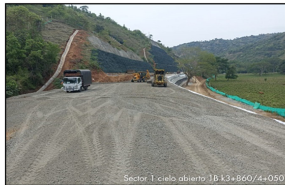
Foto 3-12 Cielo 1 B K4+110 Construcción de Muro MSE.
