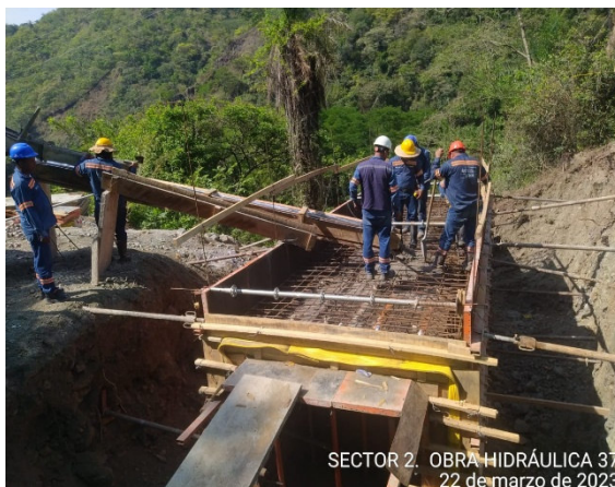
Foto 419 Obra hidráulica No 37 box Colbert de 2x2 amarre de acero de refuerzo y hormigonado con concreto de 28 MPA
