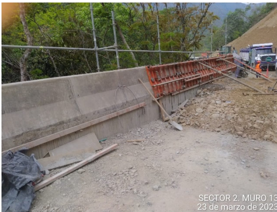
Foto 4-013 Cielo abierto 12, muro 13, encofrado módulos 1,2,3 de new jersey
