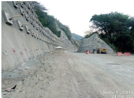
Foto 4-2 K12+356 -K13+664, estado actual
