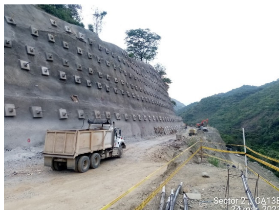
Foto 4-4 K12+356 -K13+664, estado actual
