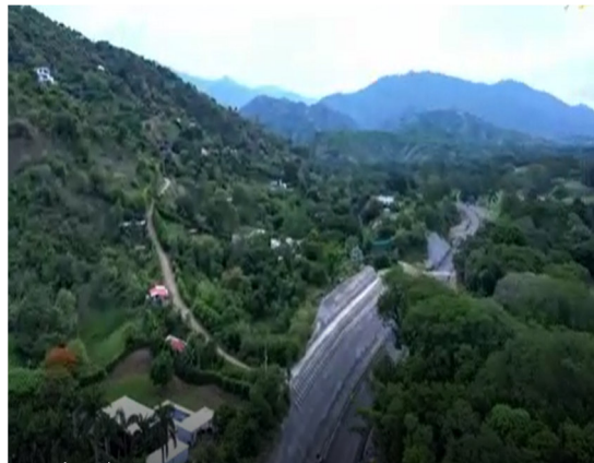
Foto 3-2 K1+600 al K1+800, estado actual
