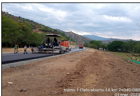
Foto 3□9 Cielo 1 A K2+040-080 Instalación de capa asfáltica intermedia MSC-25.
