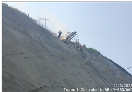
Foto 3-18 Cielo abierto 6B - K9+650-660 Perforaciones para anclajes activos.
