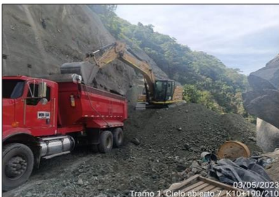
Foto 3-23 Cielo 7 – K10+120-150 corte y perfilado del talud.
