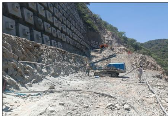
Foto 3-18 Cielo abierto 5 K9+120-130 perforaciones para anclajes activos.
