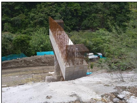
Foto 4-49 Avance de ejecución de viga cabezal estribo 1.
