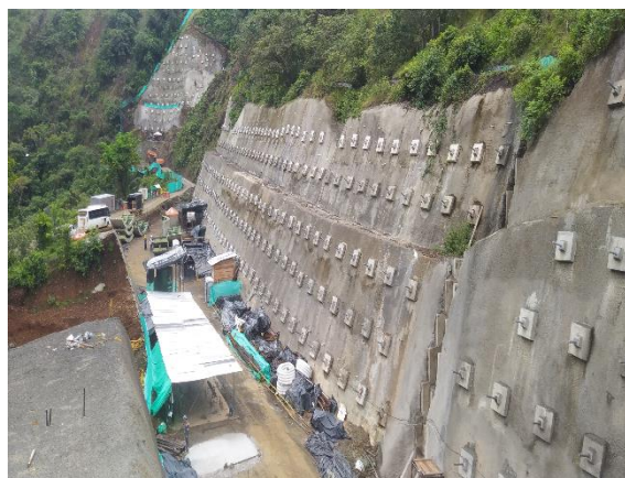
Foto 4-10 K15+246 – K15+506, estado actual
