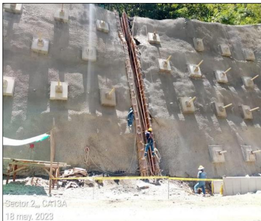
Foto 4-25 canal deflector encofrado de muros del canal
