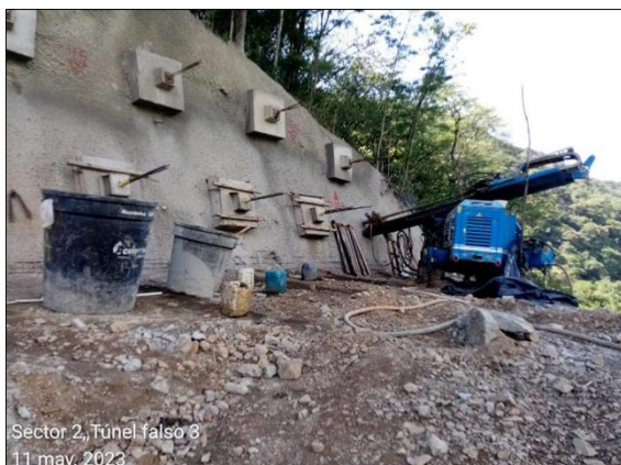
Foto 4-37 Túnel falso 3, actividades de Sostenimiento.
