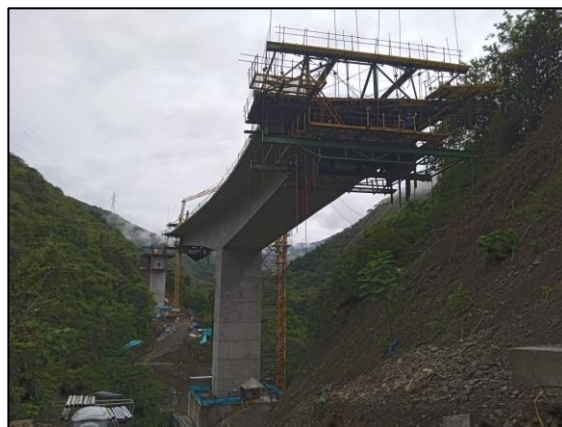
Foto 4-50 Avance de dovelas voladizas 1 y 2.
