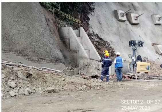
Foto 4-21 Obra hidráulica No 37 actividades de concreto lanzado en las zonas laterales del dissipador
