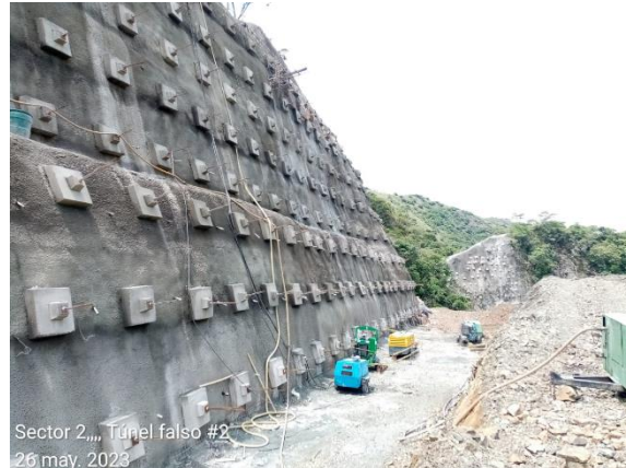
Foto 4-16 Túnel falso 2, perforaciones de anclajes con canasta y tensionamientos.
