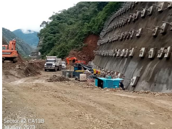
Foto 4-4 K12+356 -K13+664, estado actual
