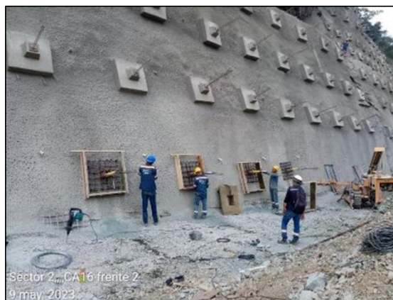
Foto 4-40 Cielo abierto 16, instalación de acero de refuerzo y encofrado para los dados de los anclajes
