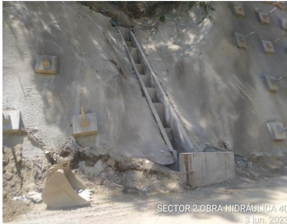
Foto 4-31 Obra hidráulica No 40 alcantarilla de 1200mm frente inactivo
