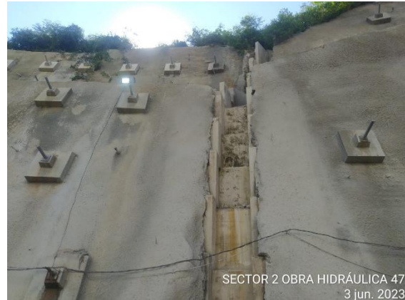
Foto 4-44 Obra hidráulica No 47 alcantarilla de 1200mm remates con concreto lanzado en el talud a lado y lado del dissipador
