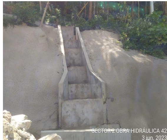
Foto 4-36 Obra hidráulica No. 42 – Box Colbert frente inactivo
