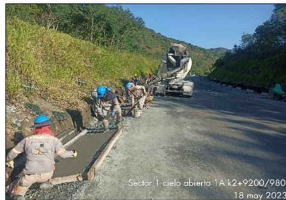
Foto 3-10 Cielo 1 A K2+900-980 fundida de cunetas.
