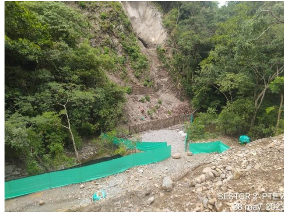
Foto 4-48 Estado de Obras de protección del cauce, pila 2 y estribo 2.
