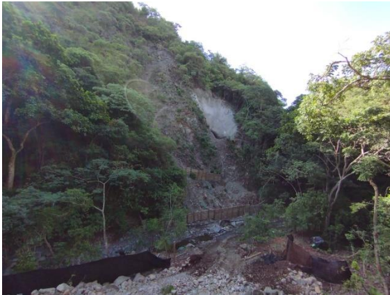
Foto 4-47 Estado de Obras de protección del cauce, estribo 1 y pila 1.
