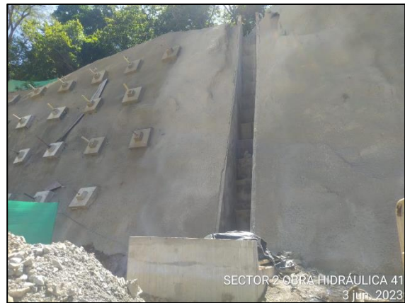
Foto 4-34 Obra hidráulica No. 41 – Box Colbert se realiza remates con concreto lanzado a los lados de los muros del dissipador
