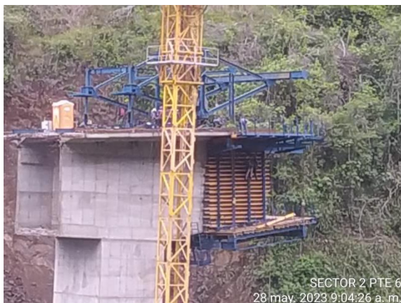
Foto 4-52 Armado de carro de avance de dovelas sobre pila 2.
