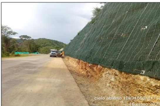
Foto 3-11 Cielo 1 B K3+550-650 excavaciones para construcción de cunetas
