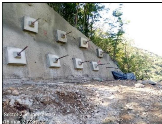
Foto 4-38 Túnel falso 3, hormigonado y desencofrado de los dados en concreto de los anclajes
