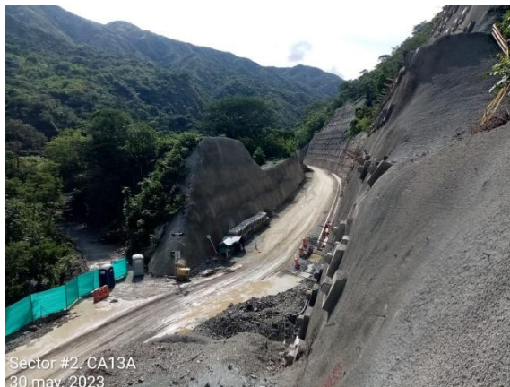
Foto 4-2 K12+356 -K13+664, estado actual
