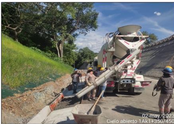
Foto 3-9 Cielo 1 A K1+350-450 fundida de cunetas.
