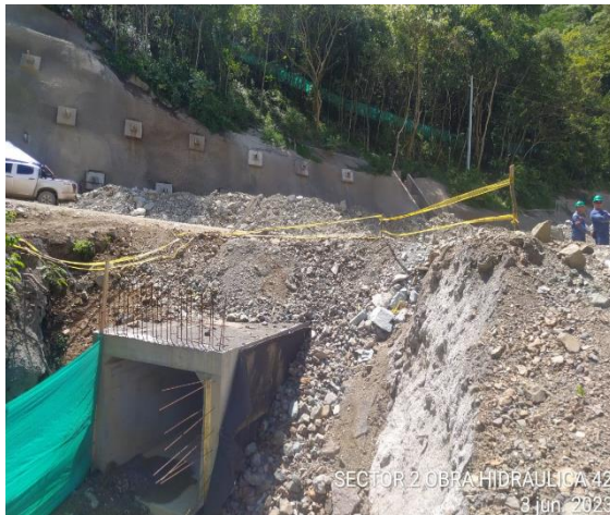
Foto 4-35 Obra hidráulica No. 42 – Box Colbert frente inactivo
