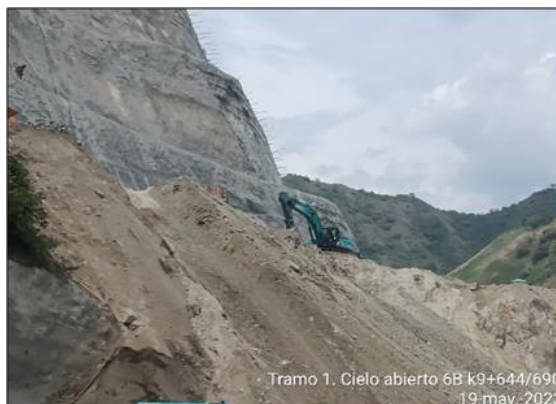
Foto 3-22 Cielo abierto 6B - K9+640-690 corte y perfilado del talud.
