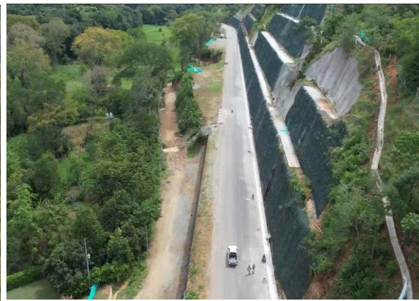
Foto 3-8 K3+330 – K3+900, estado actual
