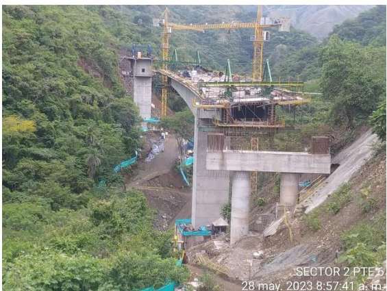
Foto 4-51 Vista general de obras puente 6
