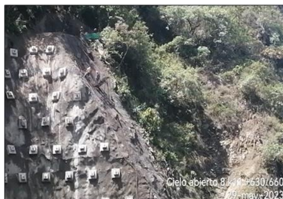
Foto 3-26 P Portal S T No 4- K11+620-640 perforaciones pernos autopeforantes por el talud lateral.
