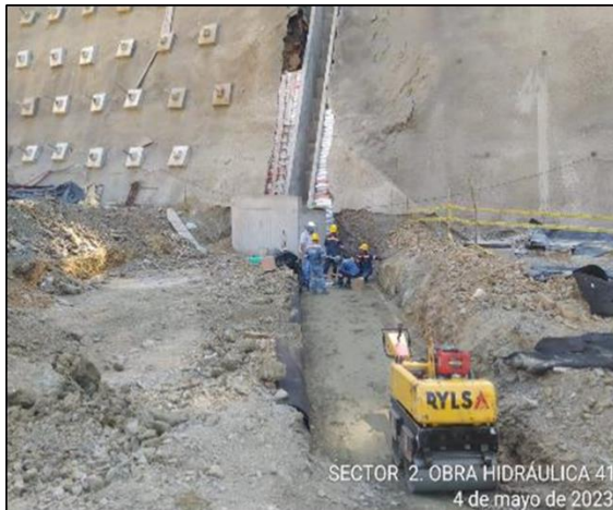
Foto 4-33 Obra hidráulica No. 41 – Box Colbert conformación de relleno estructural con material de sitio del módulo 1.
