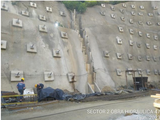
Foto 4-43 Obra hidráulica No 47 alcantarilla de 1200mm remates con concreto lanzado en el talud a lado y lado del dissipador
