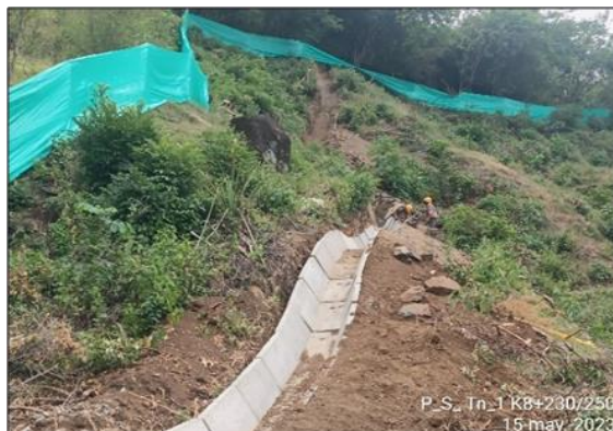
Foto 3-16 Portal salida del túnel No 1 K8+250-300 Construcción de rondas de coronación
