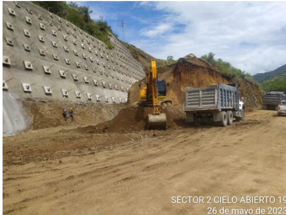
Foto 4-45 Cielo abierto 19, Actividades de excavaciones de material común y en roca.
