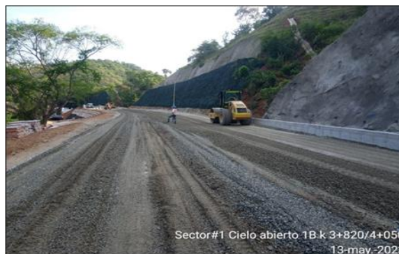
Foto 3-12 Cielo 1 B K3+820 Cerezo de Base Granular.
