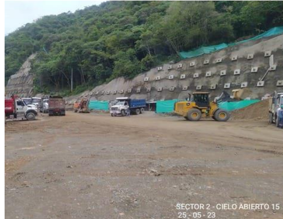
Foto 4-6 K 14+030 –K14+200, estado actual
