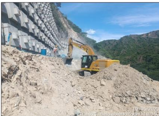
Foto 3-17 Cielo abierto 5 - K9+110-150 corte y perfilado del talud.
