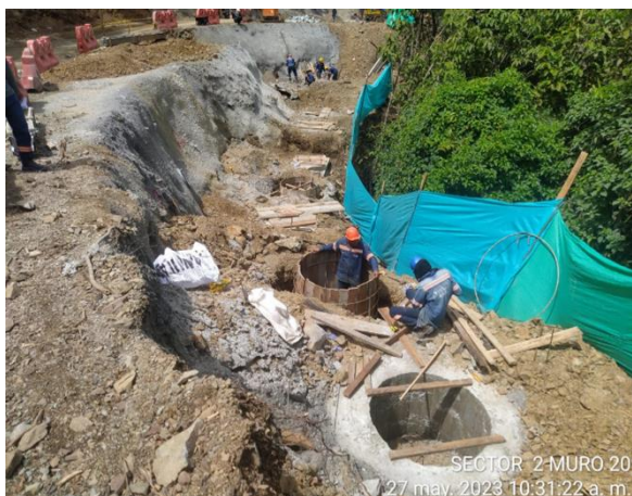
Foto 4-41 Muro 20 excavaciones manuales para la construcción de caisson de 1,20m y 1,50m
