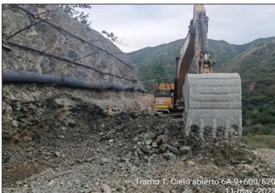
Foto 3-19 Cielo abierto 6A - K9+600-640 corte y perfilado del talud
