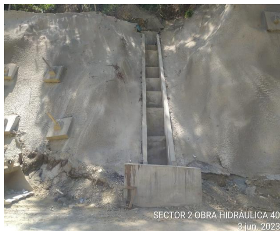
Foto 4-32 Obra hidráulica No 40 alcantarilla de 1200mm frente inactivo
