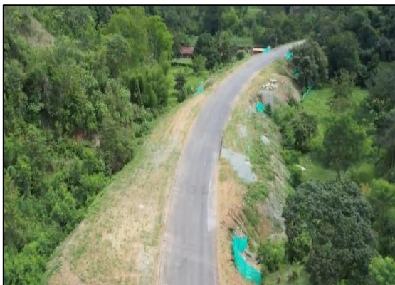
Foto 3-6 Estado inicial K3+050 – K3+330
