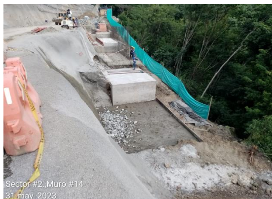
Foto 4-20 muro 14 actividades de mejoramiento del suelo de fundación con concreto ciclópeos módulos 1,2,3,4,5.
