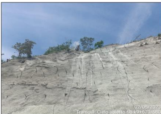
Foto 3-21 Cielo abierto 6B - K9+670-690 perforaciones para anclajes activos.
