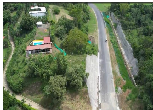
Foto 3-2 K1+600 al K1+800, estado actual
