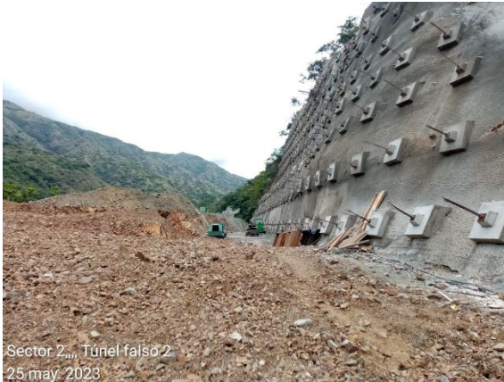
Foto 4-15 Túnel falso 2, actividades de sostenimiento
