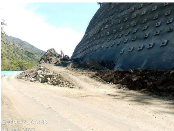
Foto 4-17 Cielo abierto 13B, excavaciones en material común y en roca, perforaciones para construcción de anclajes activos de 30 ton
