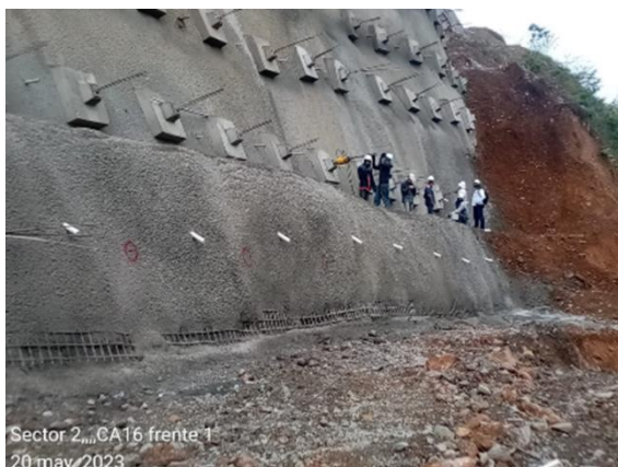
Foto 4-39 Cielo abierto 16, actividades de Sostenimiento, tensionamiento de anclajes activos.
