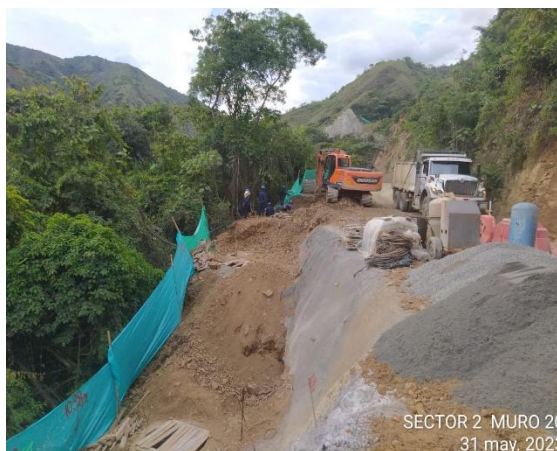
Foto 4-42 muro 20 actividades excavaciones varias sin clasificar, identificación con topografía de los ejes de los pilotes
