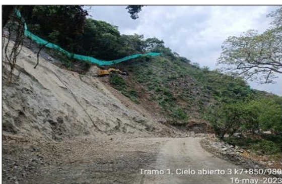
Foto 3-13 Cielo abierto 3 K7+850 - K7+990 corte y perfilado el talud para inició de estabilización del talud.
