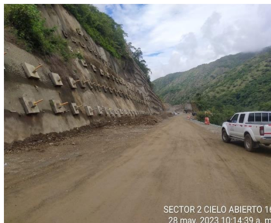
Foto 4-8 K 13+330 –K14+670, estado actual
