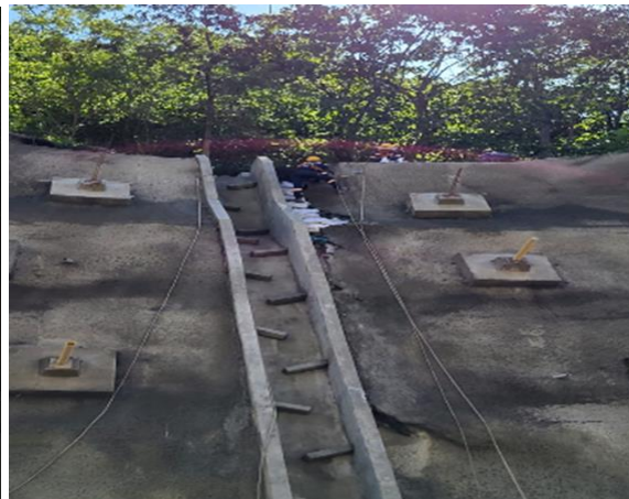
Foto 4-26 canal deflector hormigonado del canal e instalación de aletas
