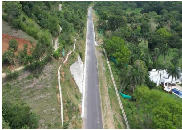
Foto 3-4 K2+300 al K2+600, estado actual
