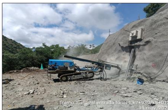
Foto 3-14 Portal entrada túnel No 1 K7+990-K8+00 corte y perfilado el talud para estabilización el portal entrada.
