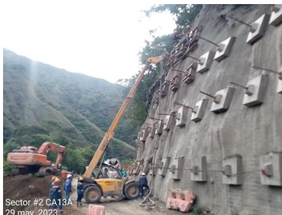
Foto 4-18 Cielo abierto 13A, Se realiza perforaciones para construcción de anclajes y construcción de obras de drenaje
