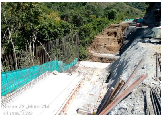
Foto 4-19 Muro 14 actividades de hormigonado de zapata de módulos 1,2, e instalación de acero de refuerzo
