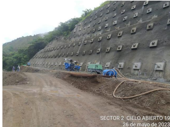
Foto 4-46 Cielo abierto 19, actividades de sostenimiento frente 1,2,3
