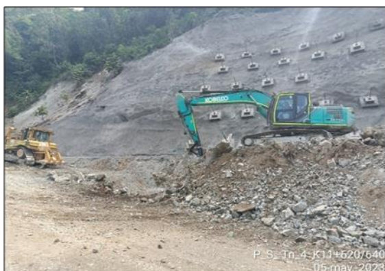
Foto 3-25 Portal S T No 4- K11+620-640 corte y perfilado del talud.
