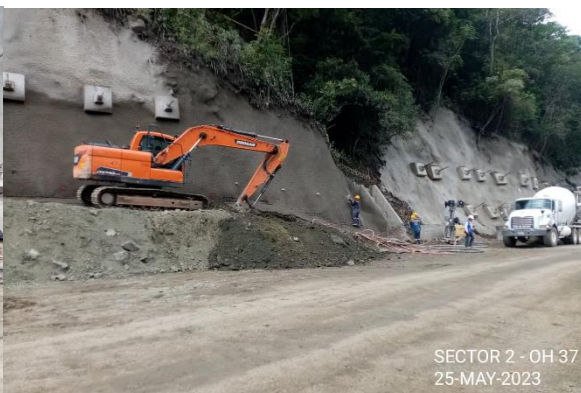
Foto 4-22 Obra hidráulica No 37 actividades de concreto lanzado en las zonas laterales del dissipador.
