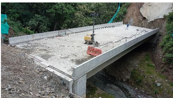
Foto 461 Puente 5, aspecto actual desde estribo 1.
