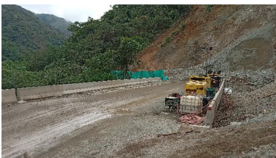
Foto 459 Puente 4 en servicio de obra y comunidad.
