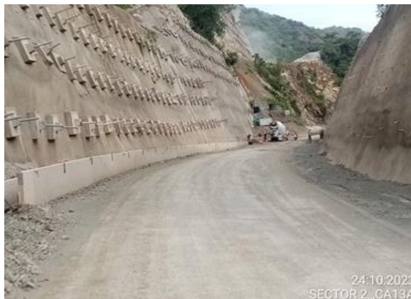
Foto 4-2 K12+356 -K13+664, estado actual
