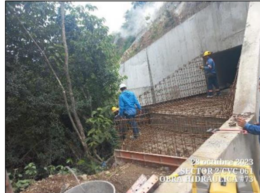
Foto 440 obra hidráulica No 73 obras de drenaje en el descole
