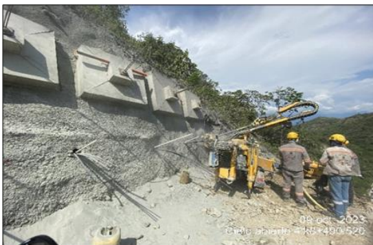
Foto 311 Cielo Abierto 4 K9+480 – 500 perforaciones para anclajes activos
