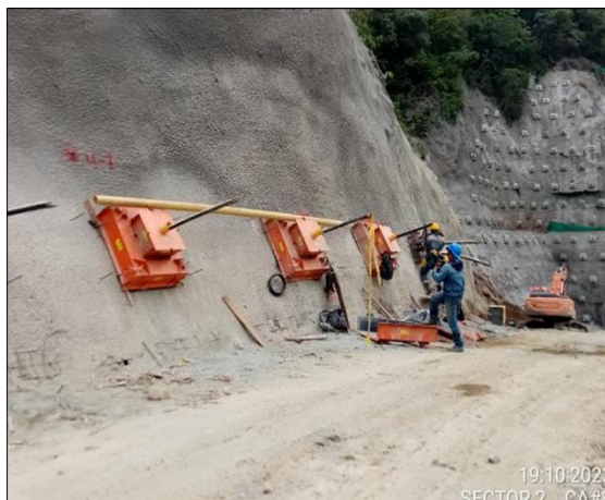
Foto 4-12 Cielo abierto 8, instalación de acero de refuerzo y hormigonado de dados de los anclajes
