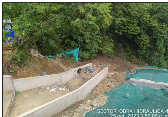
Foto 4-32 Obra hidráulica No. 41 – Box Culvert Hormigonado de losa y muros del dissipador módulos 1,2,3
