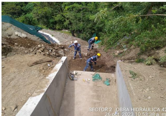
Foto 4-33 Obra hidráulica No. 42 – Box Colbert excavación manual, amarre de acero de refuerzo de la losa inferior
