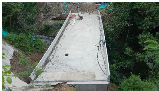
Foto 462 Puente 5, aspecto actual desde estribo 2.
