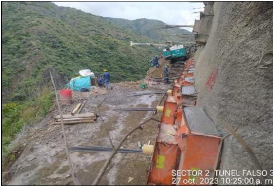
Foto 4-35 Túnel falso 3, perforaciones para construcción de anclajes activos de 40ton
