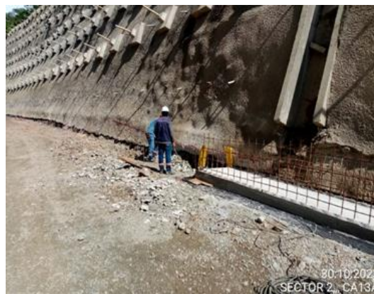
Foto 4-24 canal deflector se realiza hormigonado y conexión del canal deflector con el canal longitudinal de CA 13 A
