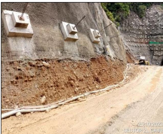
Foto 4-11 Cielo abierto 8, concreto lanzado e instalación de malla electrosoldada
