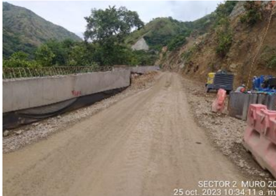
Foto 441 Muro 20 frente inactivo
