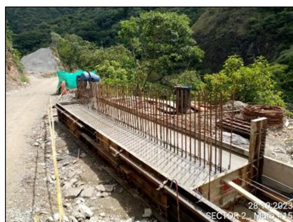
Foto 422 muro 15 Hormigonado con concreto de 28 Mpa la viga cabezal de los módulo 1,2
