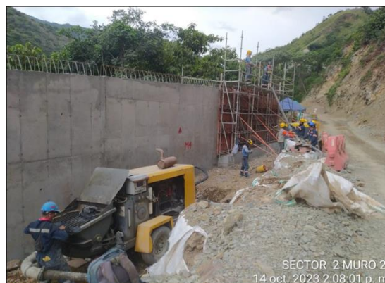
Foto 4-44 muro 21 hormigonado de la viga cabezal y vastago del modulo 4
