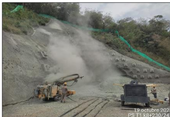
Foto 3-10 Portal salida del túnel No 1 K8+230-250 perforaciones para pernos pasivos
