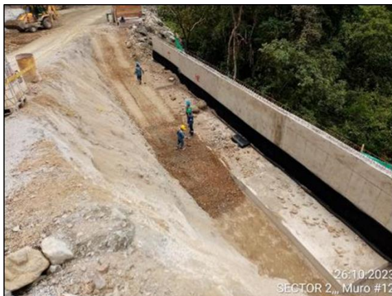
Foto 414 muro 12 actividades de relleno estructural con material de sitio
