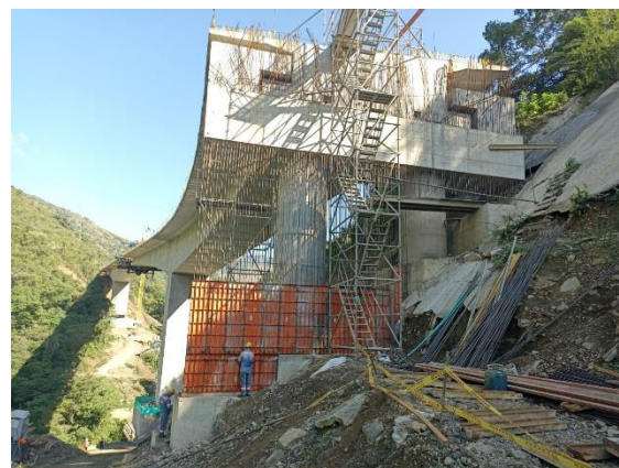
Foto 4-64 Avance en construcción del faldón estribo 1.
