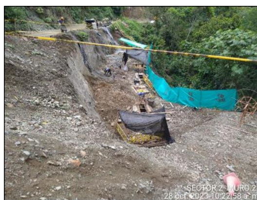
Foto 446 muro 22 excavaciones manuales para construcción de caisson
