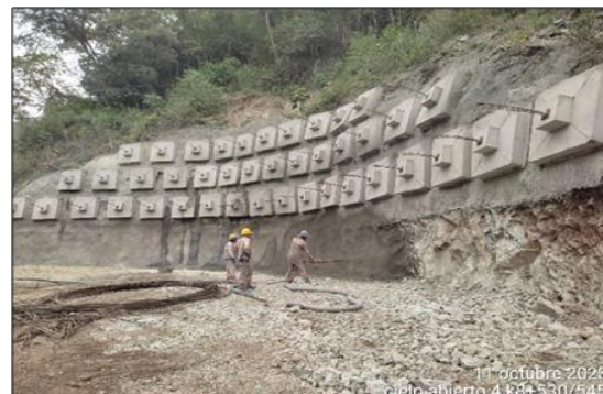
Foto 312 Cielo abierto 4 K9+530-550 aplicación de concreto lanzado.
