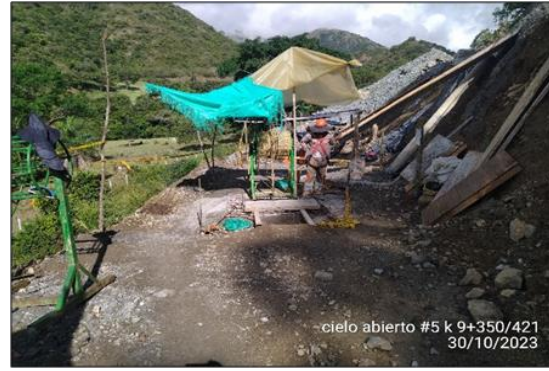
Foto 3-14 Cielo abierto 5 K9+350-421 excavación manual para caissons de muro de contención.
