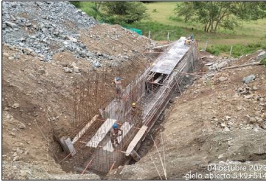
Foto 3-13 Cielo Abierto 5 K9+514 construcción de obra hidráulica.
