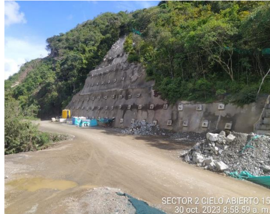
Foto 4-6 K 14+030 –K14+200, estado actual
