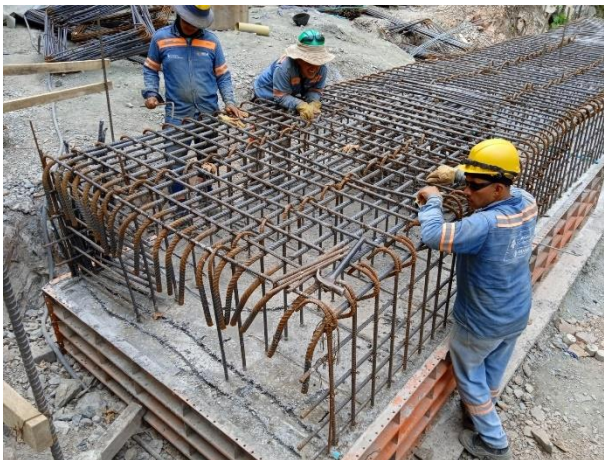
Foto 455 Avance general de puente 2, vista de estribo 2.
