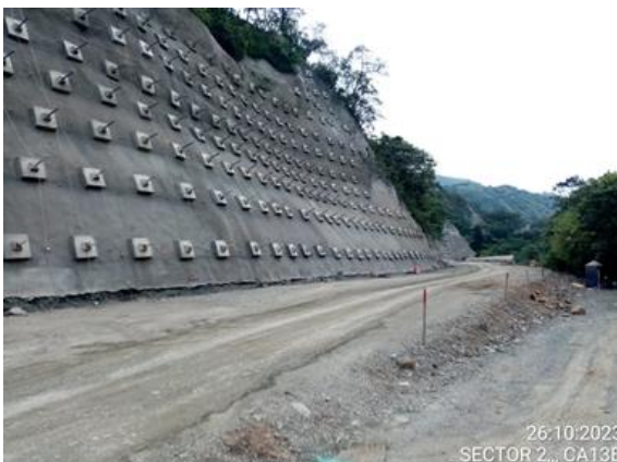
Foto 4-4 K12+356 -K13+664, estado actual
