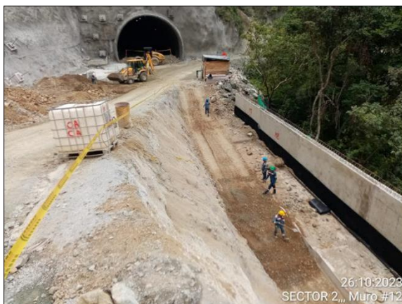
Foto 413 Muro 12 actividades de instalación del geodren planar en el vástago del muro
