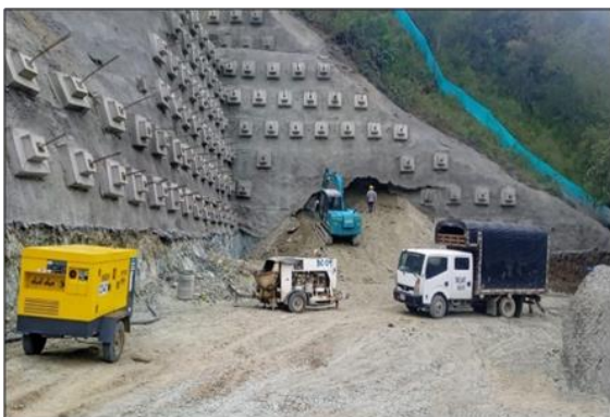
Foto 3-9 Portal salida del túnel No 1 K8+230-250 corte y perfilado del talud.
