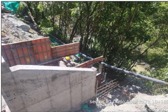
Foto 3-15 Cielo 7 K10+183 terminación construcción del descole de la obra hidráulica.
