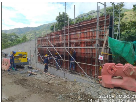
Foto 4-43 Muro 21 hormigonado de viga cabezal modulo 2
