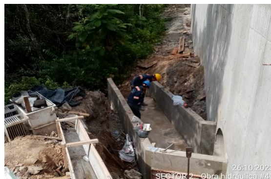
Foto 4-30 Obra hidráulica No 40 alcantarilla de 1200mm hormigonado de losa inferior y muros del dissipador
