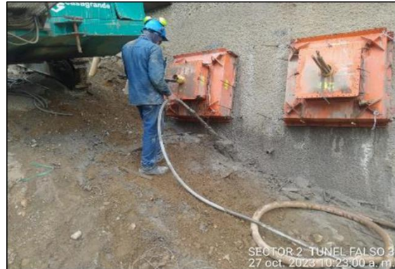
Foto 4-36 Túnel falso 3, hormigonado de dados e inyección de anclajes
