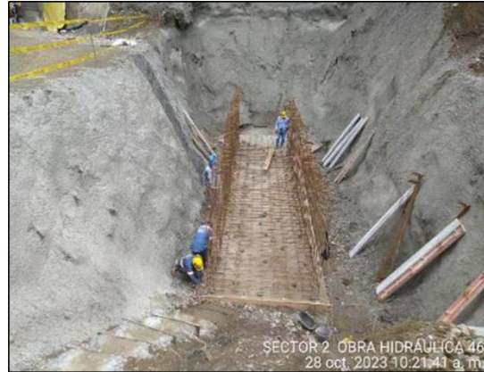
Foto 448 muro 21 hormigonado de la viga cabezal y vastago del modulo 4
