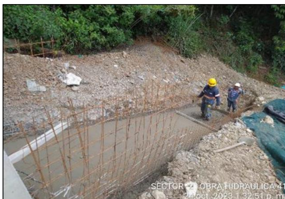
Foto 4-31 Obra hidráulica No. 41 – Box Culvert amarre de acero de refuerzo de losa y muros del dissipador
