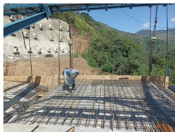
Foto 4-66 Preparativos para hormigonado de dovelas 17 voladizos 3 y 4.
