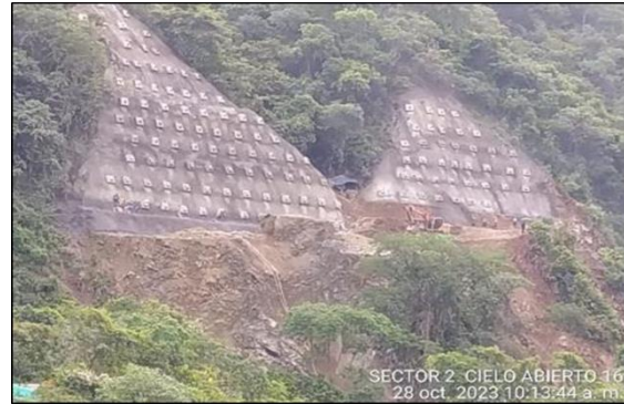
Foto 4-38 Cielo abierto 16, perforaciones para construcción de anclajes activos de 40 ton
