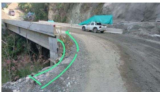
Foto 457 Puente 3 en servicio de obra y comunidad.
