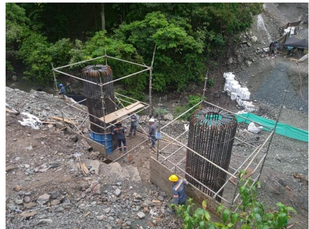
Foto 456 Construcción de columnas circulares 5 y 6 en pila 2.
