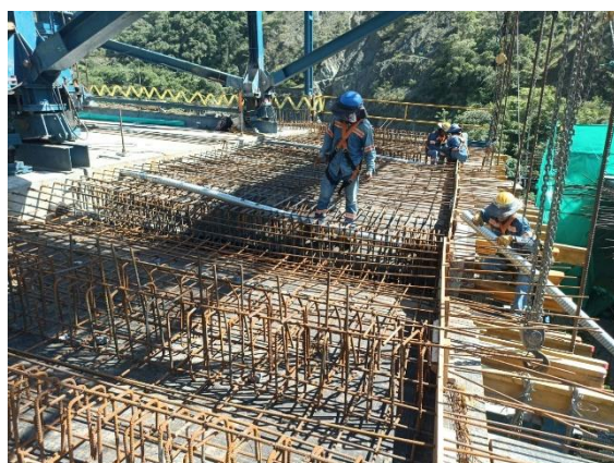
Foto 4-65 Armado de acero y ductos en dovelas 17, voladizos 3 y 4
