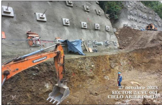
Foto 4-37 Cielo abierto 16, actividades de excavaciones de material común y roca
