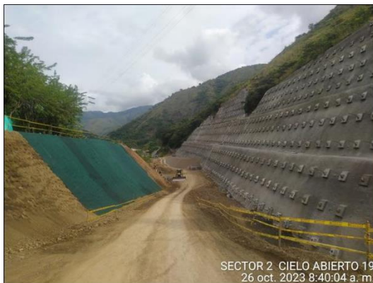
Foto 4-51 Cielo abierto 19, Actividades de hidro siembra en el talud izquierdo
