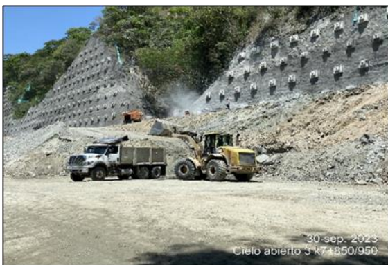
Foto 3-7 Cielo abierto 3 corte de talud para construcción de muro MSE.
