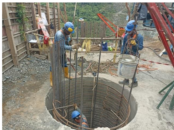
Foto 467 Armado de acero en pilotes 11 y 12 estribo 2.
