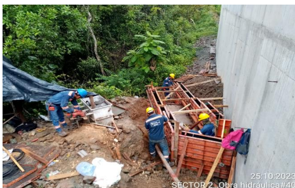
Foto 4-29 Obra hidráulica No 40 alcantarilla de 1200mm instalación de acero de refuerzo de muros y losa inferior del dissipador
