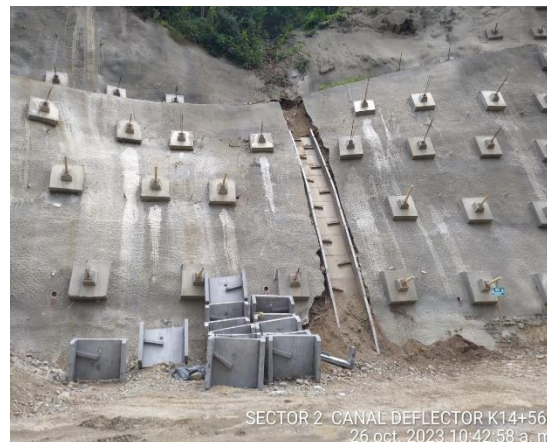
Foto 4-8 K 13+330 –K14+670, estado actual
