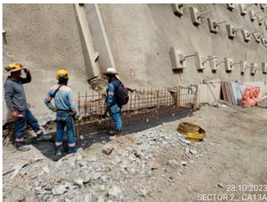
Foto 4-23 canal deflector se realiza instalación de acero de refuerzo para viga inferior y muros del canal longitudinal
