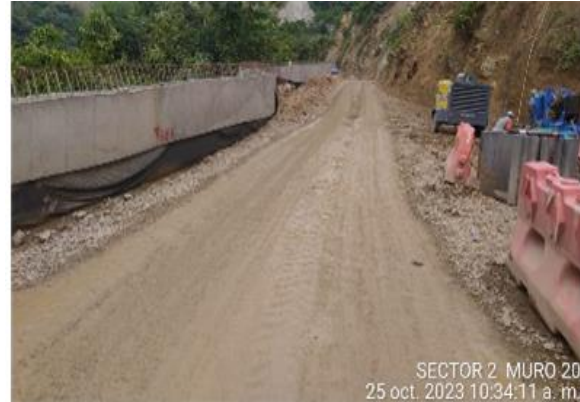
Foto 442 muro 20 frente inactivo
