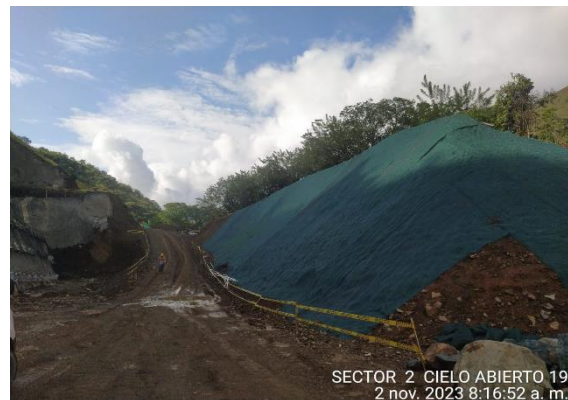
Foto 4-52 Cielo abierto 19, actividades de hidro siembra talud izquierdo
