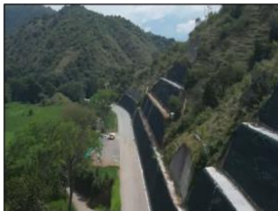
Foto 3-6 K3+330 – K3+900, estado actual
