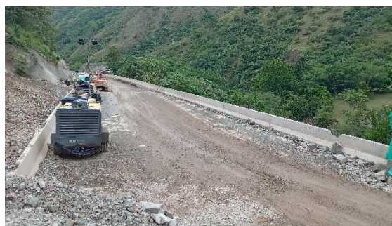
Foto 460 Puente 4 en servicio de obra y comunidad.
