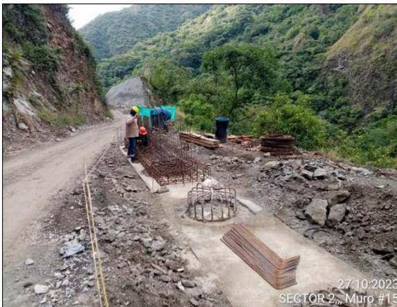
Foto 421 Muro 15 amarre de acero de refuerzo de viga cabezal y vástago de los módulos 1,2
