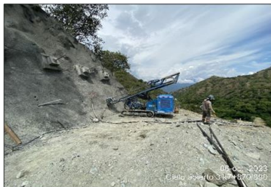
-Foto 38 Cielo abierto 3 perforación para instalación de anclajes activos.
