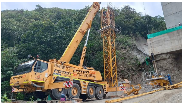
Foto 4-63 Desmonte de torre grúa pila 1.
