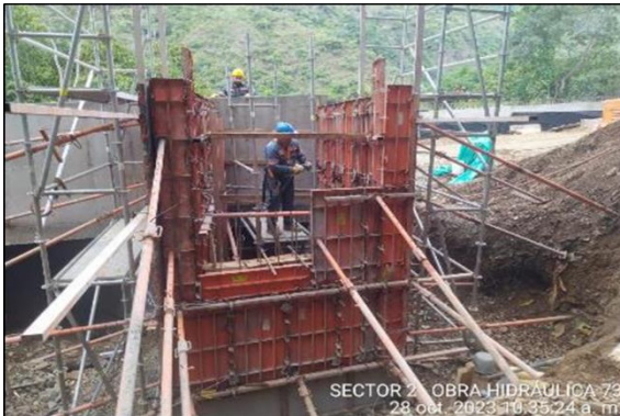
Foto 439 obra hidráulica No 73 obras de drenaje en el encole
