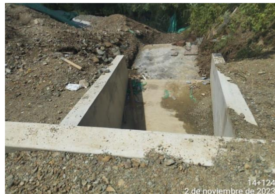
Foto 4-34 Obra hidráulica No. 42 – Box Colbert hormigonado de la losa inferior
