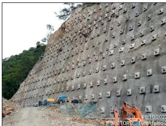
Foto 4-18 Túnel falso 2, perforaciones de anclajes con canasta e instalación de acero de refuerzo para los dados.
