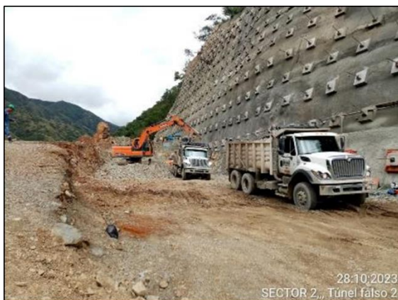
Foto 4-17 Túnel falso 2, actividades de excavaciones de material común y en roca con martillo
