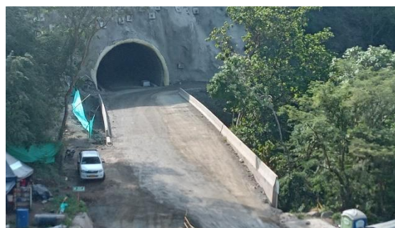
Foto 458 Puente 3 en servicio de obra y comunidad.
