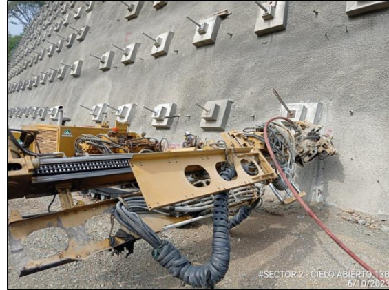
Foto 4-20 Cielo abierto 13A, Se realiza actividades de perforaciones para anclajes pasivo y perforaciones para drenes
