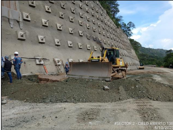
Foto 4-19 Cielo abierto 13B, excavaciones en material común y mejoramiento de un sector del cielo abierto 13B con material de sitio.
