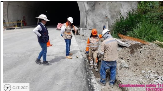
Fotografía No. 1– Acompañamiento canalizaciones salida túnel 14
