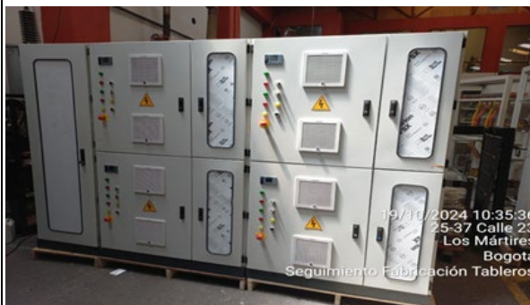
Fotografía No. 12 Seguimiento Fabricación de Tableros - 19 de octubre de 2024.
