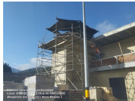
Fotografía 2. Recorrido tramo 1 para mirar estado de las galerías y CCO.
