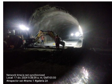
Fotografía 4. Verificación de ubicación de subestaciones eléctricas y estado actual Tramo 1 Y Tramo 2
