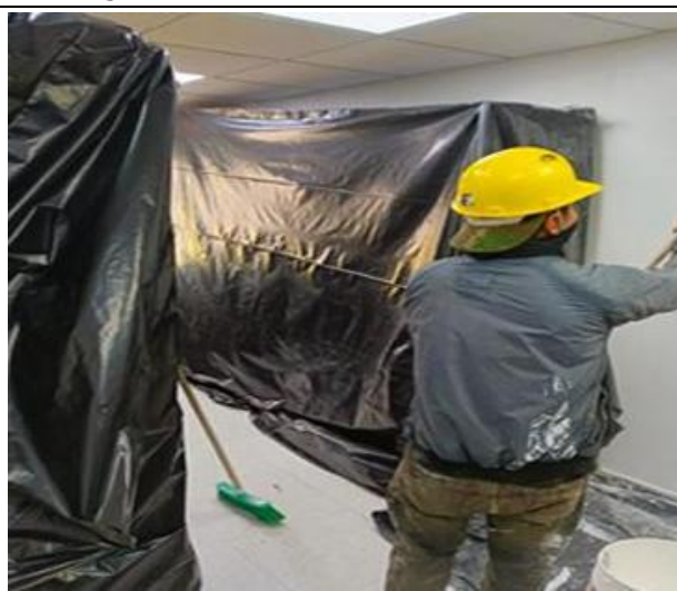
Uso de dotación EPPS para ejecución de trabajos – ORIP IPIALES
