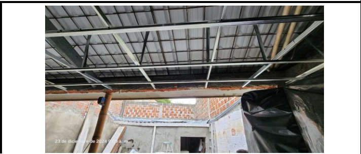
Comentario: Demolición de muro para ampliación de zona de archivo.
