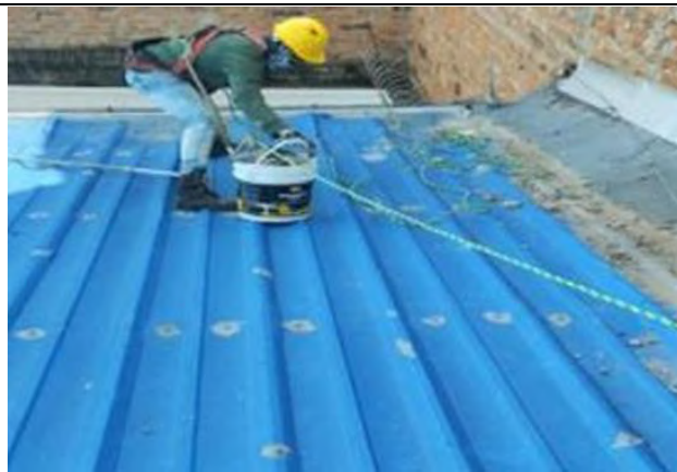
Uso de dotación EPPS para ejecución de trabajos – ORIP IPIALES
