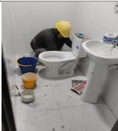
Uso de dotación EPPS para ejecución de trabajos – ORIP IPIALES
