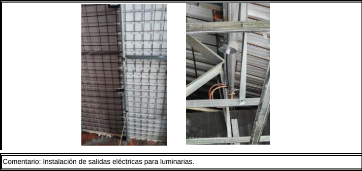
Comentario: Instalación de salidas eléctricas para luminarias.
