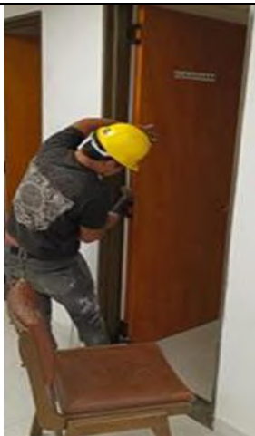
Uso de dotación EPPS para ejecución de trabajos – ORIP IPIALES
