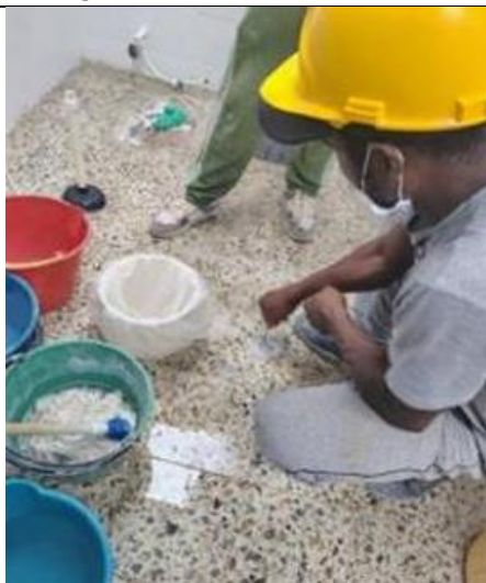
Uso de dotación EPPS para ejecución de trabajos – ORIP QUIBDÓ
