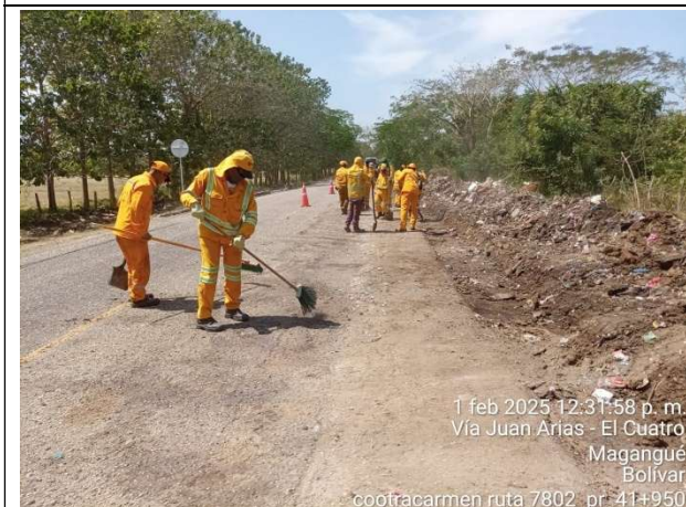
LIMPIEZA DE CALZADA
