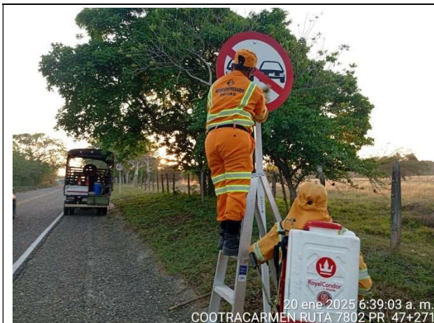
LIMPIEZA DE SEÑALES DE TRANSITO
