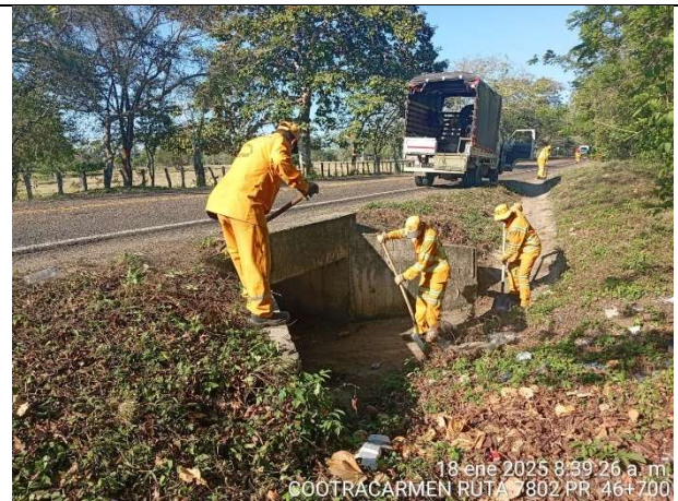
LIMPIEZA DE OBRAS DE ARTE
