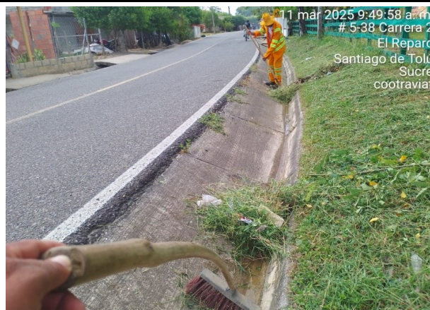
Imagen 6. Pr 03+0850, Limpieza de cunetas.
