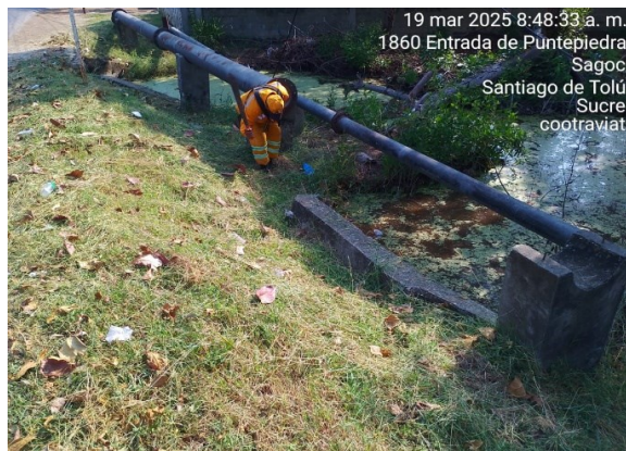
Imagen 10. Pr 33+0850, Limpieza de alcantarillas.
