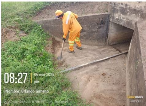
Imagen 3. Pr 77+0500, Limpieza de boxculvert.
