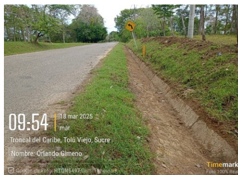
Imagen 10. Pr 75+0250, Limpieza de boxculvert.
