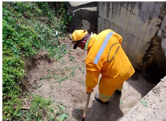
Imagen 2. Pr 4 +0995, Limpieza de boxculvert.
