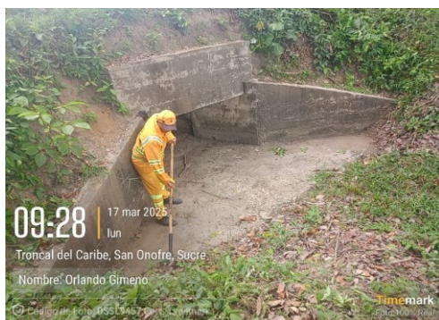
Imagen 9. Pr 89+0500, Limpieza de boxculvert.
