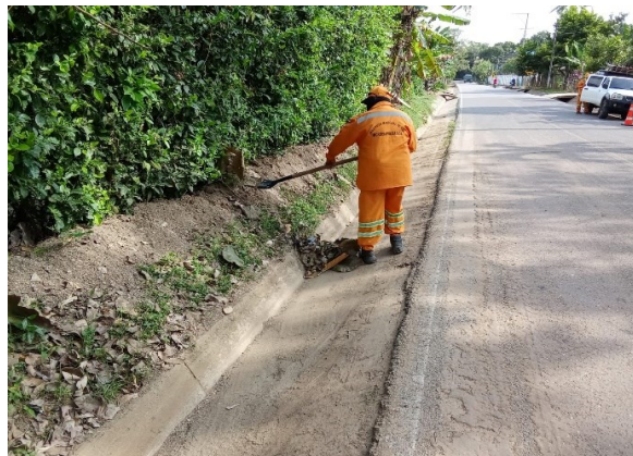
Imagen 4. Pr 4+0600, Limpieza de cunetas y calzada.
