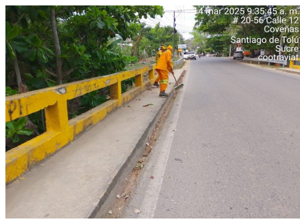
Imagen 8. Pr 30+0700, Limpieza de puentes.
