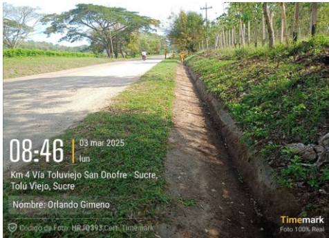
Imagen 1. Pr 72+0050, Limpieza de cunetas.
