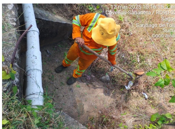
Imagen 7. Pr 02+0580, Limpieza de boxculvert.
