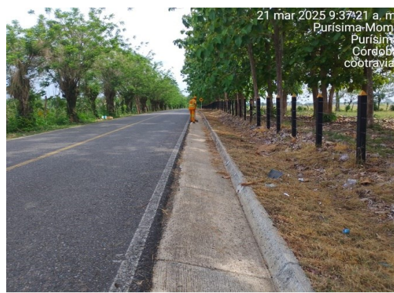
Imagen 12. Pr 15+0600, Limpieza de cunetas.
