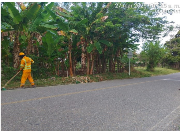
Imagen 15. Pr 12+0450, Limpieza de cunetas.
