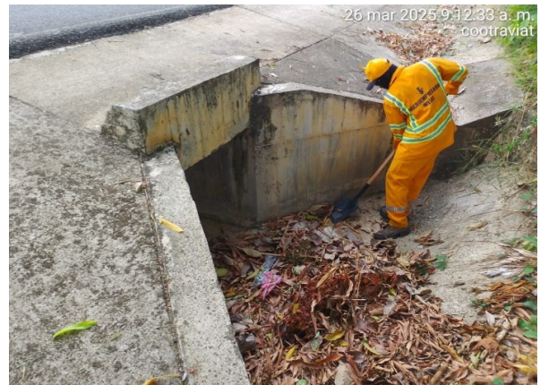
Imagen 14. Pr 13+0450, Limpieza de boxculvert.
