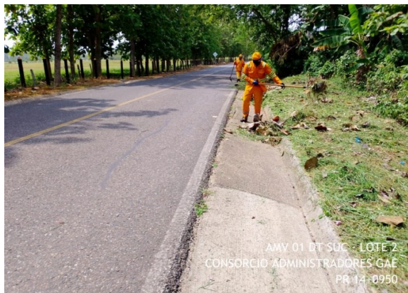
Imagen 1. Pr 14+0950, Limpieza de cunetas.
