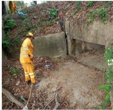
Imagen 14. Pr 68+0650, Limpieza de boxculvert.
