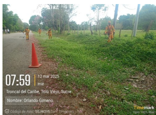
Imagen 7. Pr 82+0500, Limpieza de cunetas.
