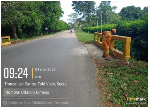
Imagen 2. Pr 74+0450, Limpieza de puentes.
