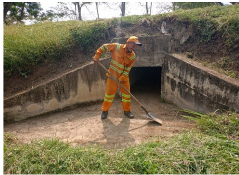
Imagen 16. Pr 70+0500, Limpieza de cunetas.
