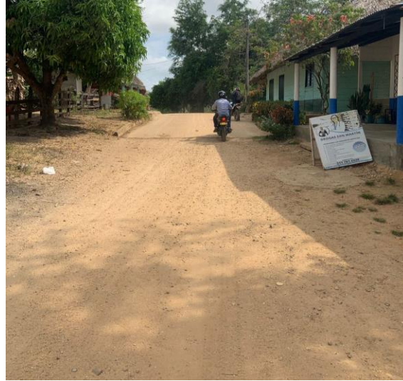
Descripción: Recorrido de la vía La Quebrada - Caño Prieto, municipio de San Marcos Fecha: 25 de enero de 2023
