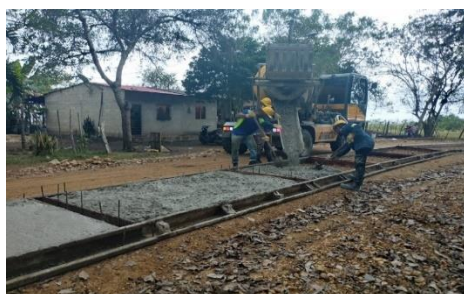
CONSTRUCCIÓN PLACA HUELLA 05 de enero de 2023
