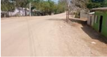
CONTROL DE TRANSITO Y SEÑALIZACION
