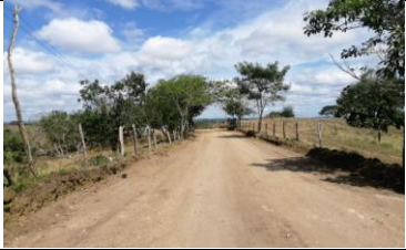
CONFORMACION DE VIA
