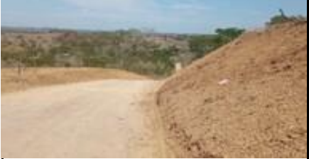
CONFORMACION DE VIA
