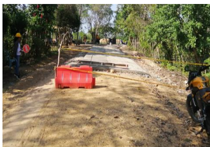
CONSTRUCCIÓN PLACA HUELLA 18 de enero de 2023
