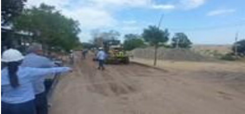
CONFORMACION DE VIA
