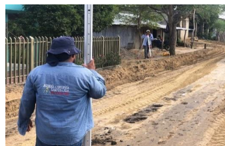
VERIFICACIÓN NIVELES DE TERRENO 11 de enero de 2023
