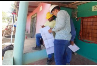
CHEQUEO NIVELACION DE TERRENO CON EQUIPO TOPOGRAFICO
