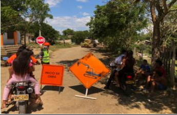
CONTROL DE TRANSITO Y SEÑALIZACION
