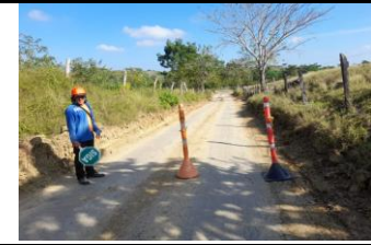
CHEQUEO SEÑALIZACION Y CONTROL DE TRANSITO
