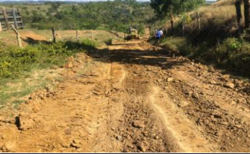
CONFORMACION DE VIA
