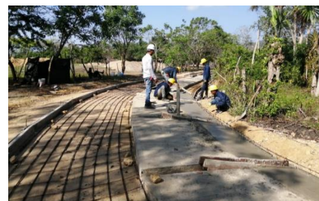
CONSTRUCCIÓN PLACA HUELLA 11 de enero de 2023
