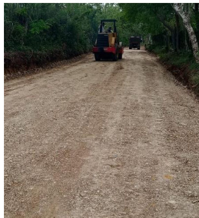
CONFORMACION DECALZADA 19 DE ABRIL DE 2023
