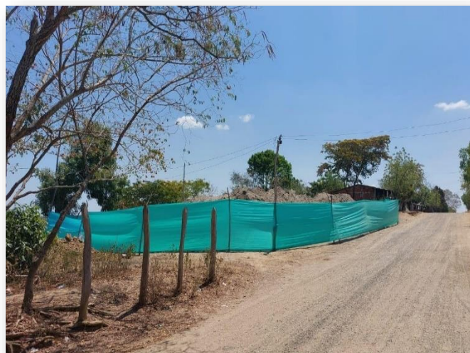
ACOPIO DE MATERIALES, 13 ABRIL 2023
