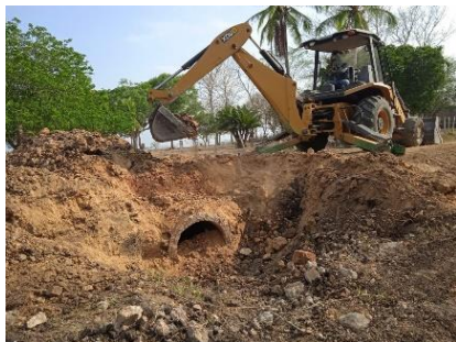
DEMOLICIÓN ESTRUCTURA DE DRENAJE EXISTENTE. . 04/04/2023
