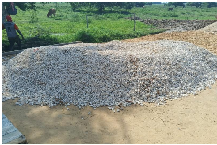
ACOPIO DE MATERIALES, 6 ABRIL 2023
