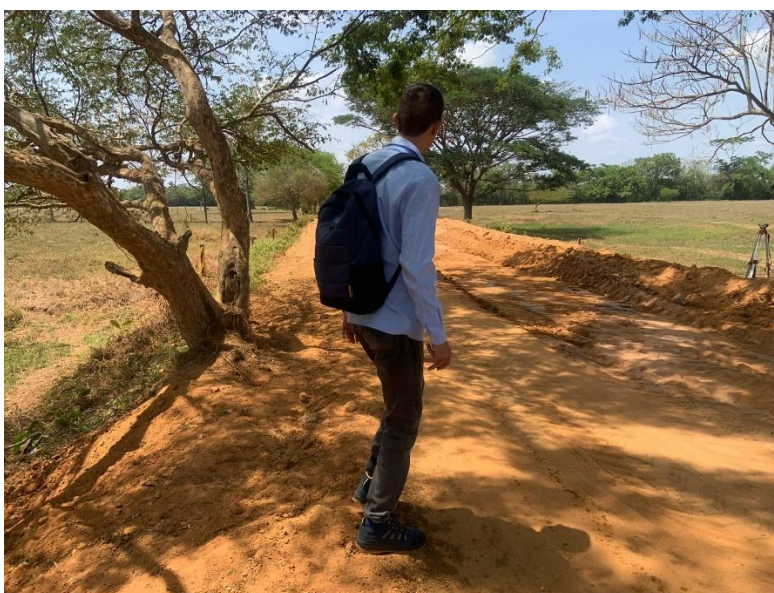
Presencia en lugar de ejecución de obra vía La Quebrada- Caño Prieto, municipio de San Marcos. 04/04/2023
