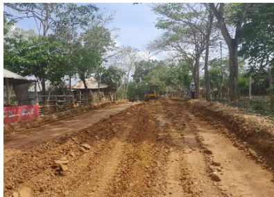
CONFORMACIÓN DE BANCA. Compactación de material seleccionado. 11/04/2023
