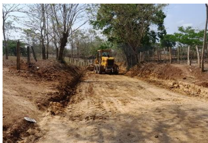
CONFORMACIÓN DE BANCA. Mejoramiento con material seleccionado tipo afirmado. 03/04/2023
