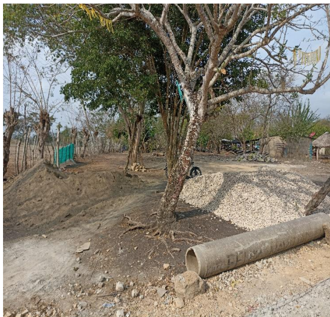
ACOPIO DE MATERIAL, 25 ABRIL 2023
