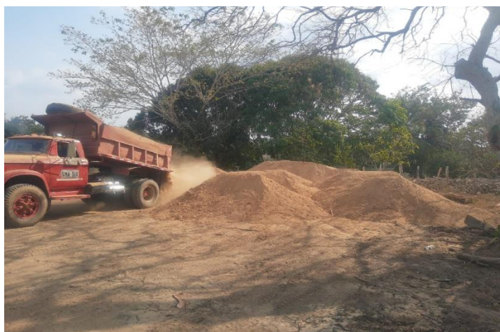
ACOPIO DE MATERIALES, 6 ABRIL 2023
