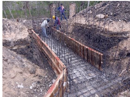
CONSTRUCCIÓN BOX- CULVERT. 28/04/2023
