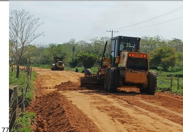
Descripción: conformación de terraplen obra via Calle Nueva - Cuiva, municipio de San Benito FECHA: 18 DE ABRIL DE 2023
