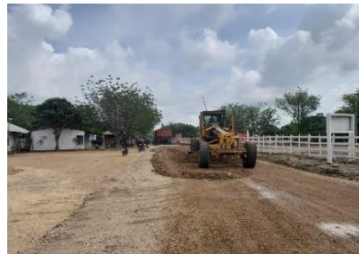
CONFORMACIÓN DE BANCA. Mejoramiento con material seleccionado tipo afirmado. 28/04/2023
