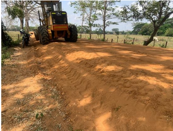
Descripción: Conformación de afirmado via La Quebrada – Caño Prieto FECHA: 7 DE ABRIL DE 2023
