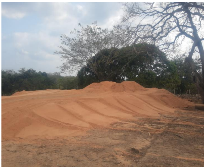
ACOPIO DE MATERIALES, 12 ABRIL 2023
