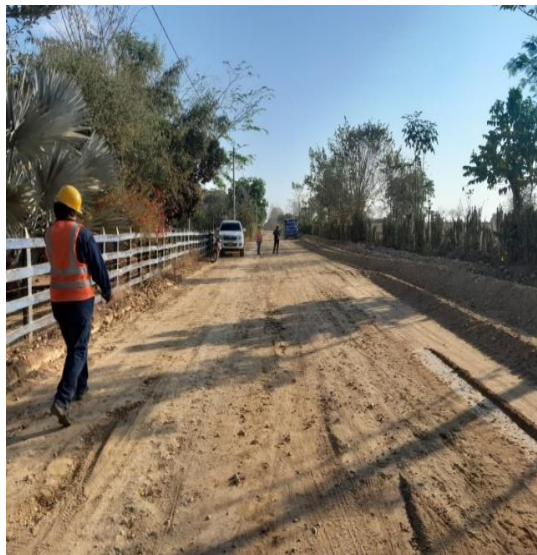
CONFORMACION DECALZADA 19 DE ABRIL DE 2023
