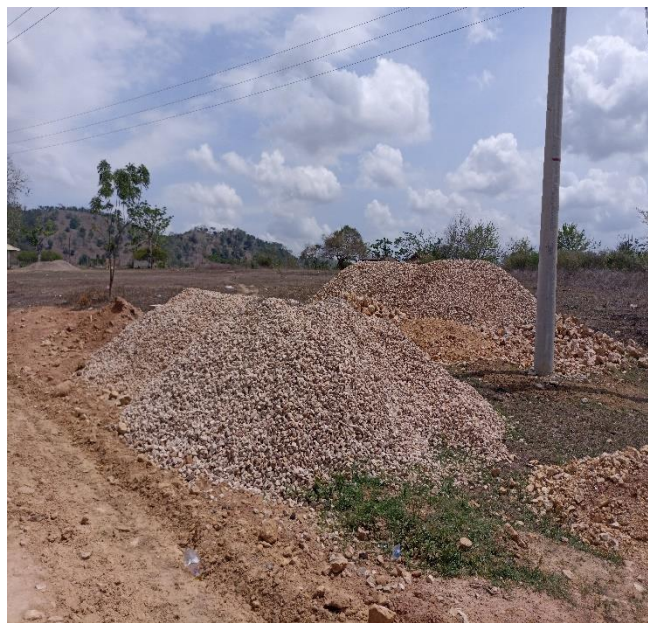
ACOPIO DE MATERIAL, 25 ABRIL 2023
