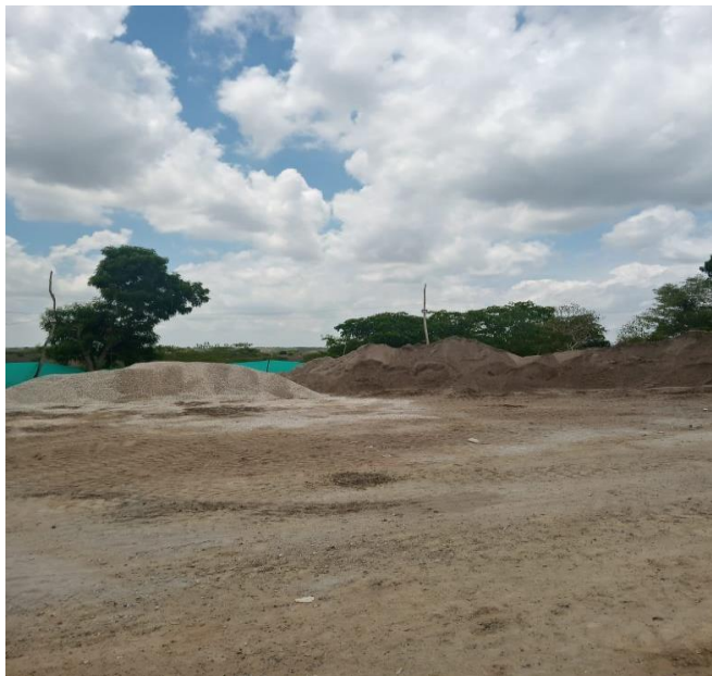
ACOPIO MATERIALES, 12 ABRIL 2023
