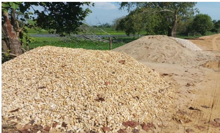
ACOPIO DE MATERIALES, 6 ABRIL 2023
