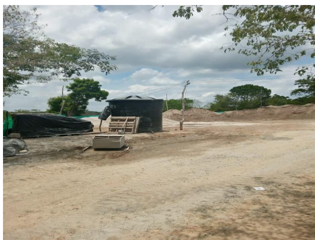
ACOPIO DE MATERIALES, 12 ABRIL 2023
