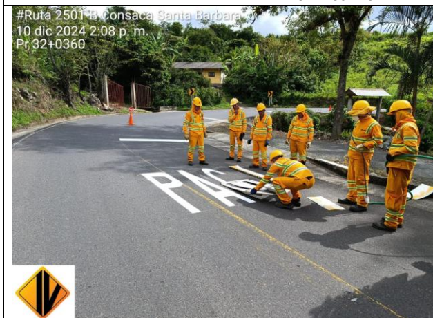
ACTIVIDAD INSPECCIÓN PINTURA SEÑALIZACIÓN HORIZONTAL EN SITIO ALTA ACCIDENTALIDAD PR 32+0360 (RECURSOS AMV) RUTA 2501B CEBADAL – SANDONA – SANTA BARBARA
