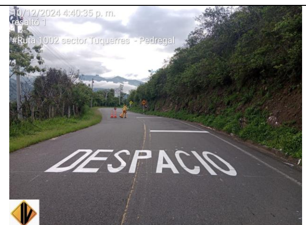
ACTIVIDAD INSPECCIÓN PINTURA SEÑALIZACIÓN HORIZONTAL EN SITIO ALTA ACCIDENTALIDAD – RESALTO VIRTUAL PR 32+0241 Y LEYENDA DESPACIO PR31+0912 (RECURSOS AMV) RUTA 2501B CEBADAL – SANDONA – SANTA BARBARA
