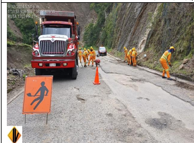
ACTIVIDAD INSTALACIÓN DE MEZCLA ASFÁLTICA PR 21+0200 – CONTRATO 4142 DE 2024 RUTA 1702 TUQUERRES - SAMANIEGO
