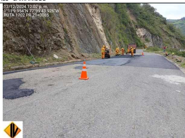
ACTIVIDAD INSTALACIÓN DE MEZCLA ASFÁLTICA PR 21+0085 – CONTRATO 4142 DE 2024 RUTA 1702 TUQUERRES - SAMANIEGO
