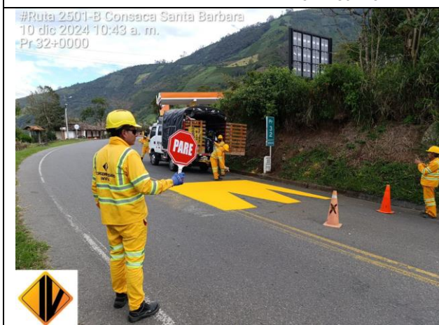
ACTIVIDAD INSPECCIÓN PINTURA SEÑALIZACIÓN HORIZONTAL EN SITIOS ALTA ACCIDENTAL PR 32+0000 (RECURSOS AMV) RUTA 2501B CEBADAL – SANDONA – SANTA BARBARA
