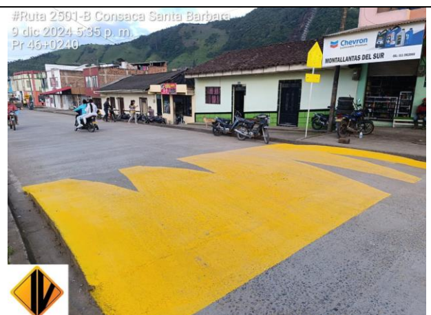
ACTIVIDAD INSPECCIÓN PINTURA SEÑALIZACIÓN HORIZONTAL EN ZONA ESCOLAR PR 46+0300 (RECURSOS AMV) RUTA 2501B CEBADAL – SANDONA – SANTA BARBARA
