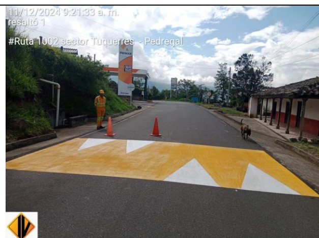
ACTIVIDAD INSPECCIÓN PINTURA SEÑALIZACIÓN HORIZONTAL EN SITIO ALTA ACCIDENTALIDAD – RESALTO VIRTUAL PR 32+0081 (RECURSOS AMV) RUTA 2501B CEBADAL – SANDONA – SANTA BARBARA
