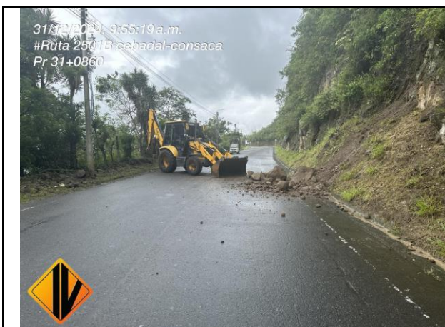
ACTIVIDAD REMOCIÓN DE ROCA Y MATERIAL DE DERRUMBE SOBRE LA CALZADA PR 29+0750, PR29+0870, PR31+0860 (RECURSOS AMV) RUTA 2501B CEBADAL – SANDONA – SANTA BARBARA
