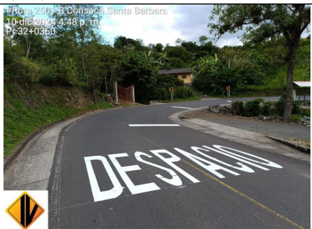
ACTIVIDAD INSPECCIÓN PINTURA SEÑALIZACIÓN HORIZONTAL EN SITIO ALTA ACCIDENTALIDAD PR 32+0360 (RECURSOS AMV) RUTA 2501B CEBADAL – SANDONA – SANTA BARBARA
