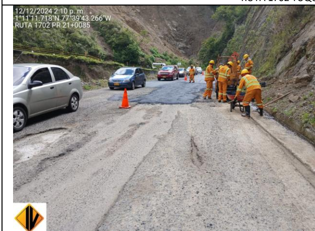
ACTIVIDAD INSTALACIÓN DE MEZCLA ASFÁLTICA PR 21+0085 – CONTRATO 4142 DE 2024 RUTA 1702 TUQUERRES - SAMANIEGO
