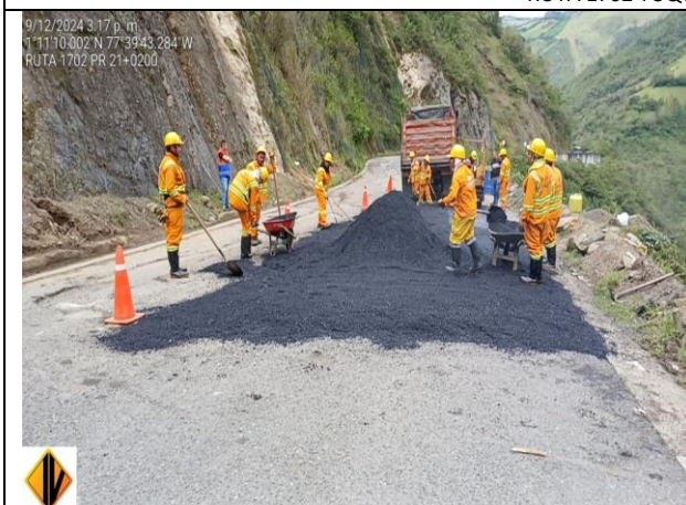
ACTIVIDAD INSTALACIÓN DE MEZCLA ASFÁLTICA PR 21+0200 – CONTRATO 4142 DE 2024 RUTA 1702 TUQUERRES - SAMANIEGO
