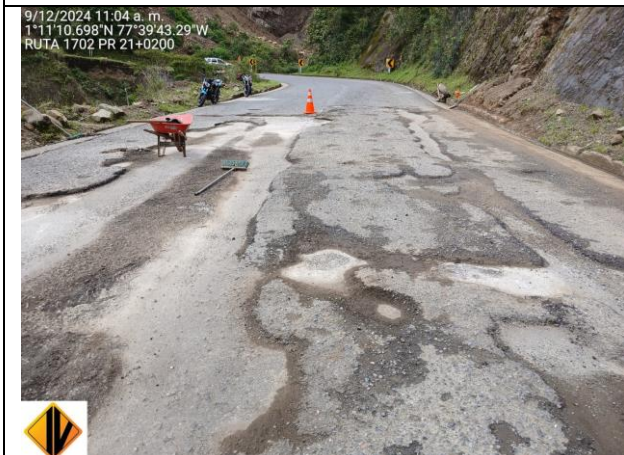
ACTIVIDAD PREPARACIÓN DE CALZADA PARA SUMINISTRO DE MEZCLA ASFÁLTICA PR 21+0200 – CONTRATO 4142 DE 2024 RUTA 1702 TUQUERRES - SAMANIEGO
