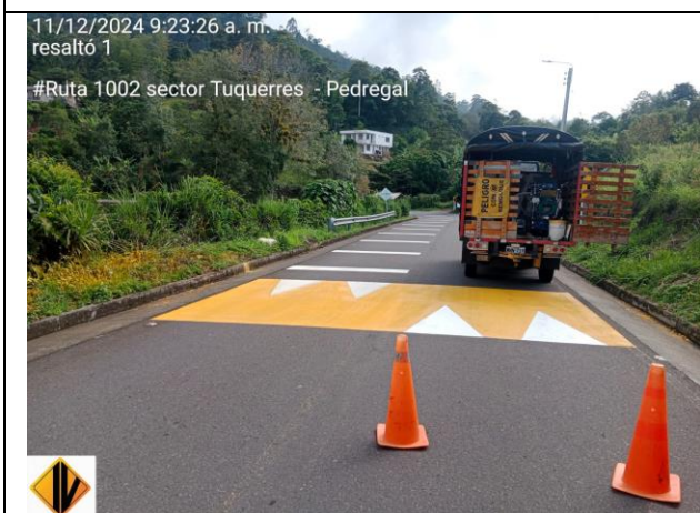
ACTIVIDAD INSPECCIÓN PINTURA SEÑALIZACIÓN HORIZONTAL EN SITIO ALTA ACCIDENTALIDAD – RESALTO VIRTUAL PR 32+0241 Y LEYENDA DESPACIO PR31+0912 (RECURSOS AMV) RUTA 2501B CEBADAL – SANDONA – SANTA BARBARA
