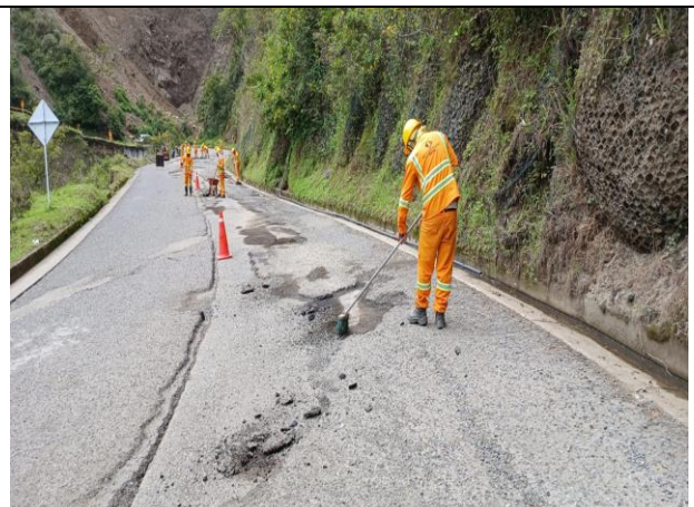
ACTIVIDAD PREPARACIÓN DE CALZADA PARA SUMINISTRO DE MEZCLA ASFÁLTICA PR 21+0200 – CONTRATO 4142 DE 2024 RUTA 1702 TUQUERRES - SAMANIEGO
