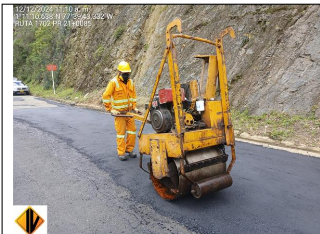
ACTIVIDAD INSTALACIÓN DE MEZCLA ASFÁLTICA PR 21+0085 – CONTRATO 4142 DE 2024 RUTA 1702 TUQUERRES - SAMANIEGO
