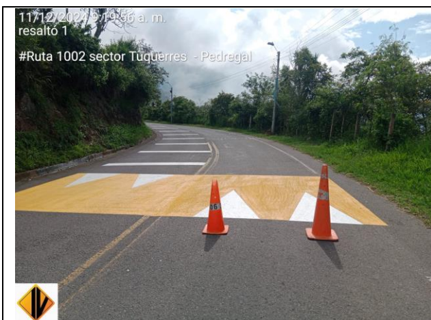
ACTIVIDAD INSPECCIÓN PINTURA SEÑALIZACIÓN HORIZONTAL EN SITIO ALTA ACCIDENTALIDAD – RESALTO VIRTUAL PR 32+0081 (RECURSOS AMV) RUTA 2501B CEBADAL – SANDONA – SANTA BARBARA
