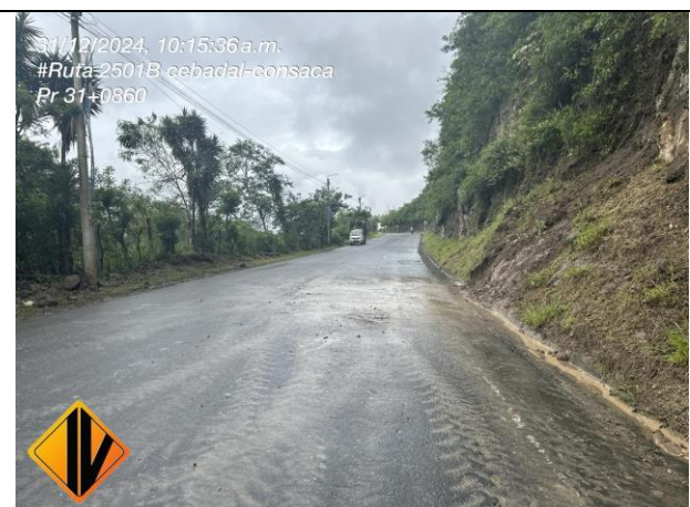
ACTIVIDAD REMOCIÓN DE ROCA Y MATERIAL DE DERRUMBE SOBRE LA CALZADA PR 29+0750, PR29+0870, PR31+0860 (RECURSOS AMV) RUTA 2501B CEBADAL – SANDONA – SANTA BARBARA
