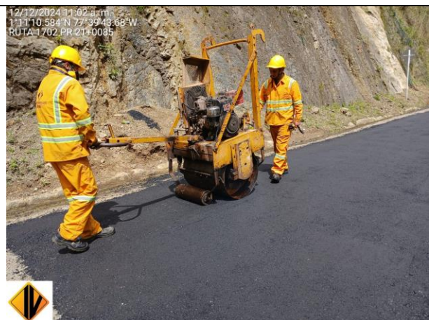
ACTIVIDAD INSTALACIÓN DE MEZCLA ASFÁLTICA PR 21+0085 – CONTRATO 4142 DE 2024 RUTA 1702 TUQUERRES - SAMANIEGO
