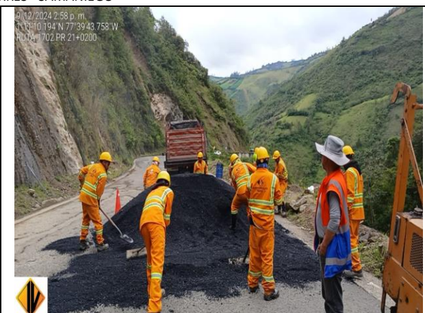
ACTIVIDAD INSTALACIÓN DE MEZCLA ASFÁLTICA PR 21+0200 – CONTRATO 4142 DE 2024 RUTA 1702 TUQUERRES - SAMANIEGO
