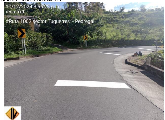
ACTIVIDAD INSPECCIÓN PINTURA SEÑALIZACIÓN HORIZONTAL EN SITIO ALTA ACCIDENTALIDAD –LEYENDA DESPACIO PR32+0360 Y LINEAS REDUCTORAS DE VELOCIDAD PR32+0241 – 32+0360 (RECURSOS AMV) RUTA 2501B CEBADAL – SANDONA – SANTA BARBARA
