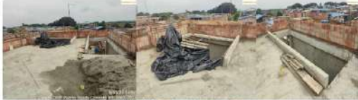
Ilustración 3 Estado actual de las cubiertas
