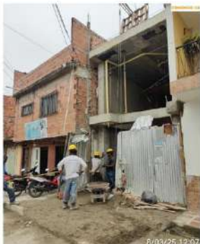
Ilustración 9 Zona de acopio de materiales
