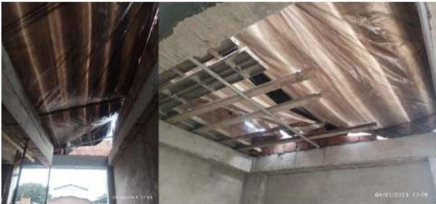
Ilustración 1 Cubierta provisional en polietileno
