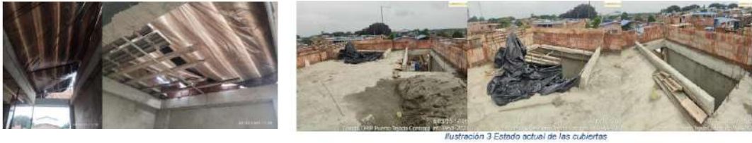
Ilustración 3 Estado actual de las cubiertas
